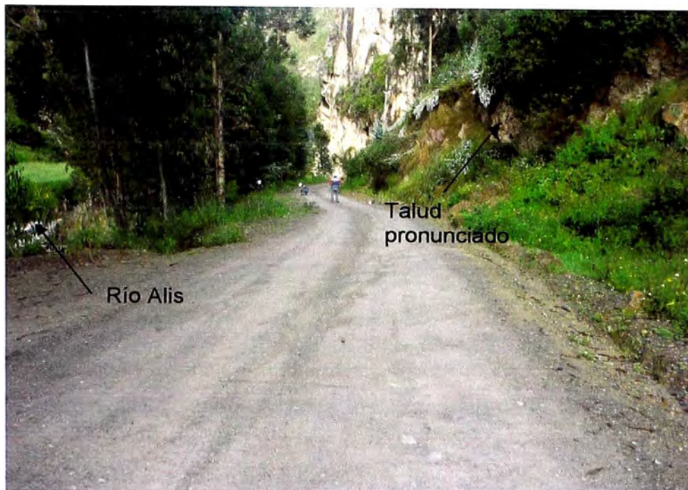
Figura N° 4.1.1.2 Vista de la carretera
