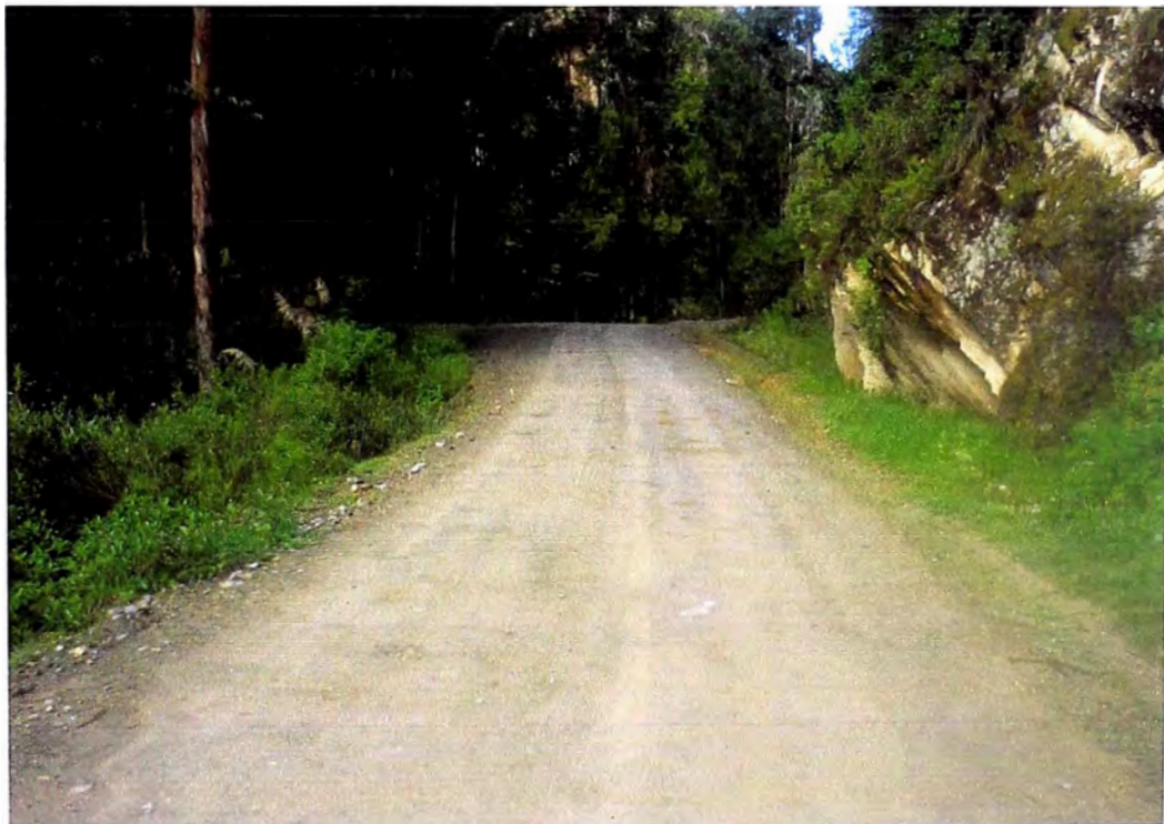
Foto 4. En la foto se observa el ancho variable de la superficie de rodadura
