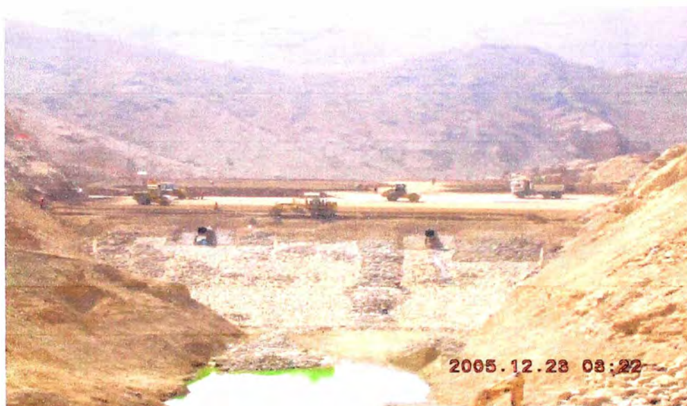
Colocación de Rip Rap paralelo al relleno de la represa
