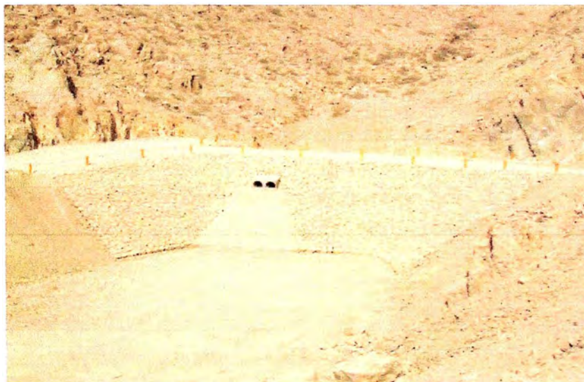
Fig. 11 Dique y Canal de Derivación
