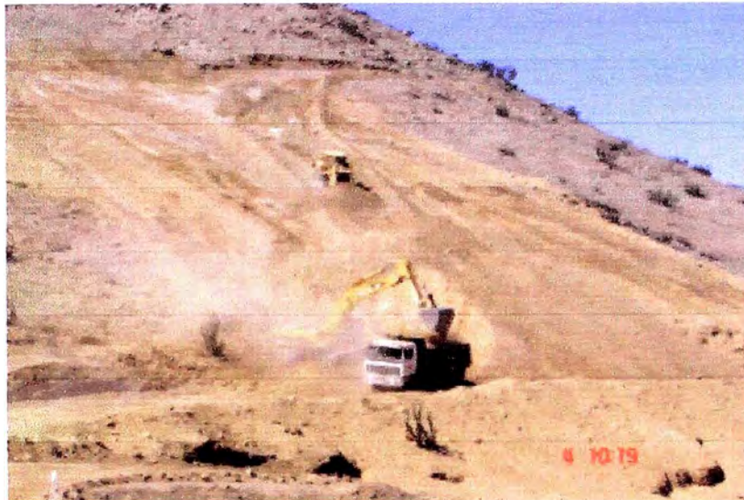
Fig. N 13 Corte de Terreno y Traslado para acopio y preparación
