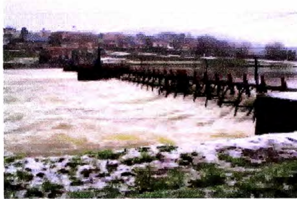
Fig. 4 Presa de derivación
