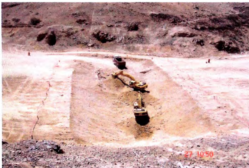
Excavación de núcleo de represa
