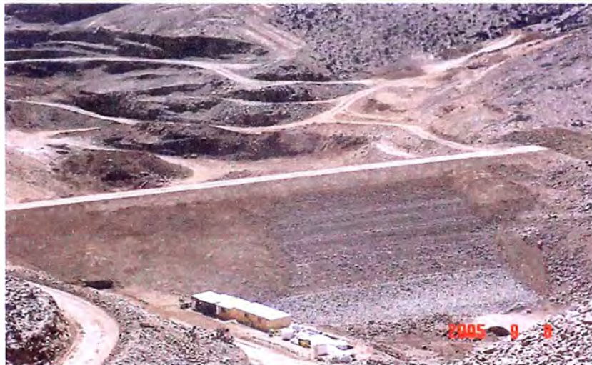
Dique NE Mina culminado
