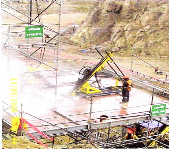
Perforación con equipos Diamec
