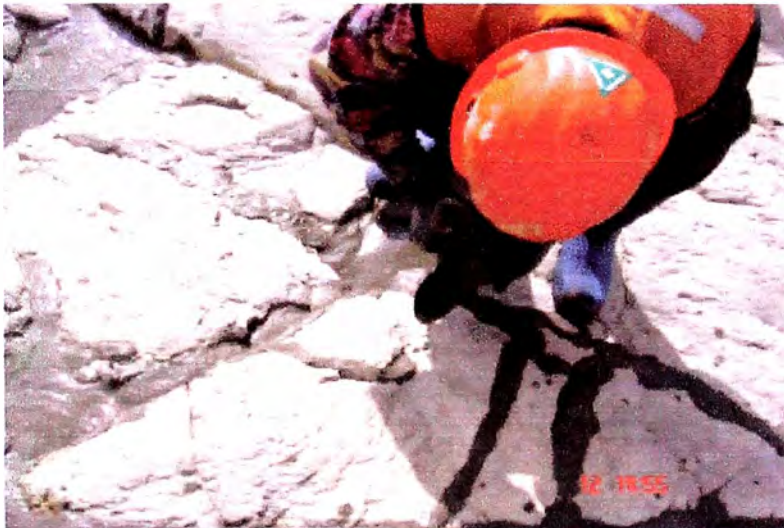
Colocación de Dental Concrete
