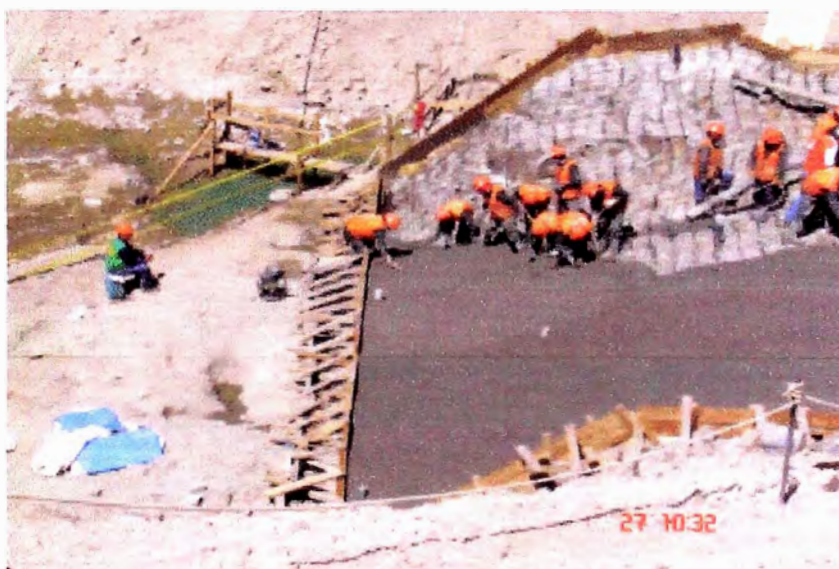
Vaciado de un paño de Grout Cap
