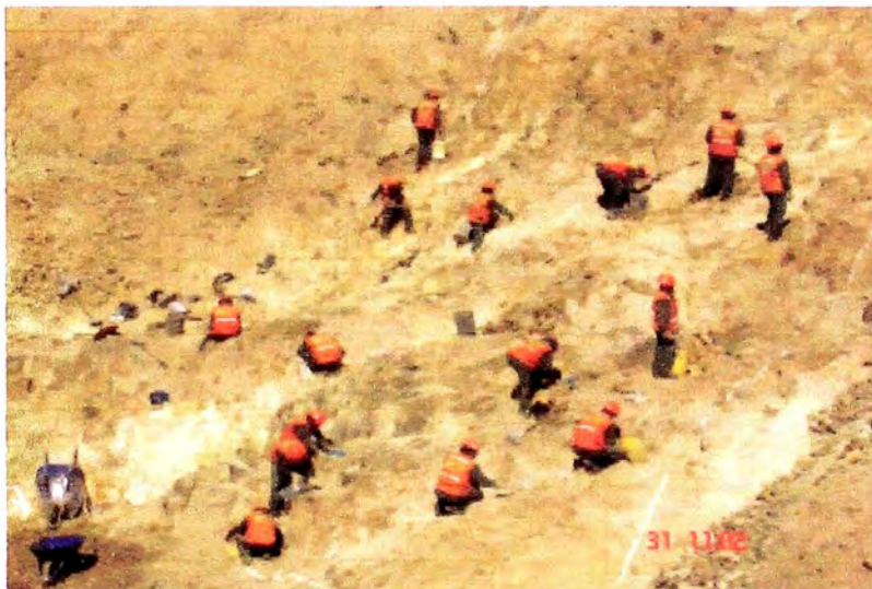
Limpieza manual de lecho rocoso en núcleo de represa
