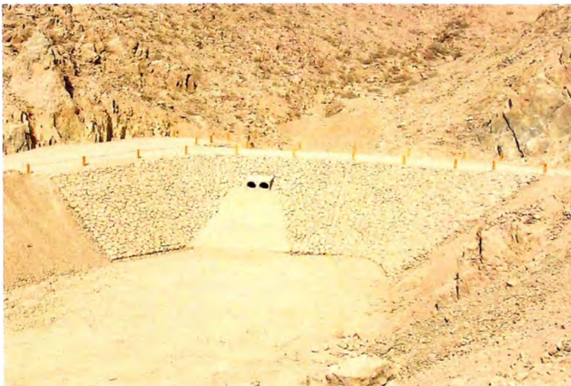
Dique y canal de Derivación culminado
