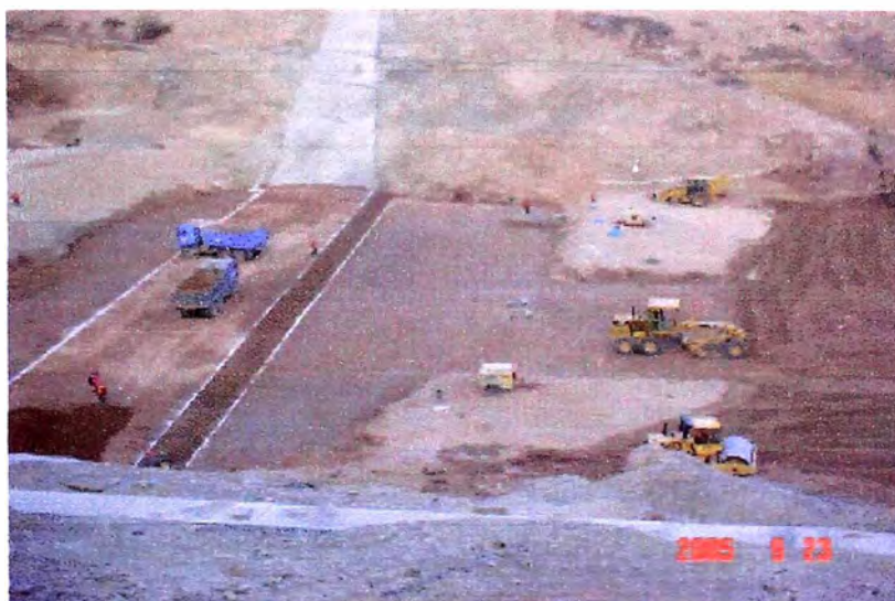
Relleno con equipo pesado
