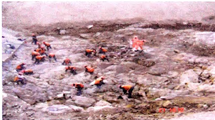
Fig. N 15 Limpieza Manual y con aire comprimido
