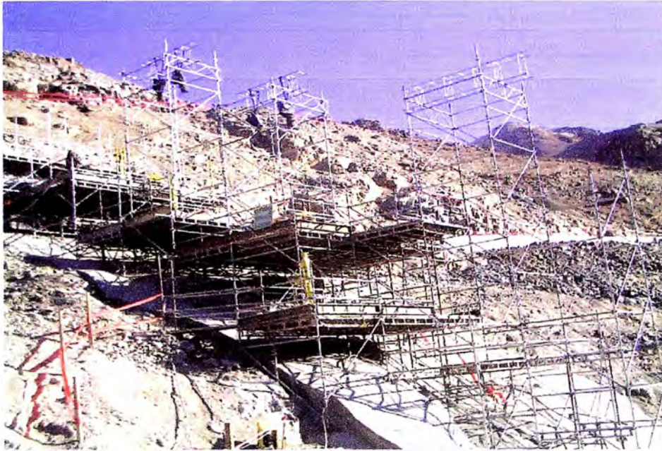
Fig. N 20 : Armado de Andamios para los equipos de perforación
