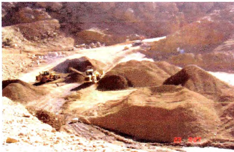
Fig. N 14 Construcción de Pozas superficiales y zarandeo de material
