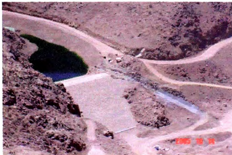
Represa de Sedimentación culminada
