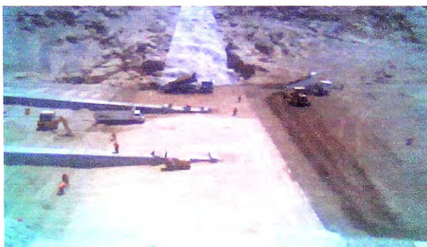
Relleno de Represa (Encima de tubería de HDPE)
