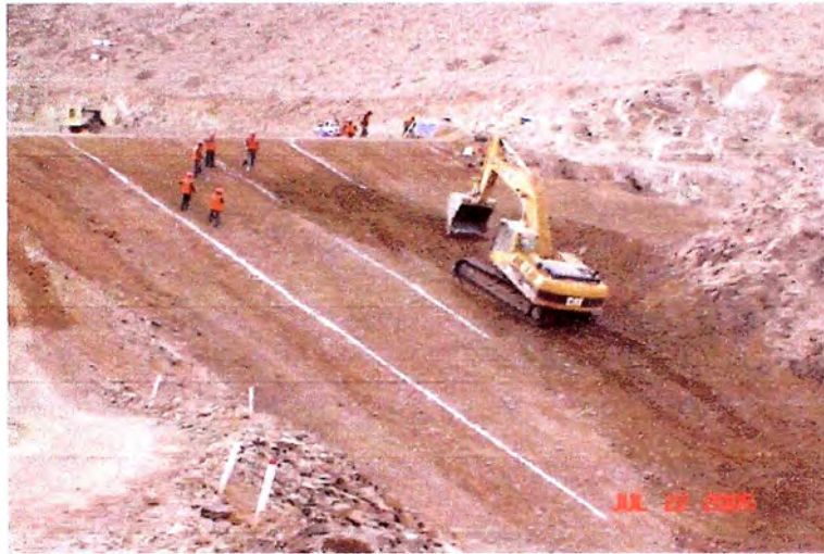
Perfilado de Talud
