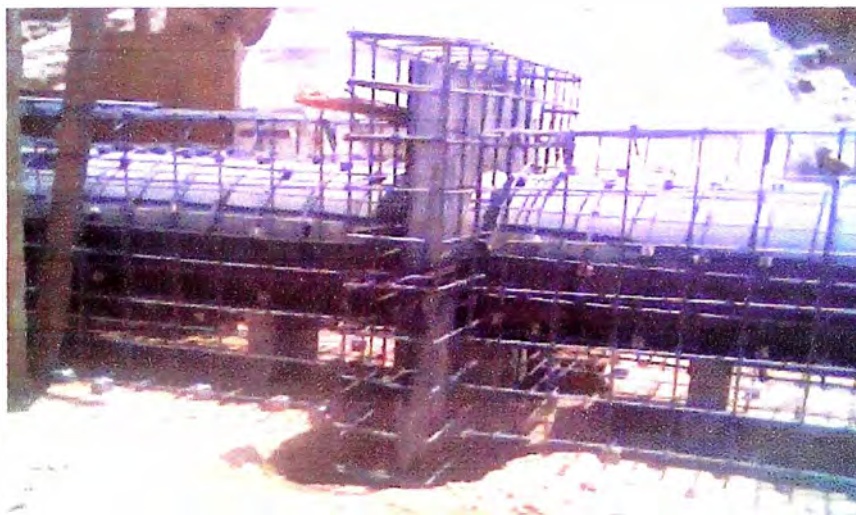
Detalle de refuerzo en tuberías de HDPE
