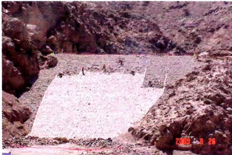
Colocación de Rip Rap
