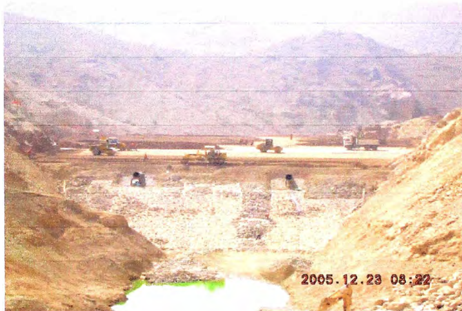
Fig. N 28 : Relleno sobre la tubería de descarga y colocación de rip rap en Represa de PLS
