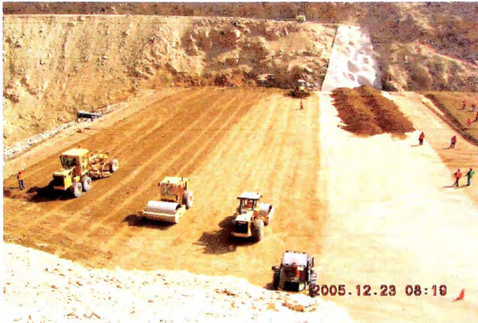
Fig. N 24 Relleno masivo con equipo pesado
