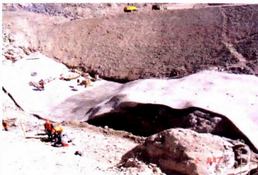
Grout Cap sobre núcleo de represa
