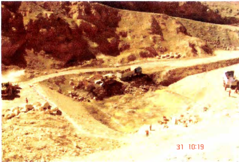
Excavación de Núcleo de Presa
