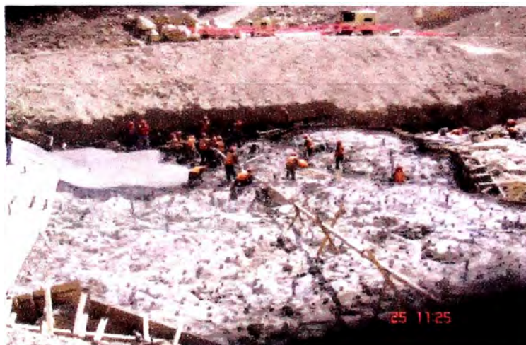
Fig. N 18 Vaciado de un paño de Grout Cap
