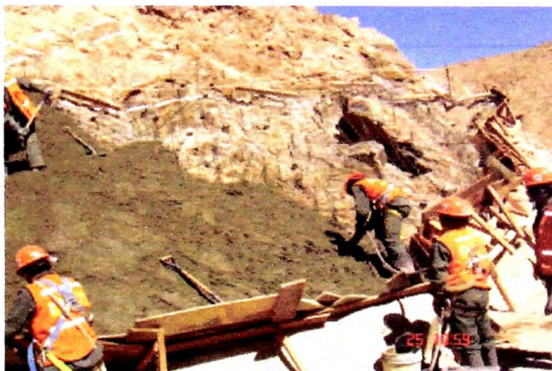
Vaciado de Grou Cap
