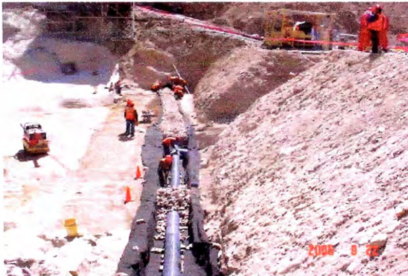
Construcción de Drenaje
