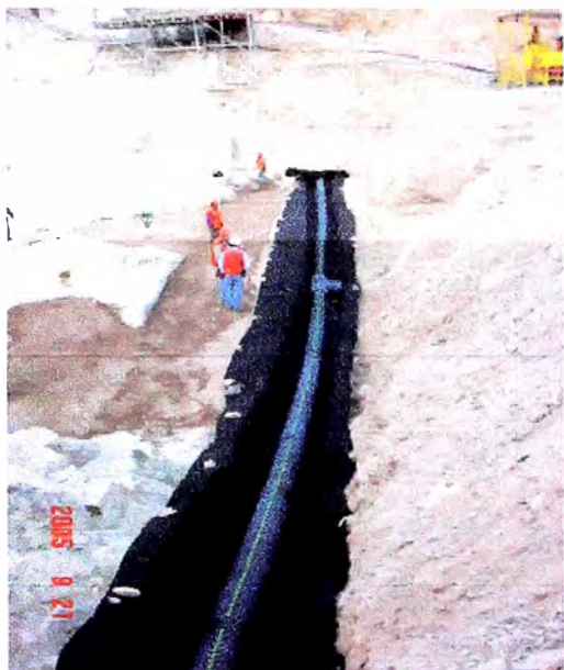
Fig. N 25 Drenaje de la Represa de PLS
