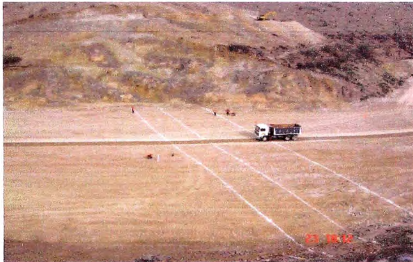
Trazo de núcleo de represa
