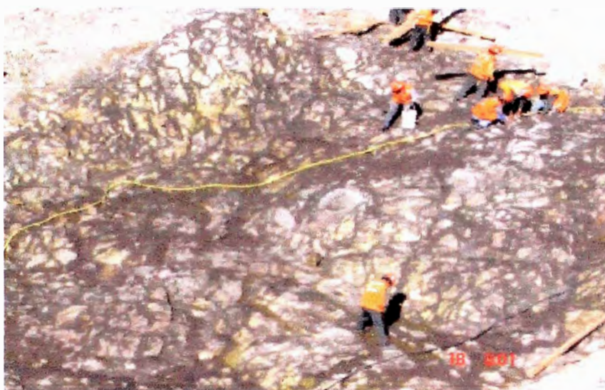
Colocación manual de Dental Concrete
