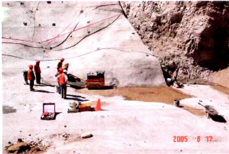
Fig. N 35 Relleno con equipo menor en zona irregular
