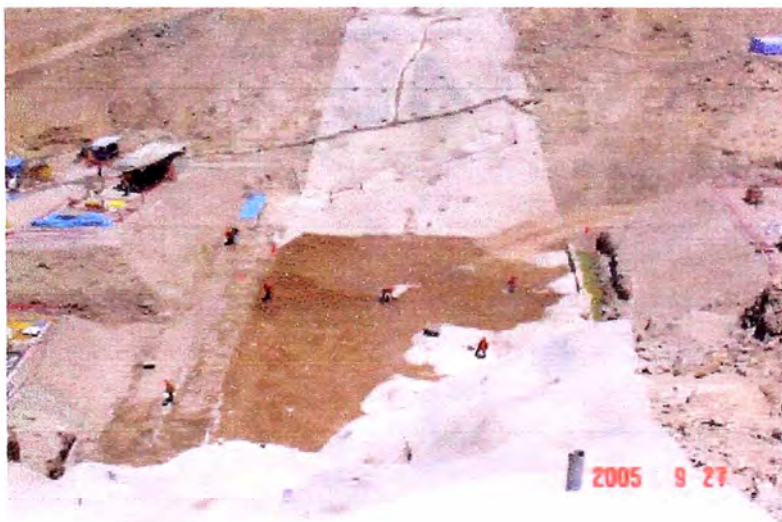
Primeras capas de relleno con equipo menor
