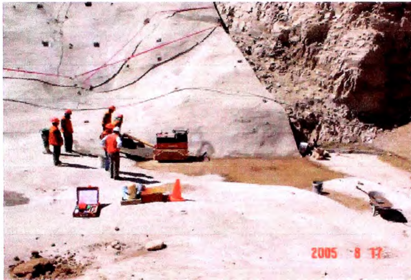
Primeras capas de relleno con equipo menor
