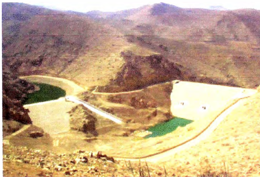
Fig. N 29 Represa de Sedimentación y PLS culminadas
