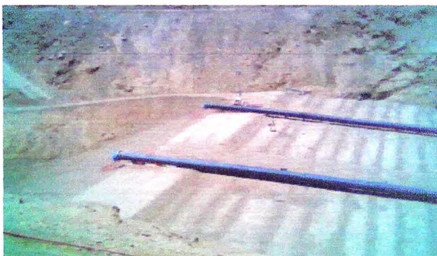
Tendido de Tubería de HDPE de 42"
