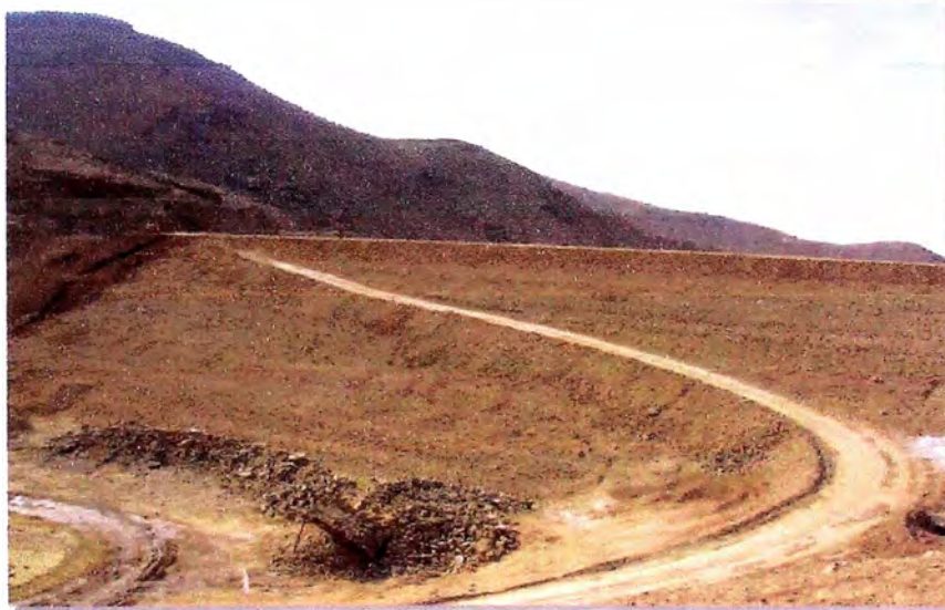
Relleno de Represa de Retención de Avenidas culminada
