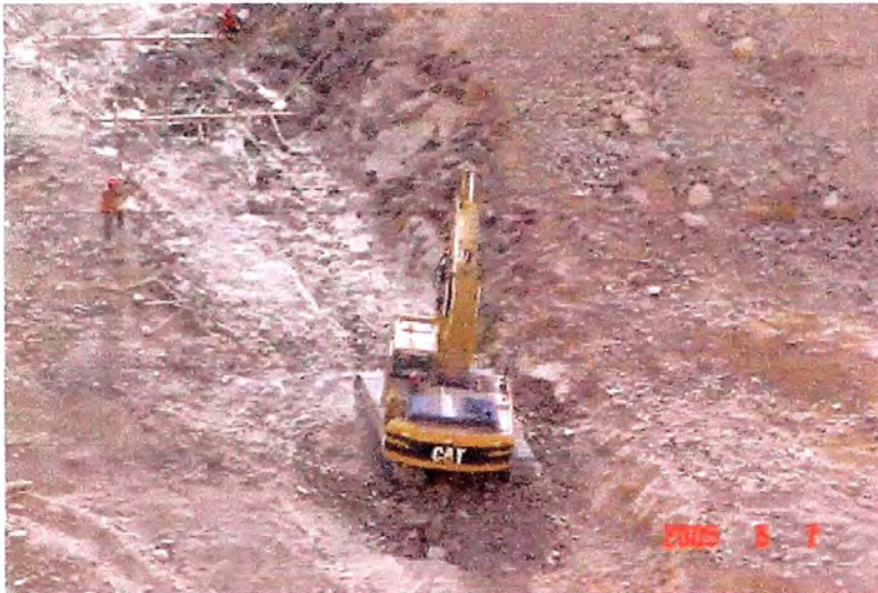
Excavación en roca para vertedero
