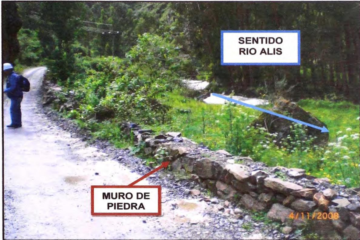
Foto N°3: Muro de piedra usado como guardavía provisional
