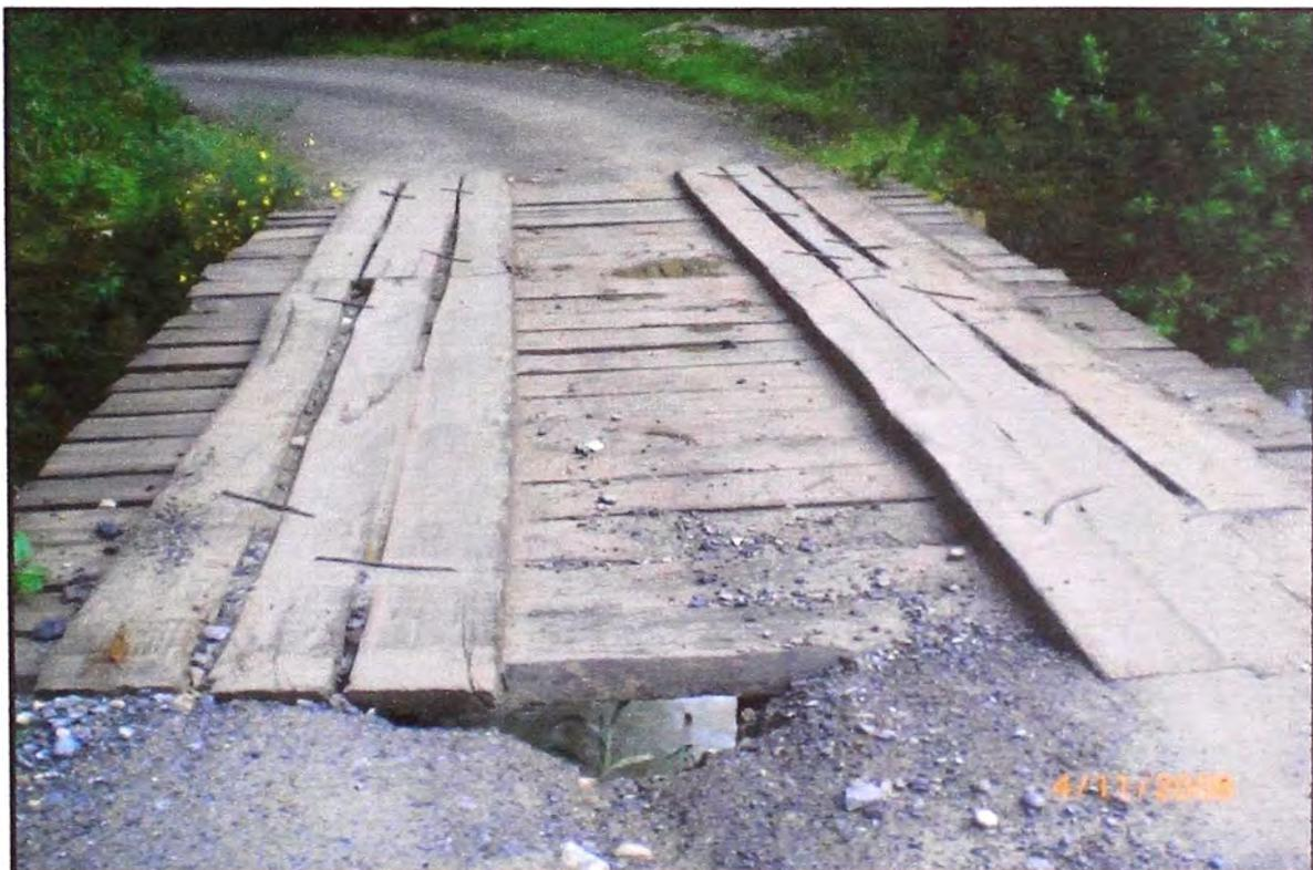
Foto N°7: Pontón de madera (se cambiará a concreto)
