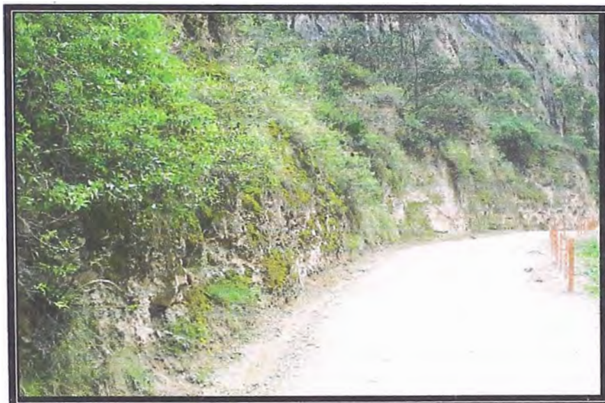
FIGURA N° II-04 PRESENCIA DE VEGETACIÓN Y ARBOLES DE EUCALIPTOS
