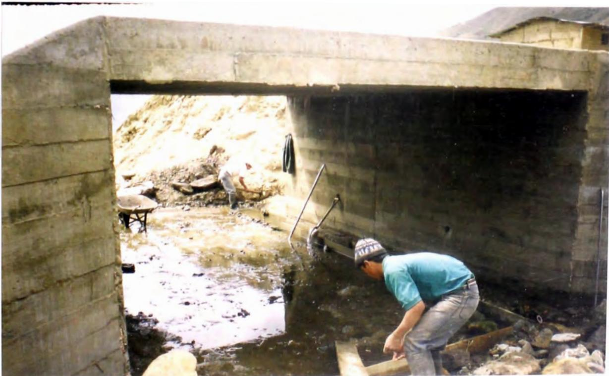
**FOTO N° 40: PREPARACIÓN DE LA CAMA DE PIEDRA A LA SALIDA DEL PONTON**
