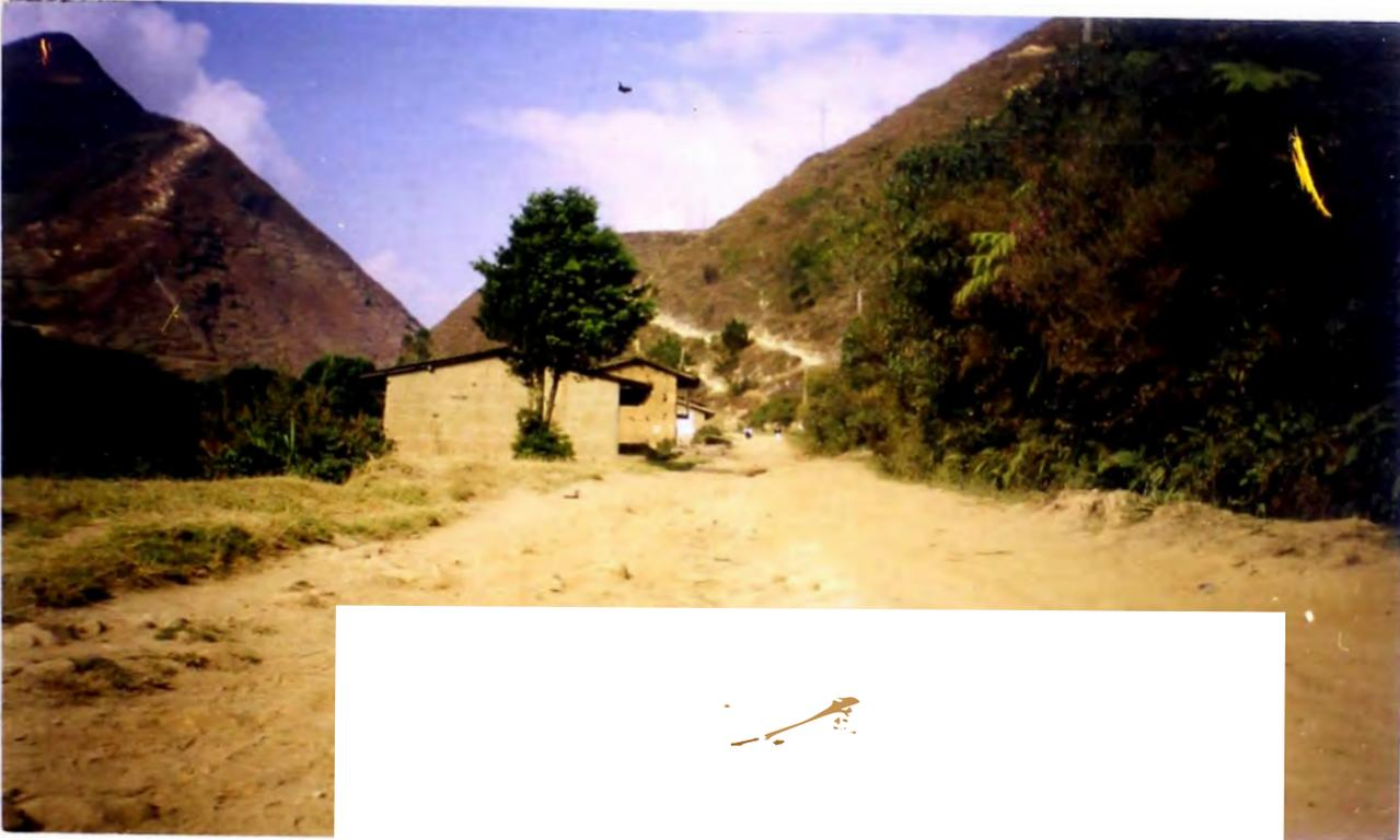
**FOTO N° 01: PROGRESIVA (5 + 800) SUPERFICIE DE RODADURA COMPUESTA DE MATERIAL SUELTO, INADECUADO PARA EL LASTRADO**
