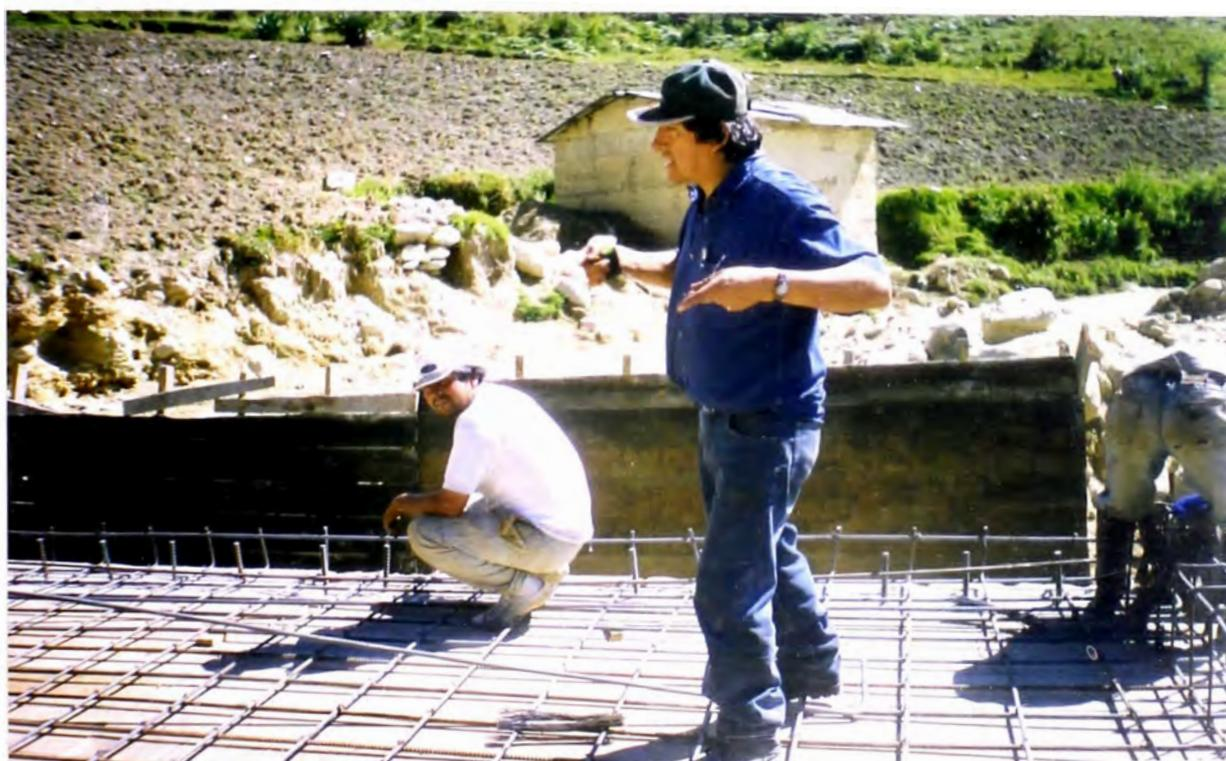
**FOTO N° 34: ING. RESIDENTE DANDO LAS INDICACIONES RESPECTIVAS A SU GENTE EN EL ARMADO DE LA MALLA PARA LA LOSA DEL PONTON**
