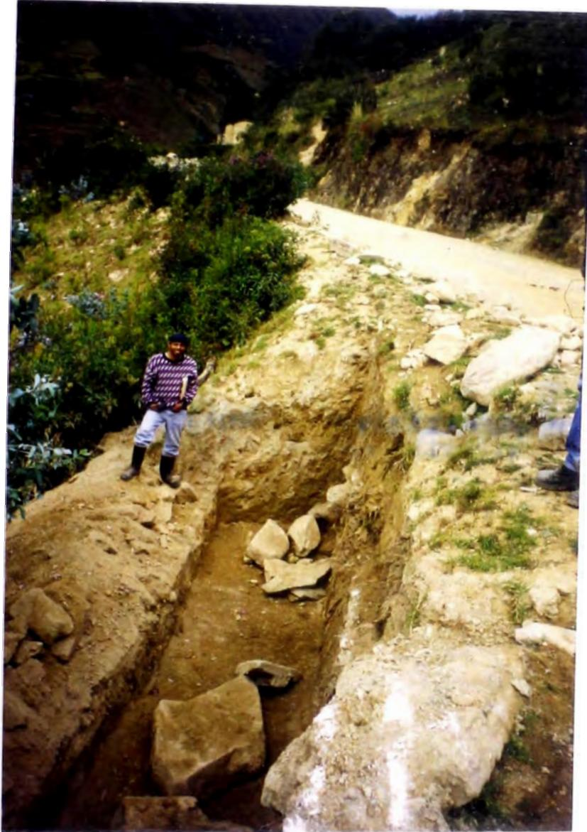
**FOTO N° 45: EXCAVACIÓN DEL MURO DE SOSTENIMIENTO DE LA PROGRESIVA (9 + 300)**
