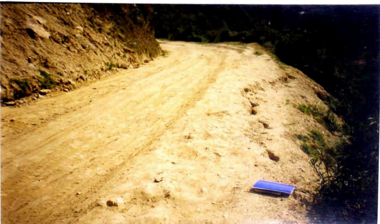
**FOTO N° 02: PROGRESIVA (6 + 984) OBSERVESE LA ENORME FISURA EN LA PLATAFORMA, AQUÍ ES NECESARIO UN MURO DE SOSTENIMIENTO**
