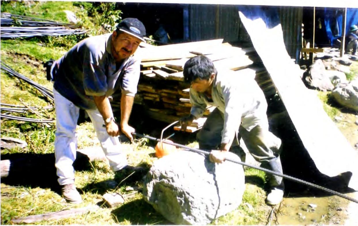
**FOTO N° 29: CORTE DEL FIERRO DE 5/8" QUE SERÁ UTILIZADO PARA ARMAR LA LOSA DEL PONTON N° 04**
