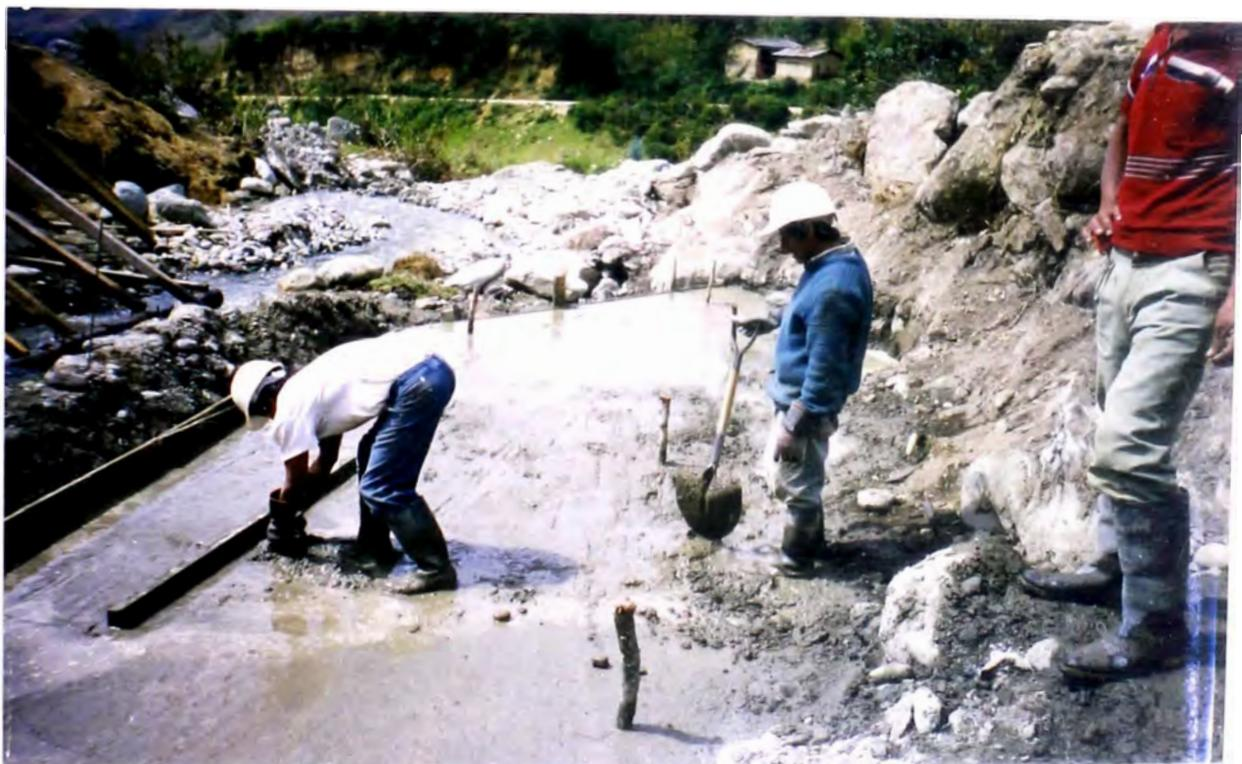
**FOTO N° 22: TERMINACIÓN DE LA ZAPATA DEL CUARTO PONTON, SOBRE ELLA IRA EL RESPECTIVO ESTRIBO**
