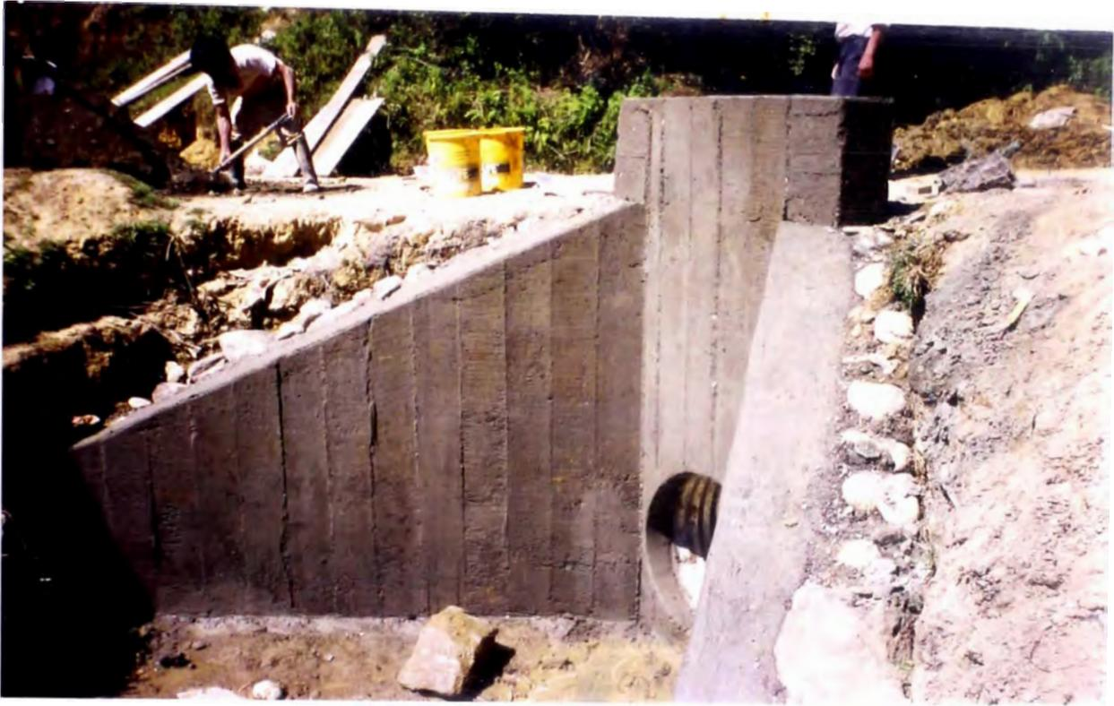
**FOTO N° 08: CABEZAL CON ALEROS DE ALCANTARILLA T.M.C. DE 36" YA TERMINADA, PROGRESIVA (14 + 630)**
