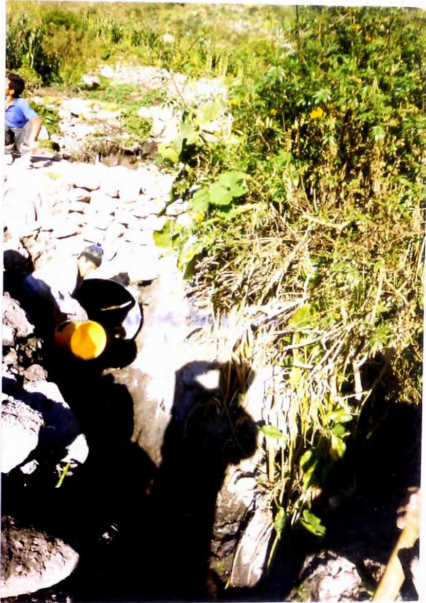
**FOTO N° 17: T.M.C. DE 36" PROGRESIVA (13 + 730), EL T.M.C. ES FIJADO TEMPORALMENTE CON PIEDRAS, LUEGO SE VACIARA EL CABEZAL DE CONCRETO**
