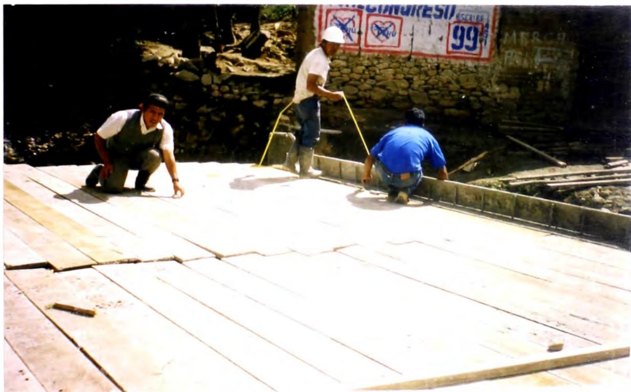
**FOTO N° 32: SUPERVISIÓN VERIFICANDO LA HORIZONTABILIDAD DEL ENCOFRADO SOBRE EL CUAL IRA LA LOSA DEL PONTON**
