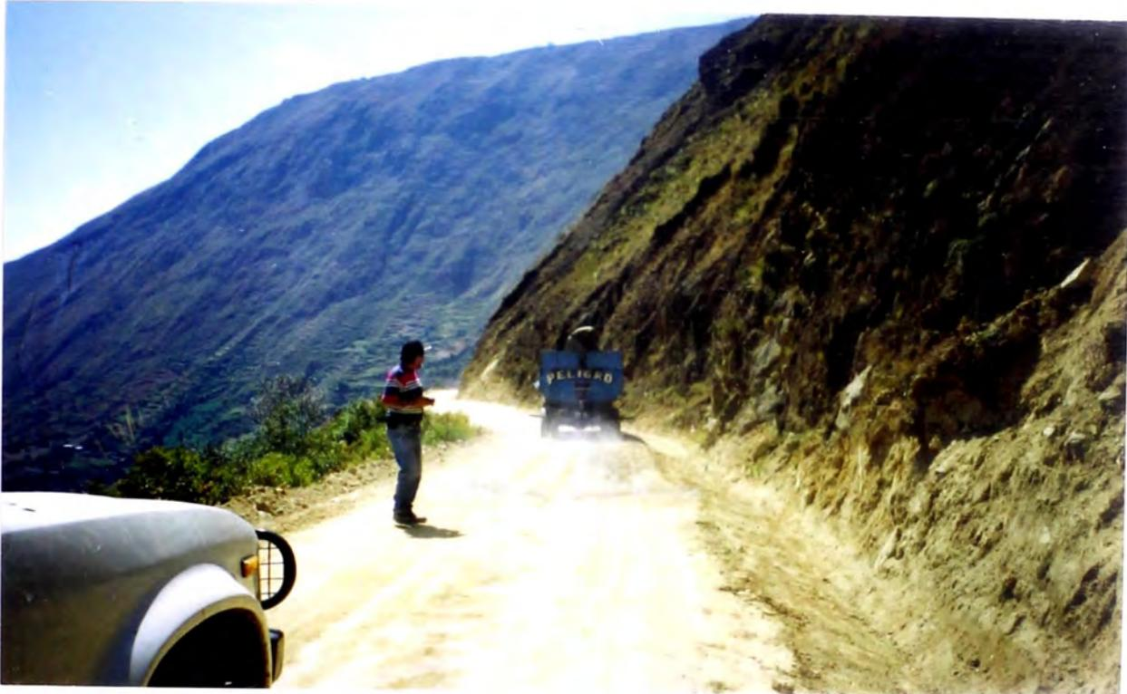
**FOTO N° 07: CAMION CISTERNA, FUE NECESARIA MUCHA AGUA YA QUE EL CALOR EVAPORAVA RAPIDO EL AGUA PARA LA COMPACTACION**
