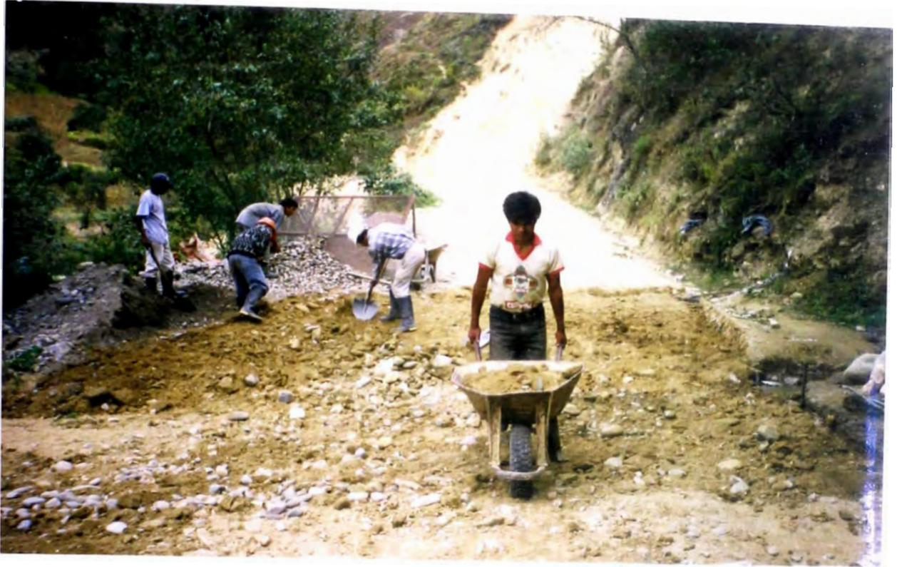
**FOTO N° 43: SELECCIÓN DEL HORMIGÓN PARA EL CONCRETO DE LOS BADENES, NOTESE LA MALLA RESPECTIVA.**
