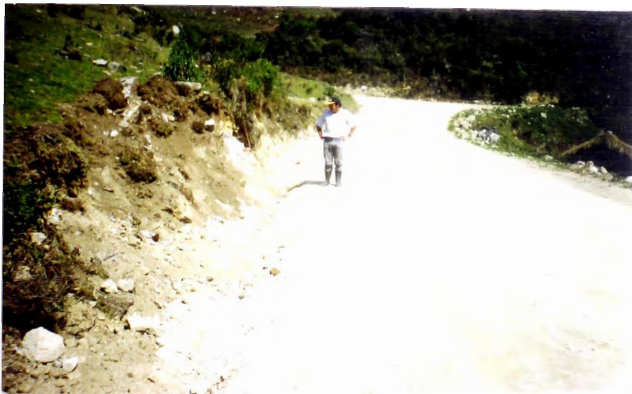
**FOTO N° 02: LA SUPERVISIÓN VERIFICANDO LAS CUNETAS DE TIERRA, NOTESE TAMBIEN LA COMPACTACIÓN DEL MATERIAL**
