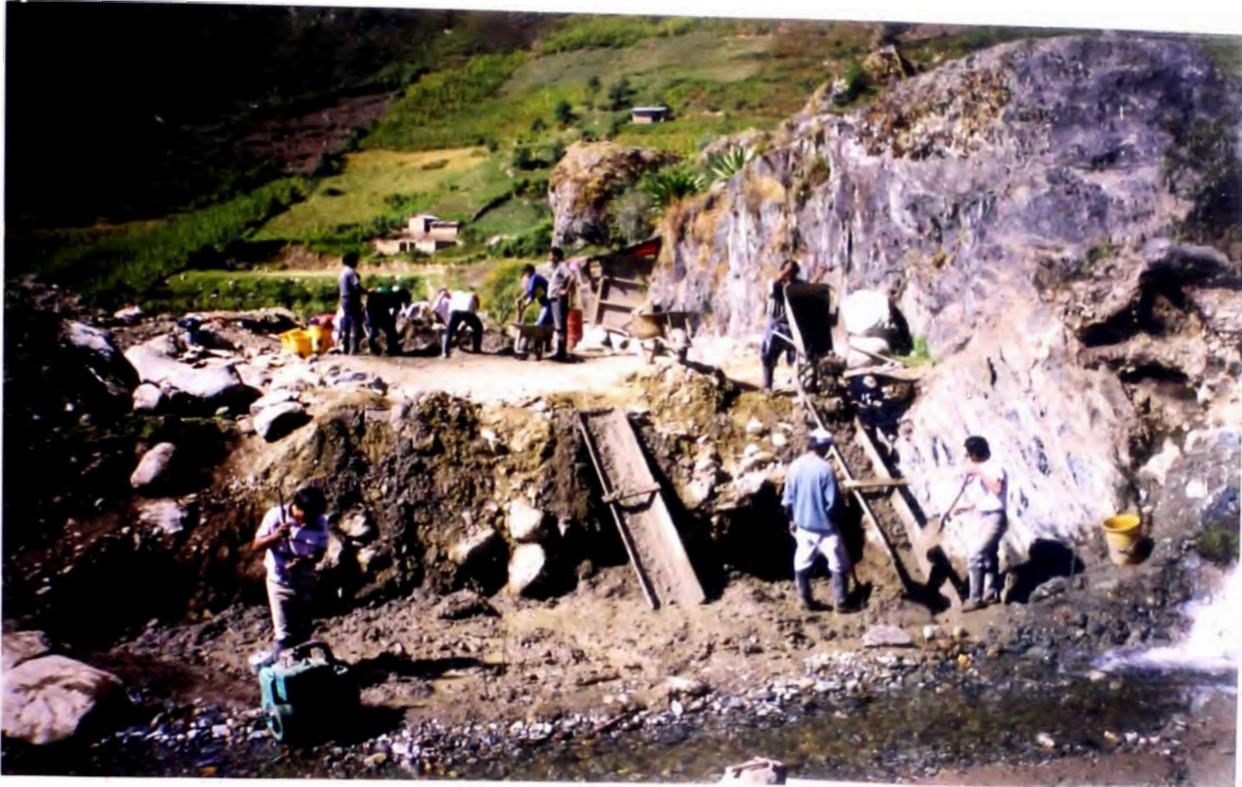
**FOTO N° 21: VACIADO DEL CONCRETO  $f'c = 140 \text{ kg/cm}^2$  PARA LA ZAPATA DEL CUARTO PONTON**
