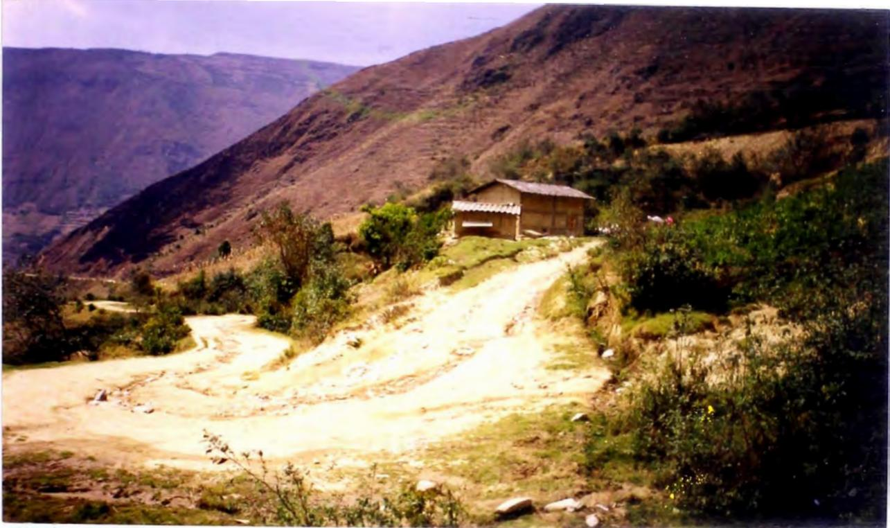
**FOTO N° 03: PROGRESIVA (10 + 505) CURVA SIN BOMBEO EN CONDICIONES DESASTROSAS**
