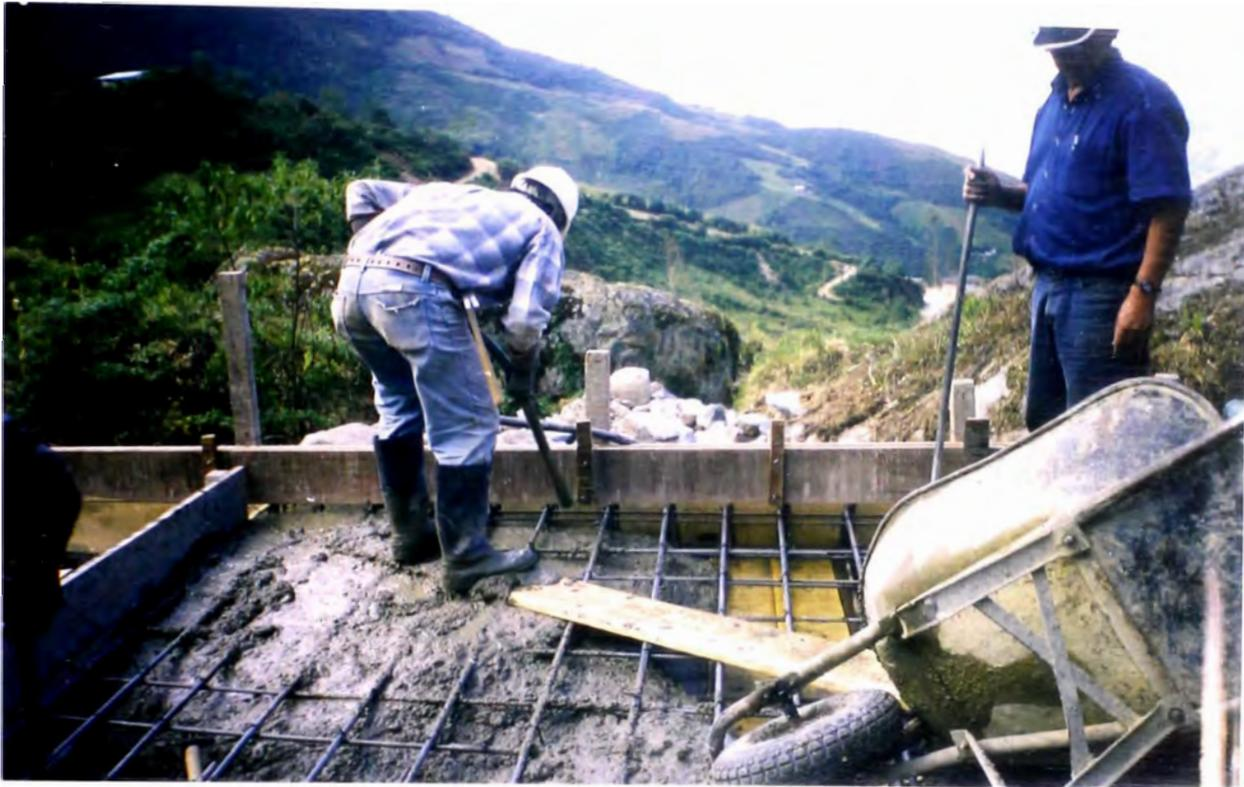
**FOTO N° 35: VACIADO DEL CONCRETO, PARA LA LOSA DEL TERCER PONTON EN LA PROGRESIVA (13 + 609), NOTESE EL USO DEL VIBRADOR PARA EVITAR CANGREJERAS.**
