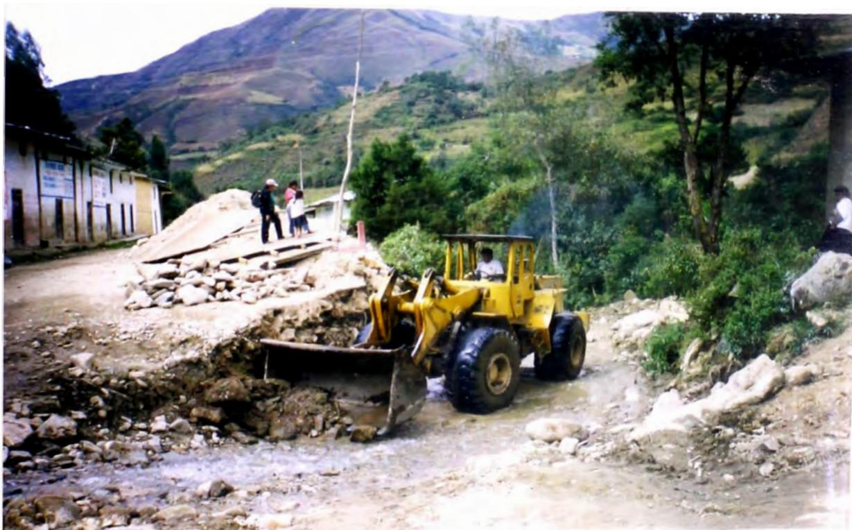
**FOTO N° 20: CARGADOR FRONTAL, EXCAVANDO DONDE IRA EL PRIMER PONTON EN LA LOCALIDAD DE RURIMAYO (6 + 425)**
