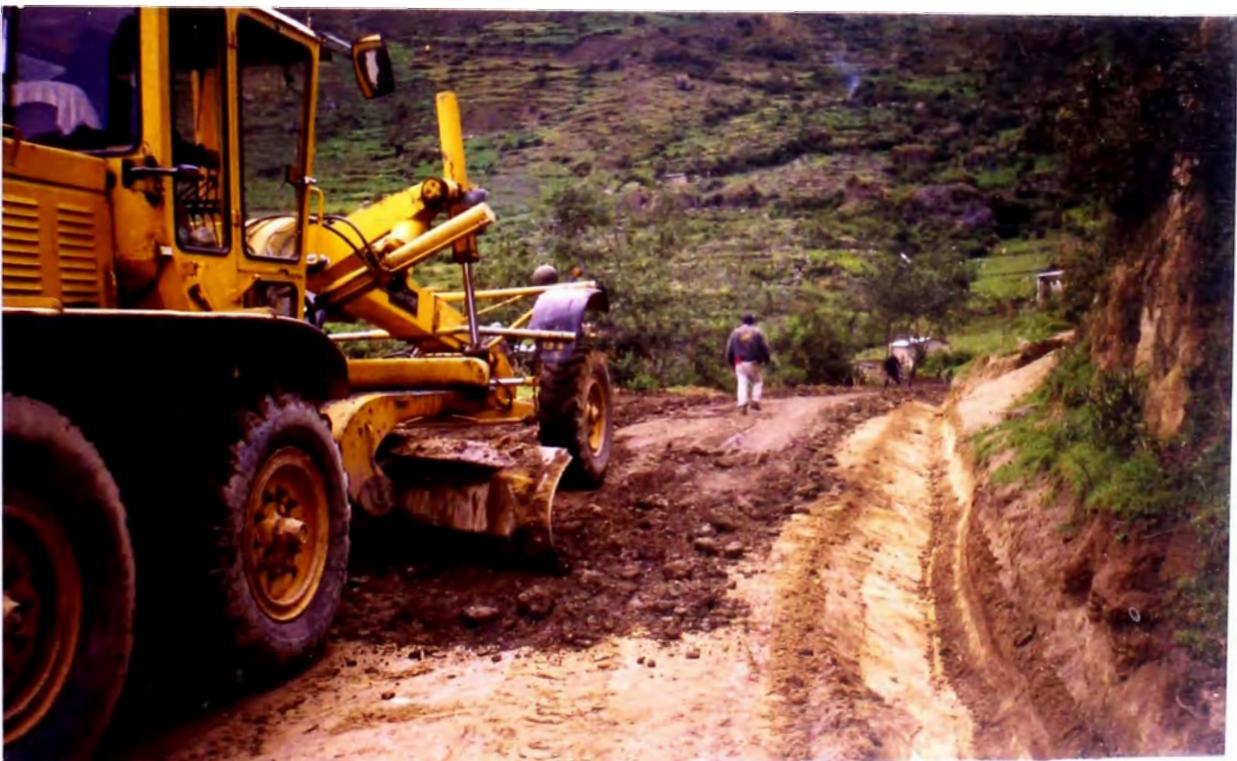
**FOTO N° 06: MOTONIVELADORA ESPARCIENDO EL MATERIAL DE CANTERA SOBRE LA PROGRESIVA (13 + 720)**
