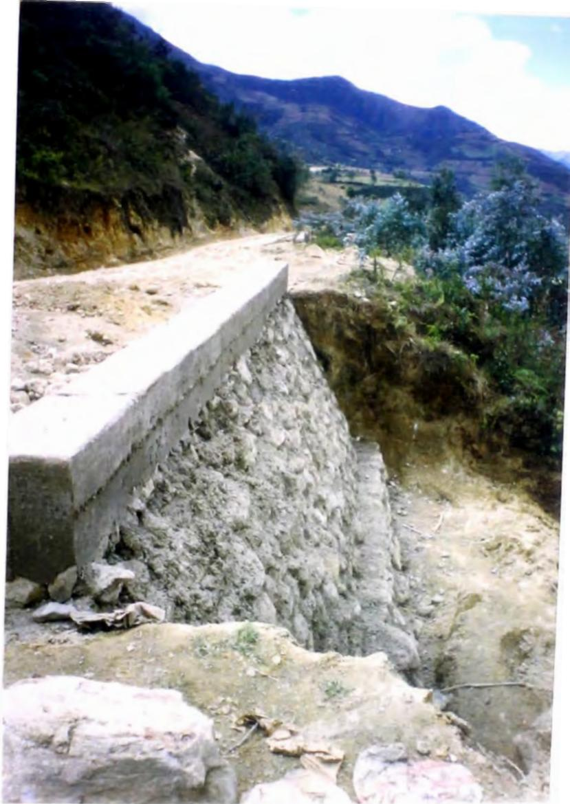
**FOTO N° 17: MURO DE CONTENCIÓN SOBRE LA PROGRESIVA (9 + 300), ESTAS CONSTITUYERON OBRAS ADICIONALES.**
