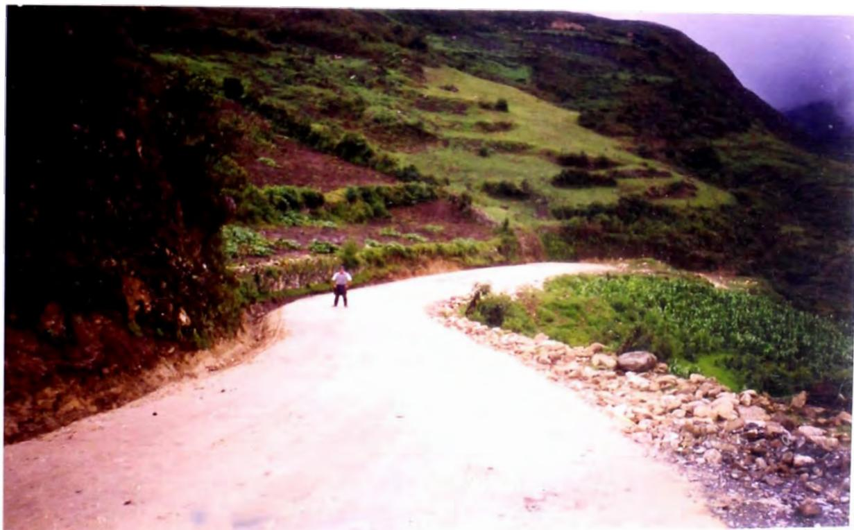
**FOTO N° 04: ESTADO FINAL DE LA COMPACTACION DEL MATERIAL DE LASTRADO, PROGRESIVA (15 + 520)**
