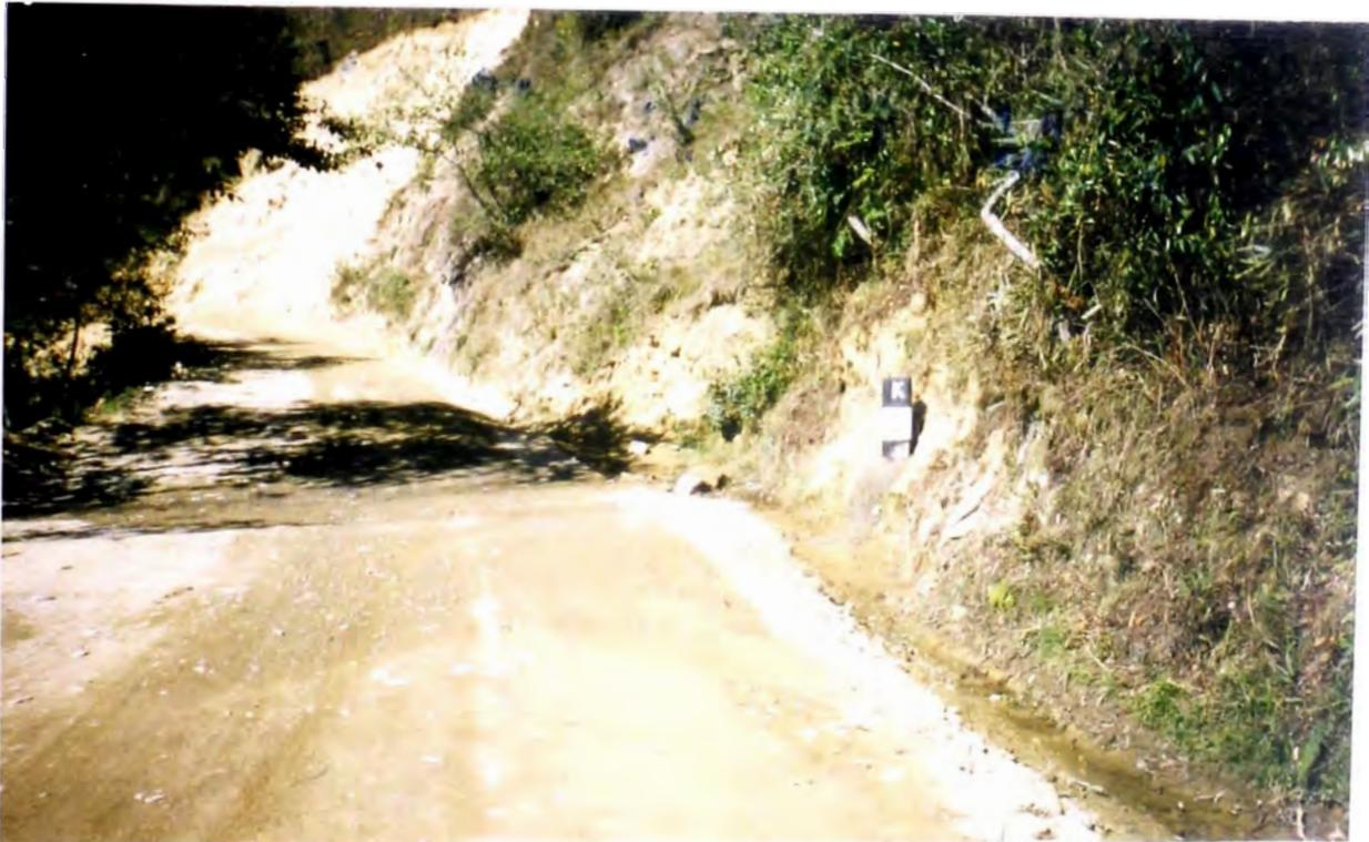
**FOTO N° 15: HITO KILOMETRICO N° 06, NOTESE LA CUNETA DE TIERRA AL PIE DEL TALUD.**
