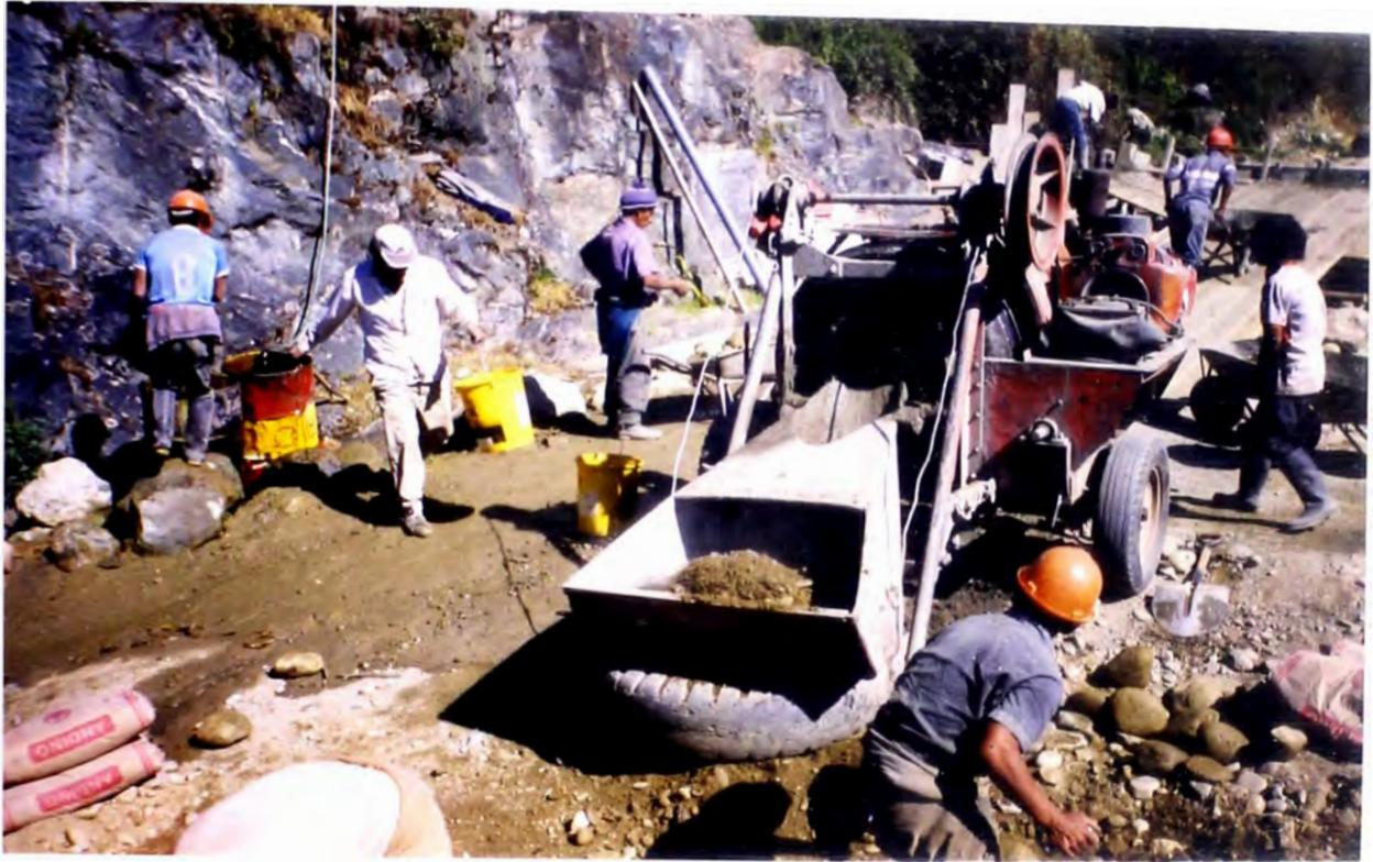
**FOTO N° 23: PARTIDA 5.01.05 PREPARACION DEL CONCRETO PARA LA LOSA DEL PONTON.**
