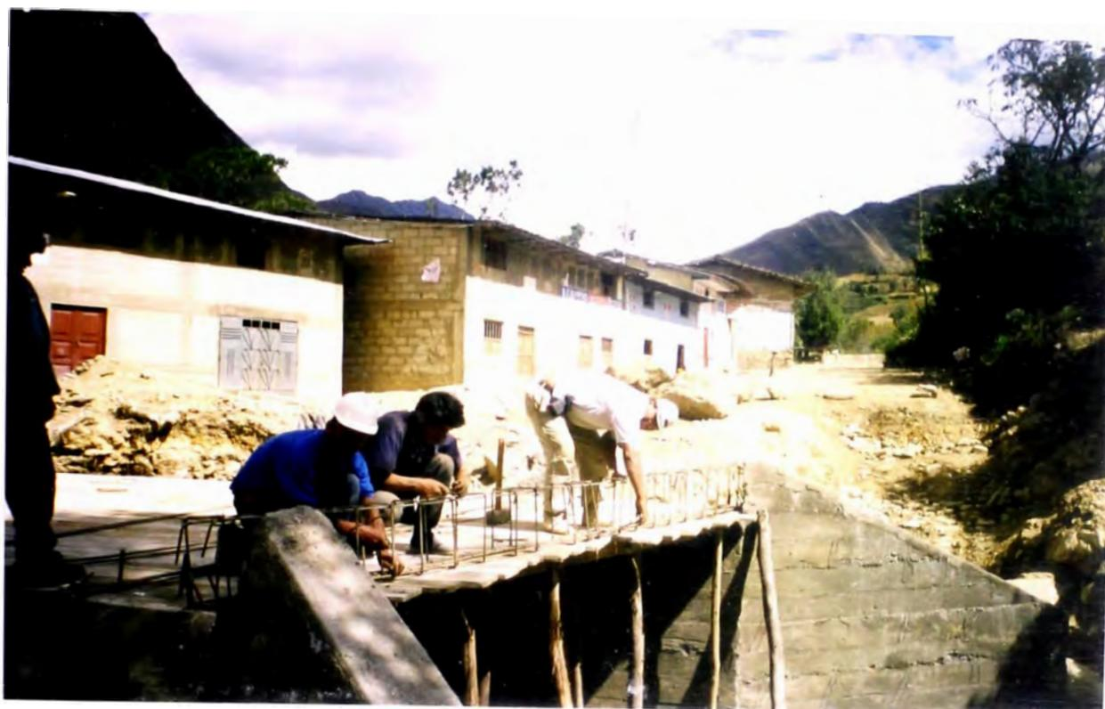
**FOTO N° 33: ARMADO DE LAS VIGAS LATERALES DE LA LOSA DEL PONTON**
