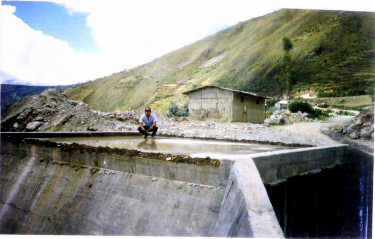
**FOTO N° 39: SUPERVISIÓN VERIFICANDO EL CURADO DEL CONCRETO PARA LA LOSA DEL CUARTO PONTON**
