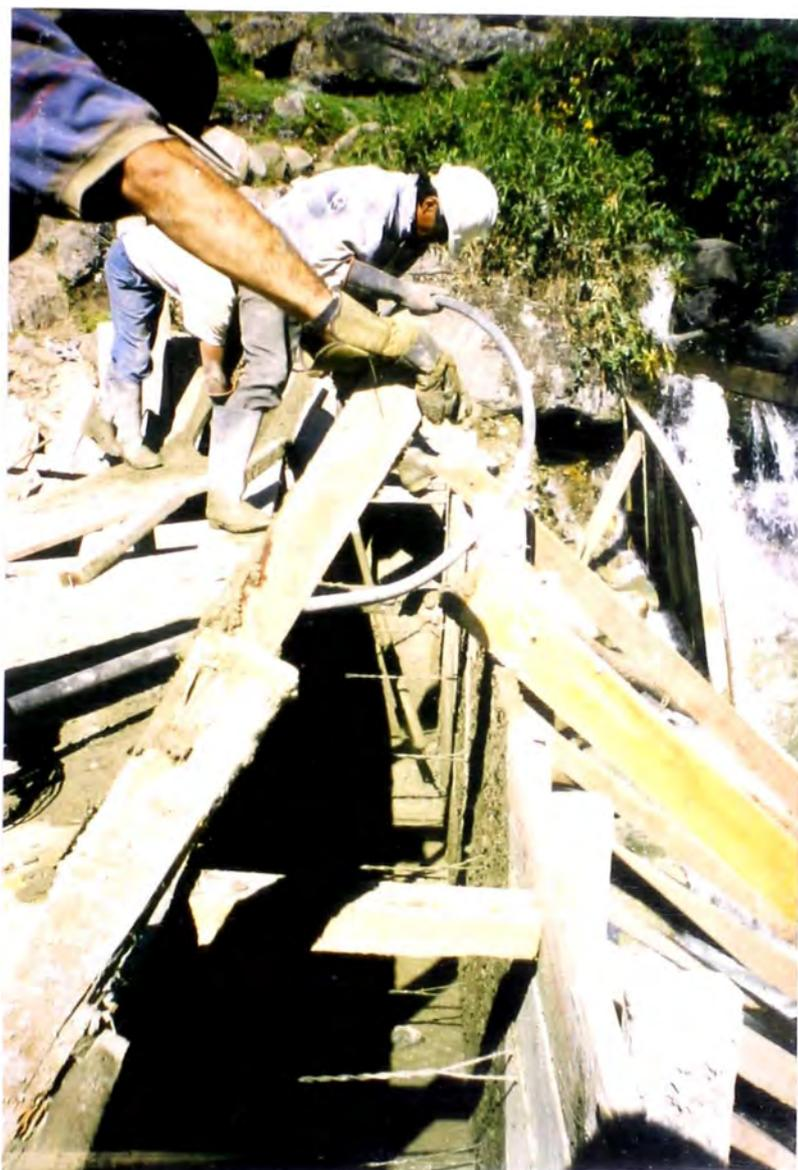
**FOTO N° 38: COLOCACIÓN DEL CONCRETO PARA LOS ESTRIBOS LOS OBREROS LLEVAN: CASCO, GUANTES Y BOTAS**
