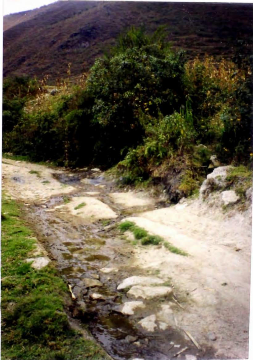
**FOTO N° 11: PROGRESIVA (13+920), NOTESE COMO EL AGUA A LAVADO EL MATERIAL DE LA PLATAFORMA**
