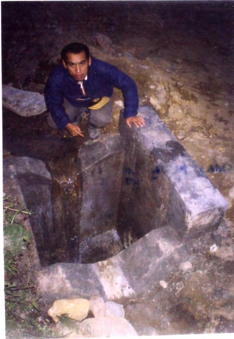
**FOTO N° 07: PROGRESIVA (10 + 615), CAJA RECEPTORA PARA LA ALCANTARILLA T.M.C.**
