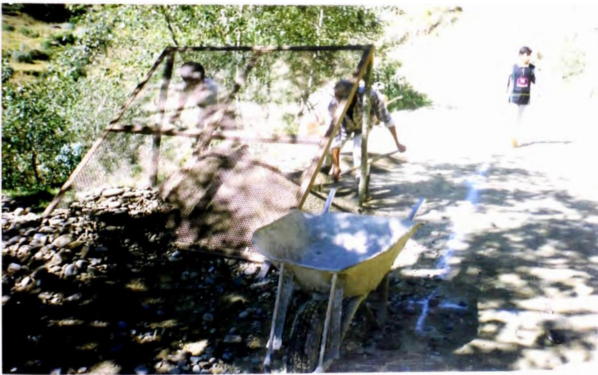
**FOTO N° 28: SELECCIÓN DEL HORMIGÓN PARA LA LOSA DEL PONTON, NOTESE EL USO DE LA MALLA PARA LA SELECCIÓN**
