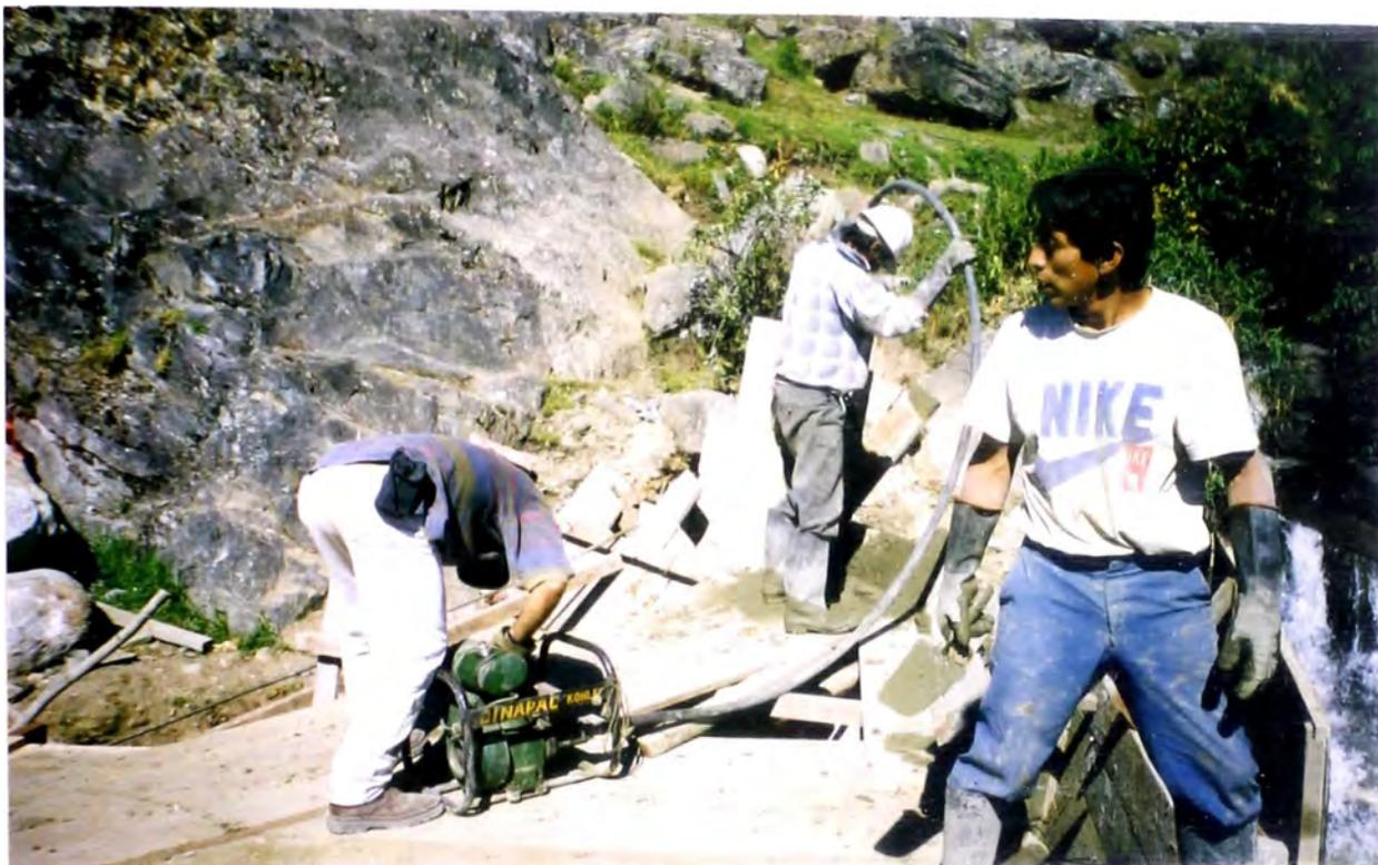
**FOTO N° 31: VIBRADOR UTILIZADO PARA LA COLOCACIÓN DEL CONCRETO, DE LOS ESTRIBOS DEL PONTON (UBICADO DEBAJO DE LOS OBREROS)**
