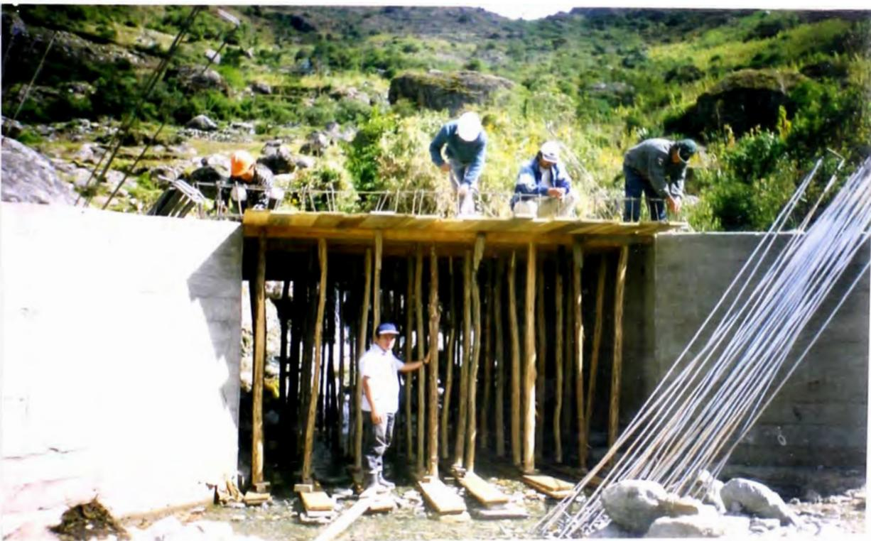
**FOTO N° 26: ENCOFRADO DE LA LOSA DEL SEGUNDO PANTON, OBSERVESE EL ARMADO DE LAS VIGAS LATERALES DE LA LOSA.**
