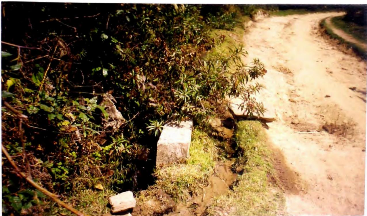
**FOTO N° 04: PROGRESIVA (11 + 188) UNA DE LAS POCAS ALCANTARILLAS EXISTENTES QUE DEBEN LIMPIARSE Y RESANARSE**
