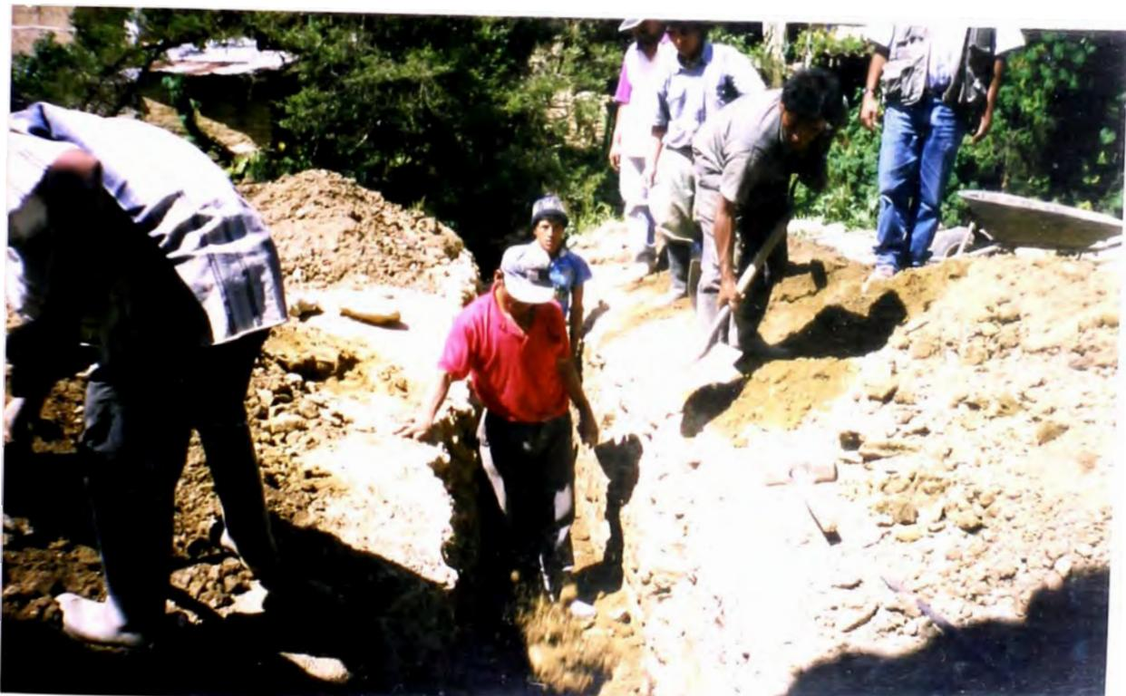
**FOTO N° 16: RELLENO DE LA ALCANTARILLA T.M.C., LA FOTO NO LO MUESTRA PERO EL TUBO ESTA ENTERRADO**
