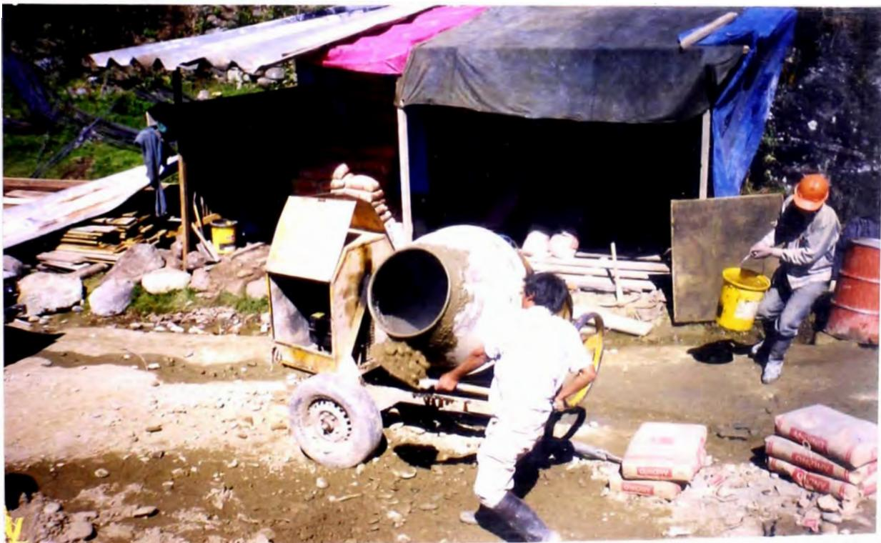
**FOTO N° 24: PARTIDA 5.01.05 PREPARACION DEL CONCRETO PARA LA LOSA DEL PONTON**
