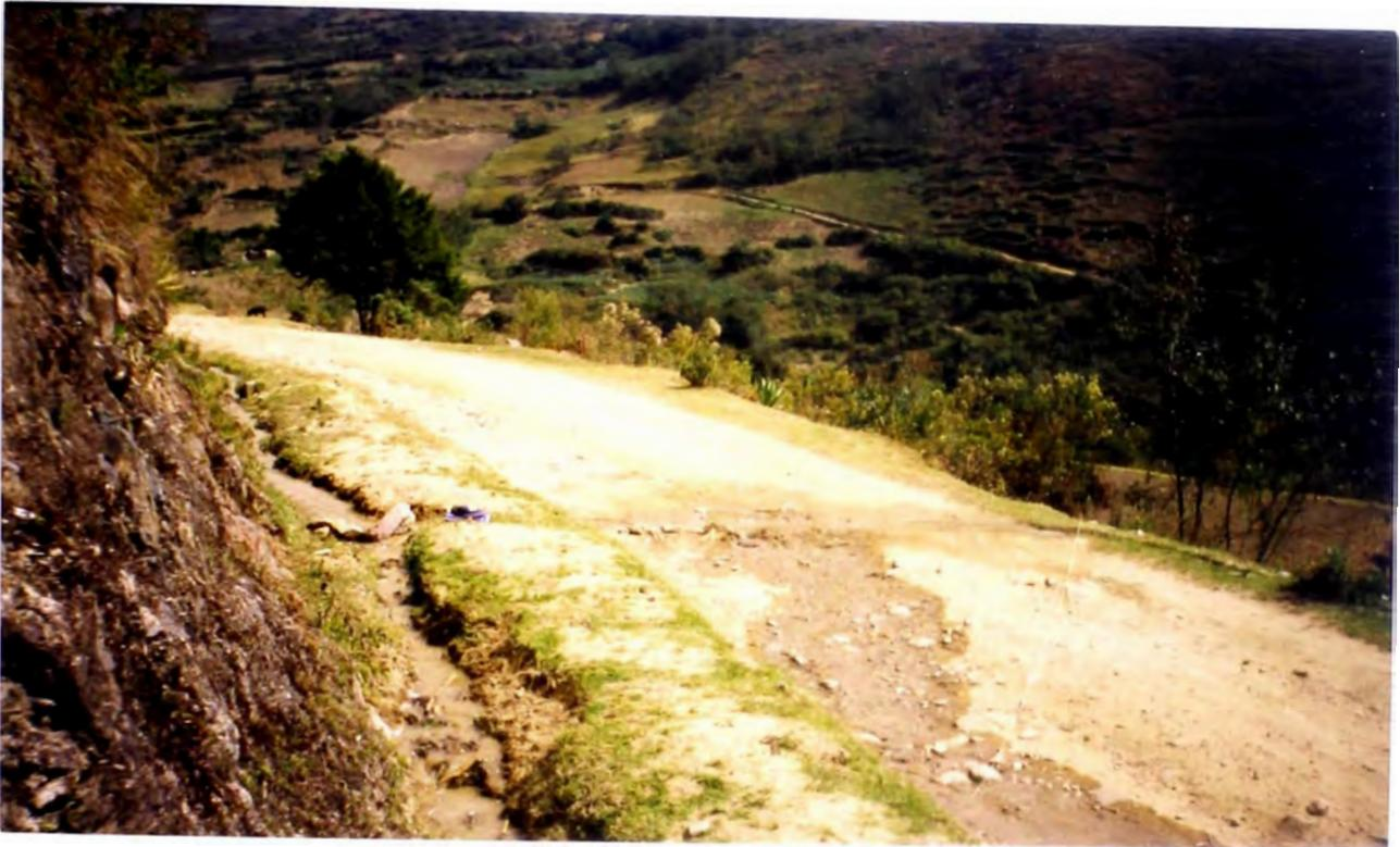
**FOTO N° 05: PROGRESIVA (9 + 740), NOTESE LA PRESENCIA DE VEGETACIÓN SOBRE LA PLATAFORMA**
