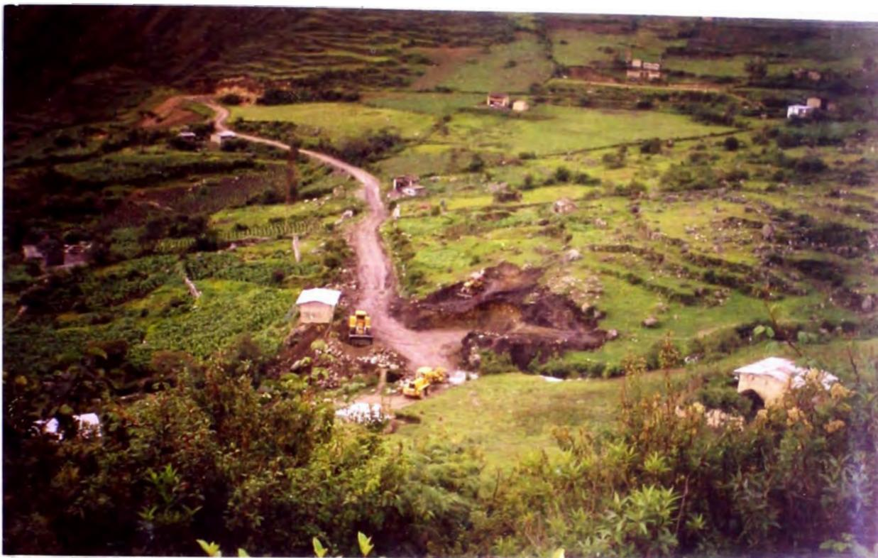
**FOTO N° 03: PROGRESIVA (13 + 400), TRACTOR EXCAVA SOBRE UNA POSIBLE CANTERA, NOTESE TAMBIÉN LA PRESENCIA DE UNA MOTONIVELADORA**
