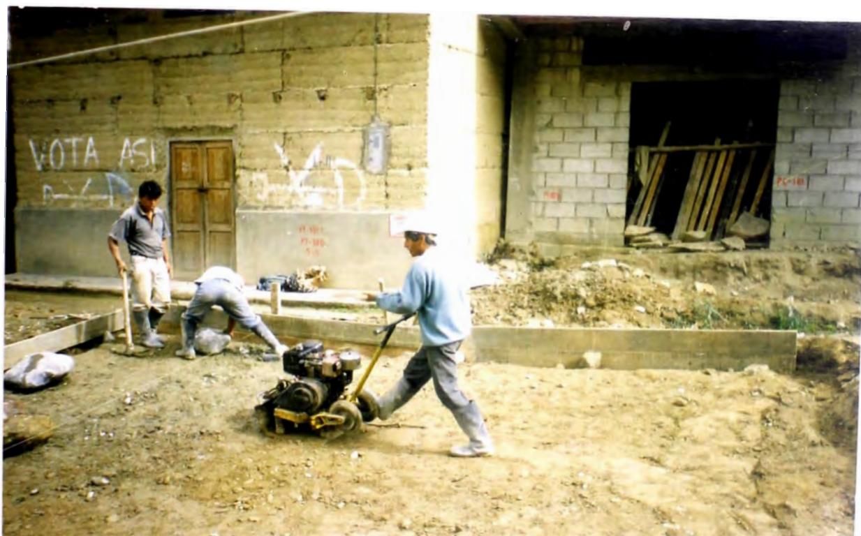
**FOTO N° 42: COMPACTACION DE LA BASE DEL PONTON, NOTESE EL USO DE LA COMPACTADORA MANUAL (PATITO)**
