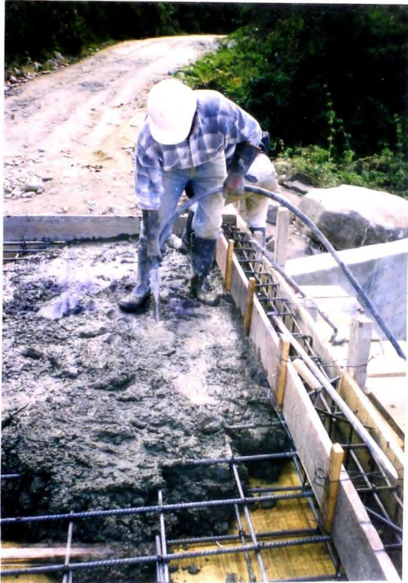
**FOTO N° 37: OBREROS CON VIBRADOR, USADO PARA LA MEJOR COLOCACIÓN DEL CONCRETO DE LA LOSA, NOTESE QUE ESTA CORRECTAMENTE PROTEGIDO**
