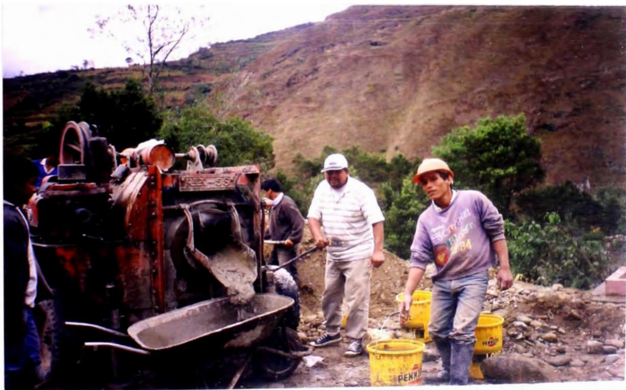
**FOTO N° 36: PARTIDA 5.01.04 PREPARACION DEL CONCRETO PARA LA LOSA, OBSERVESE LA MEZCLADORA (TROMPO) Y CARRETILLAS (BOOGIES)**
