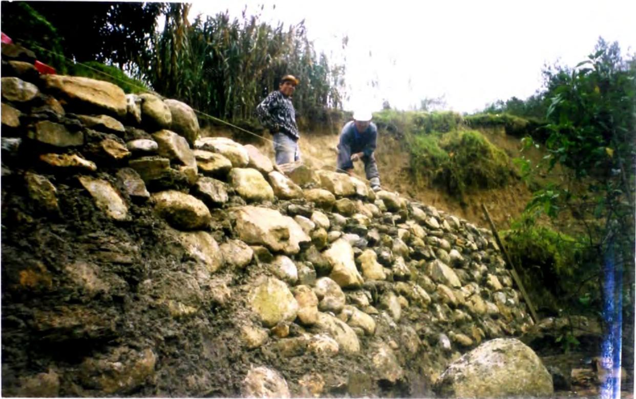
**FOTO N° 46: CONSTRUCCIÓN DE MUROS DE CONTENCIÓN (SOSTENIMIENTO)
