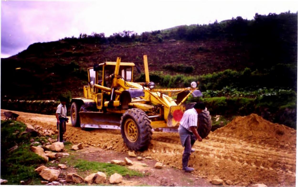
**FOTO N° 05: MOTONIVELADORA ESPARCIENDO EL MATERIAL DE LASTRADO SOBRE LA PROGRESIVA (15 + 080)**
