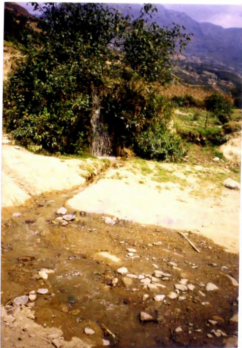
**FOTO N° 12: PROGRESIVA (14 + 990), EL AGUA QUE INVADIO LA PLATAFORMA HA LAVADO EL MATERIAL DE LA PLATAFORMA**
