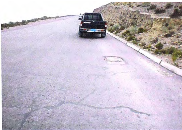
Figura 10: Sellado de fisura.
