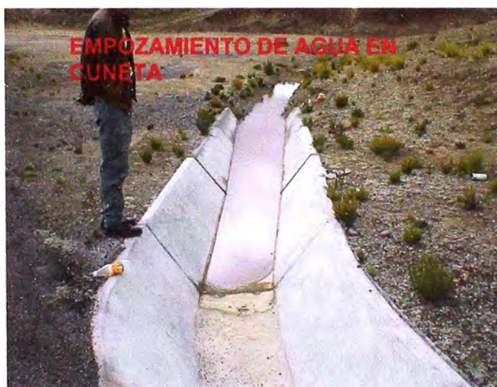
Figura 09: Limpieza de alcantarilla – Colmatación.
