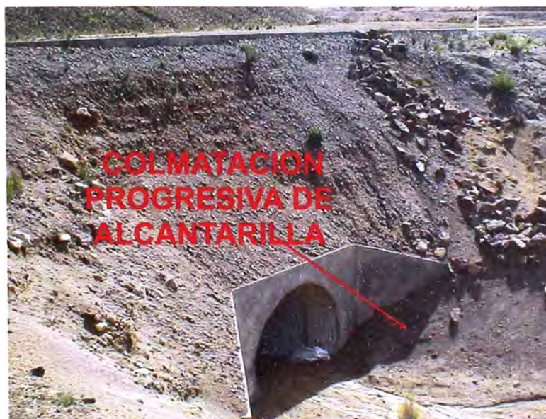
Figura 09: Limpieza de alcantarilla – Colmatación.
