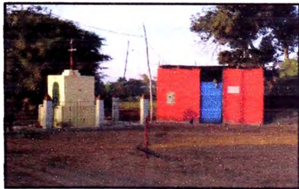
FOTO 2.13 Futura fuente de abastecimiento de agua potable para Roldan, Pozo por explotar.
