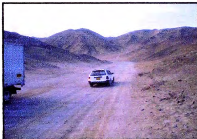
FOTO 2.06: Vista de la condición de la carretera Quilmana – Puerto Fiel, además apreciamos el tránsito de vehículos.
