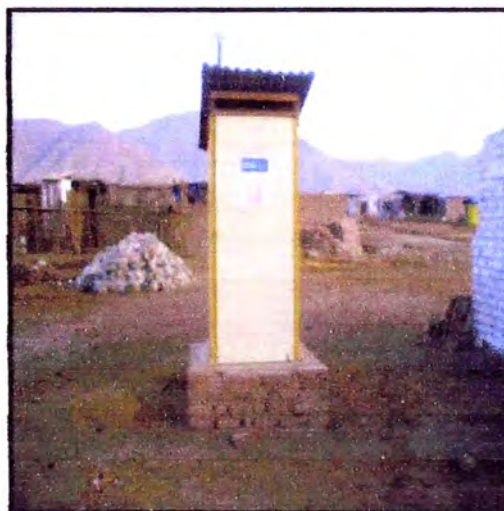
FOTO 2.18 Módulos para Silos en Roldan. (Donación CARE)
