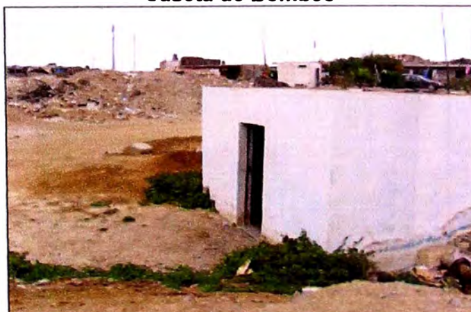
Figura N° 06 Caseta de Bombeo
