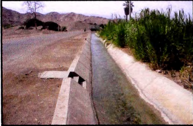
FOTO 2.3.7 Canal lateral A
