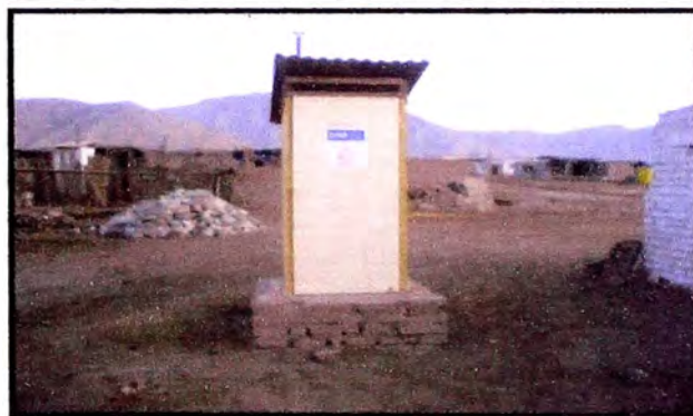
FOTO 2.3.11 Módulos para Silos en Roldan. (Donación CARE)
