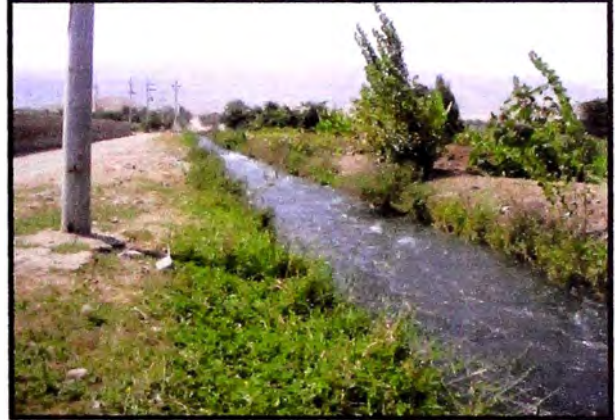
FOTO 2.3.8 Canal lateral B
