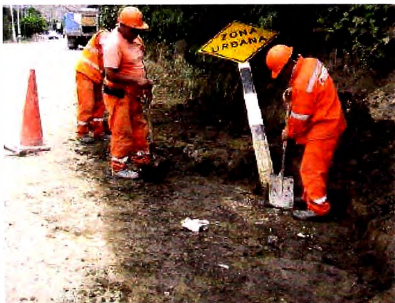
Figura 23: Reposición de señales verticales
