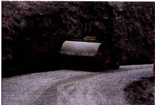
Figura 20: Conformación de la sub rasante
