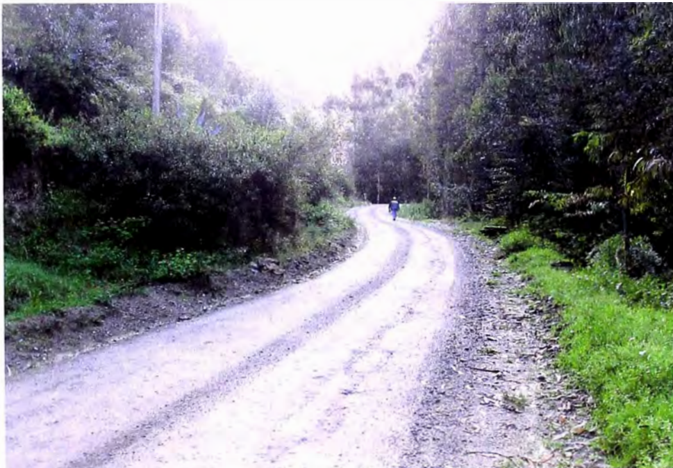
Figura 03: Estado Actual de Carretera
