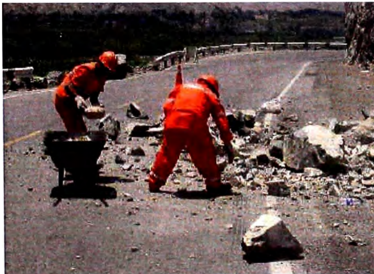
Figura 24: Remoción de derrumbes menores a 50m 3
