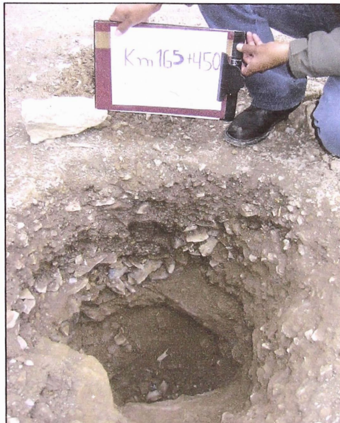
Foto N° 6: Vista de la calicata Km. 165+450, los suelos encontrados hasta la profundidad de 1.25 m son de características granulares.
