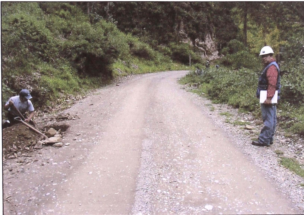
Foto N° 8: Sección típica de la vía ubicada en el Km. 165+450.
