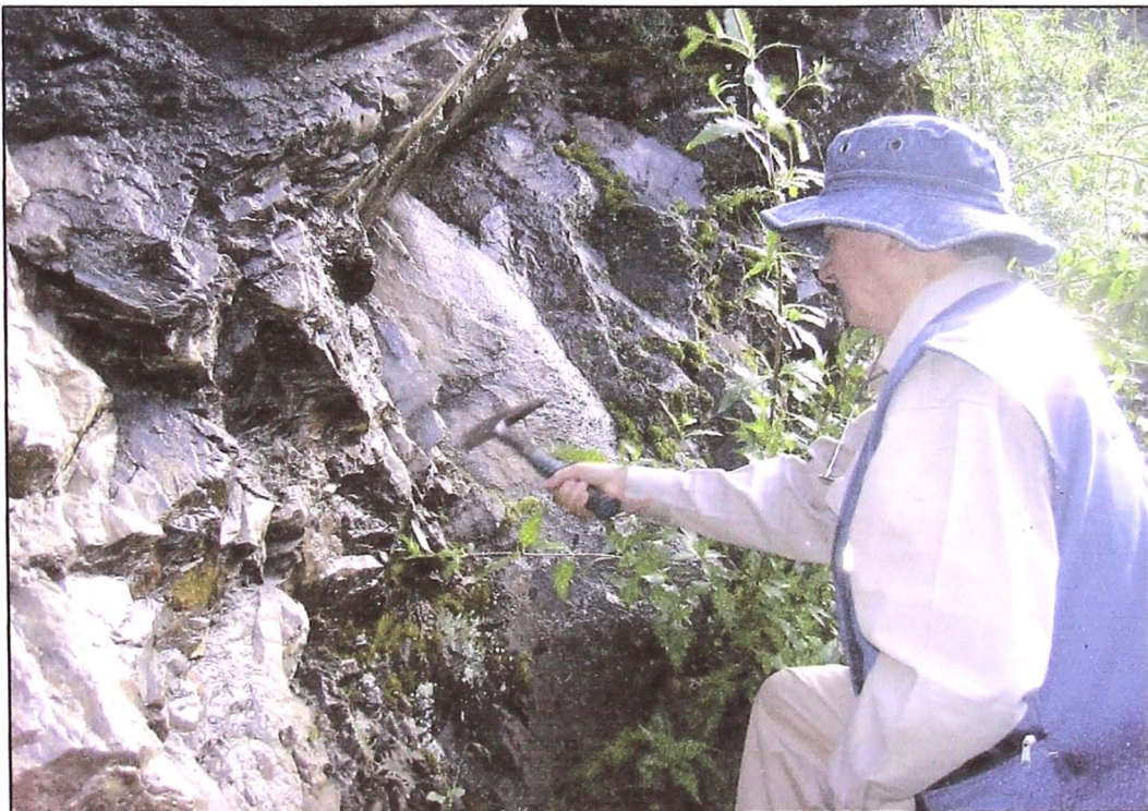
Foto N° 12: Se puede apreciar las fracturas que presenta el afloramiento rocoso.
