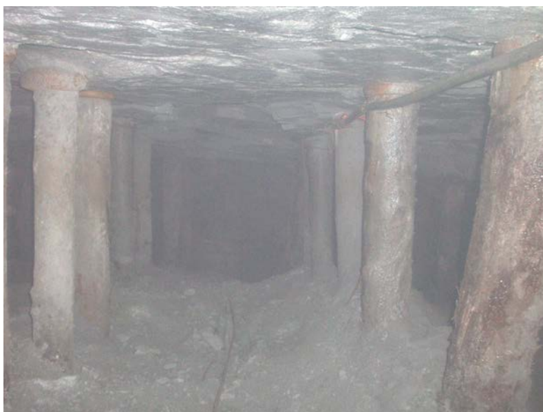
Foto7: Sostenimiento con puntales de 7" Ø
