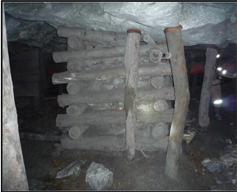
Foto 9: Sostenimiento con Wood pack
