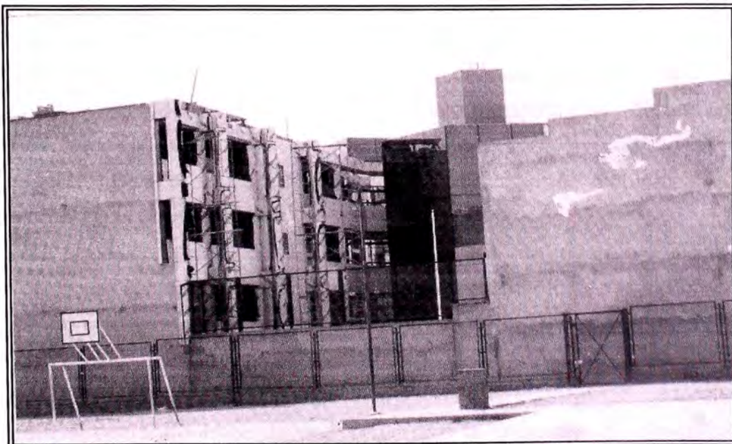
Foto N° 27- Etapa final, Vista posterior de la edificación.
