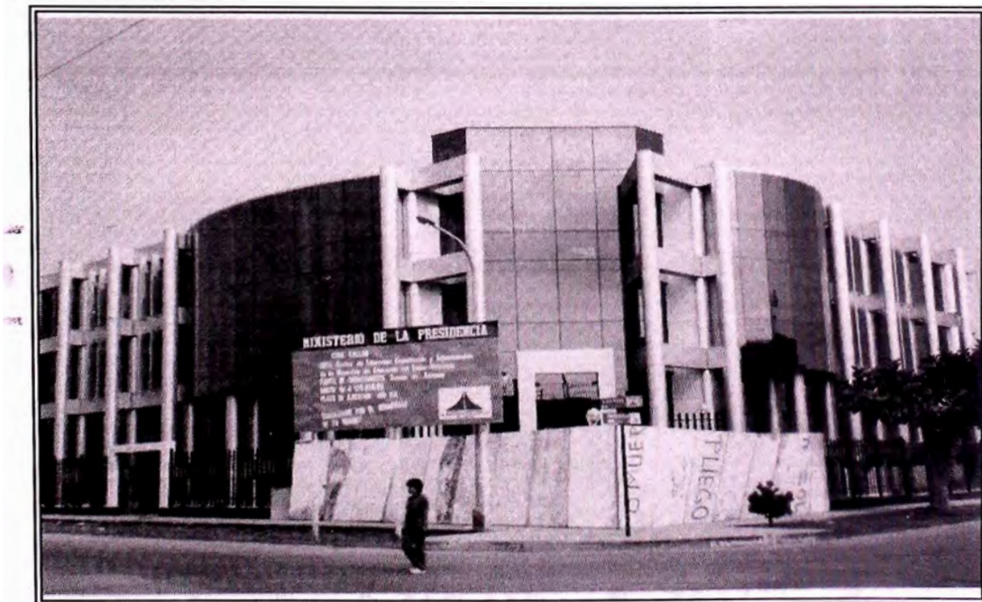
Foto N° 26 Etapa final, con la pantalla de vidrio templado en su posición final
