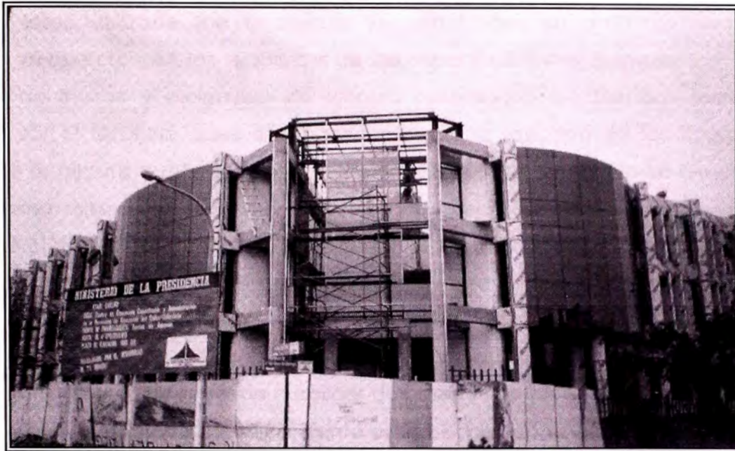
Foto N° 25 Etapa de colocación de elementos de soporte de la pantalla de vidrio.
