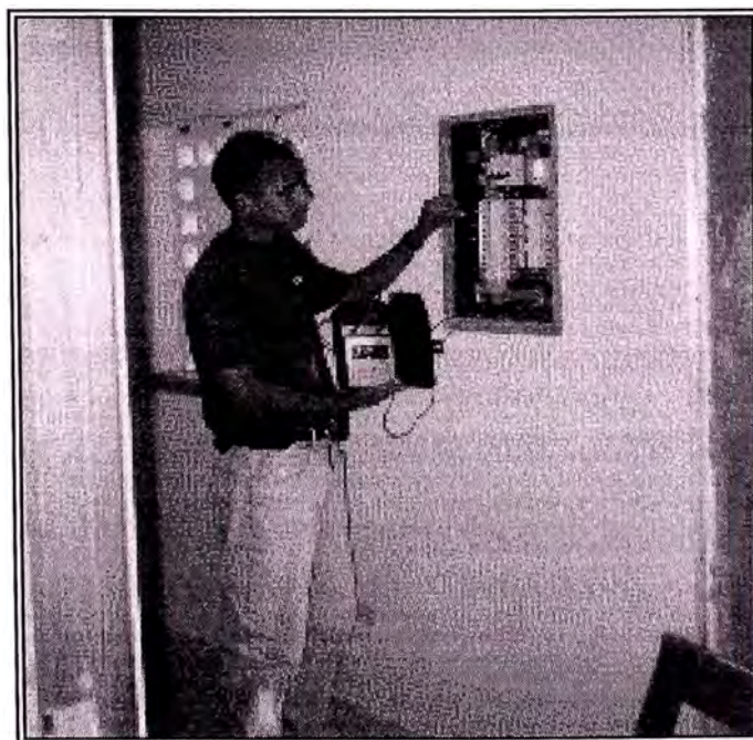
Foto N° 17- Prueba de aislamiento de los circuitos
