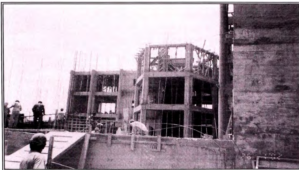
Foto N° 05 Avance en la construcción de casco de concreto armado del módulo de escalera
