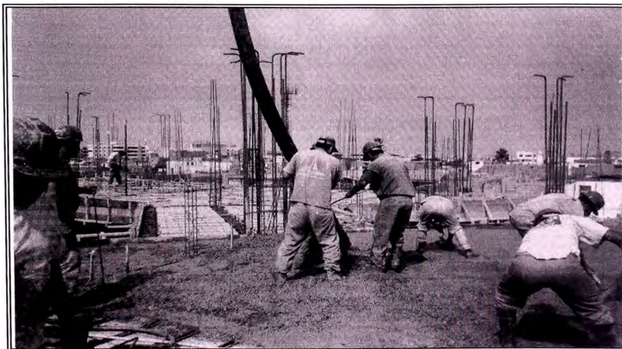
Foto N° 12 Vaciado de concreto premezclado en Losa Aligerada – 3er Nivel
