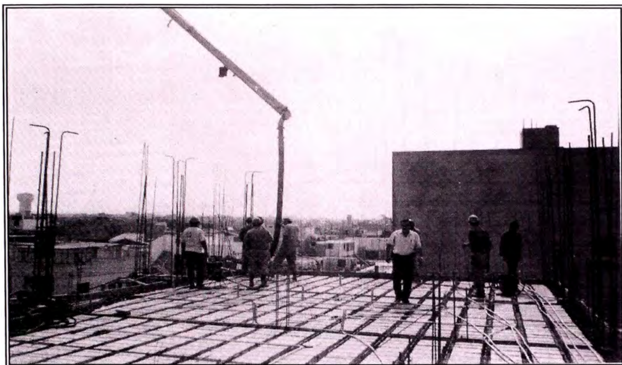
Foto N 09 Personal obrero esperando la impulsión del concreto para el vaciado de concreto premezclado en losa aligerada- 2do Nivel
