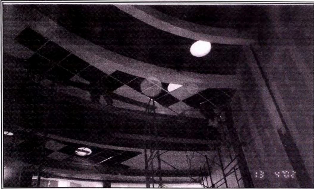
Foto N° 21 - Colocación de baldosas acústicas en módulo de auditorio utilizando andamios metálicos. Obsérvese más arriba los ductos de ventilación
