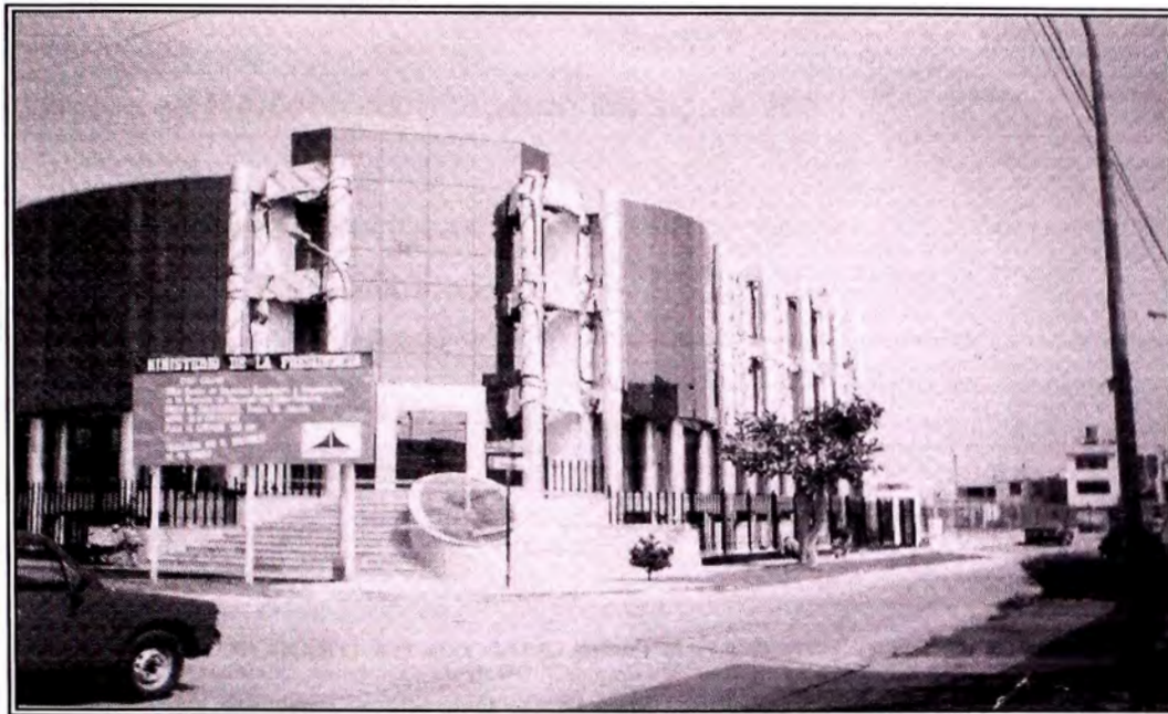
Foto N° 28 Construcción concluida al 100%
