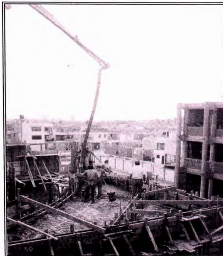
Foto N 08 Vaciado de concreto utilizando concreto premezclado en losa de módulo de auditorio. Se observa la pluma que sujeta la manguera de impulsión de concreto, la que en este caso posibilito el vaciado en altura.
