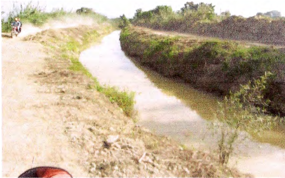
Foto N° 3. Canal María Angola vista hacia el Centro Poblado de San Benito (Imperial). Existencia de camino de vigilancia por ambas márgenes. Acceso solo con vehículos menores. Buen estado de conservación.
