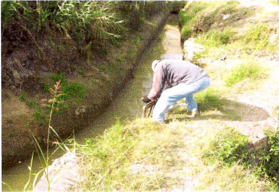
Foto N° 1. Salida del penúltimo túnel denominado Galafate, que atraviesa el canal María Angola en el cerro Candela. Nótese que el canal está limpio producto de la última limpieza realizada el mes de Mayo de 2009. No se cuenta con denominación de número de compuerta.
