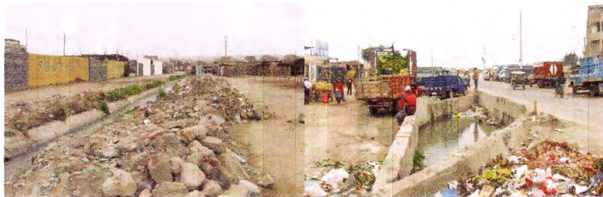
Foto N° 30. Canal María Angola a su paso por el Mercado de Frutas y Verduras de Imperial. Nótese el desmonte arrojado cerca de sus riberas. Cuando se realizó la limpia de los canales en Mayo los comerciantes del mercado se organizaron para contratar camiones que eliminen el desmonte y no se dé un mal aspecto al mercado.
