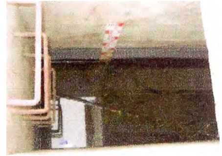
Foto N° 51. Aforador RBC sobre el canal San Miguel y poza limnimétrica. Actualmente el limnómetro y el limnógrafo no se encuentran operativos.
