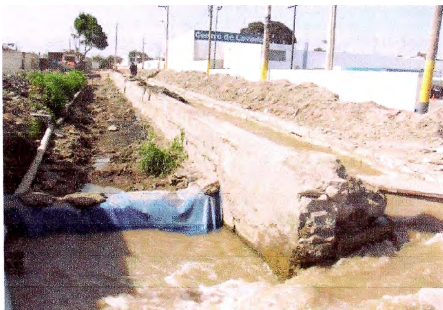
Foto N° 56. Obras de Canalización del Canal Derivador Huarco en el C.P. San Luis.
