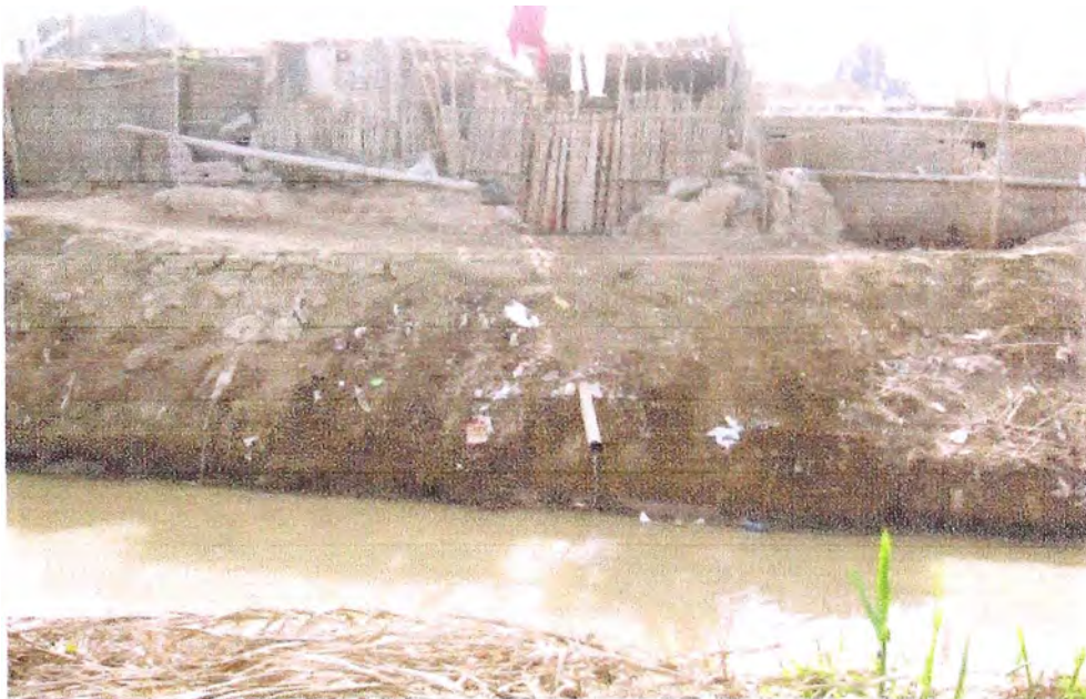
Foto N° 4. Desagüe de vivienda descargando hacia el Canal María Angola, C.P. San Benito – Imperial.
