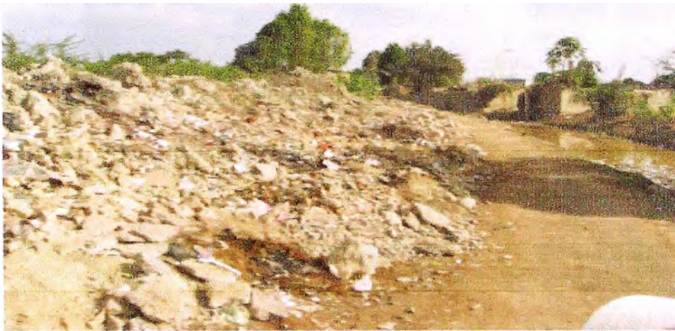
Foto N° 5. Camino de Vigilancia hacia el C.P. La Quebrada, San Luis. Nótese la acumulación de desmote y basura producto de la limpieza hecha al canal y otros del propio centro poblado.
