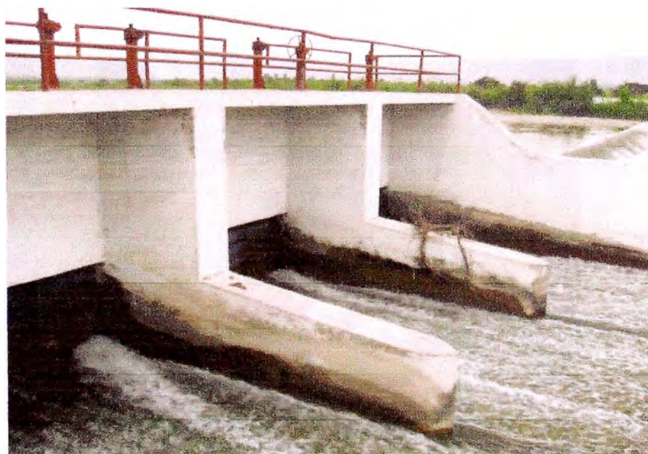
Foto N° 44. Vista aguas abajo del barrage móvil
