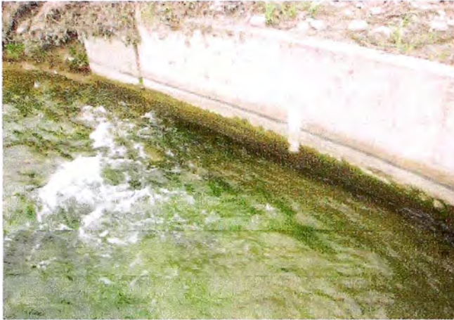
Foto N° 51. Aforador RBC sobre el canal San Miguel y poza limnimétrica. Actualmente el limnómetro y el limnógrafo no se encuentran operativos.
