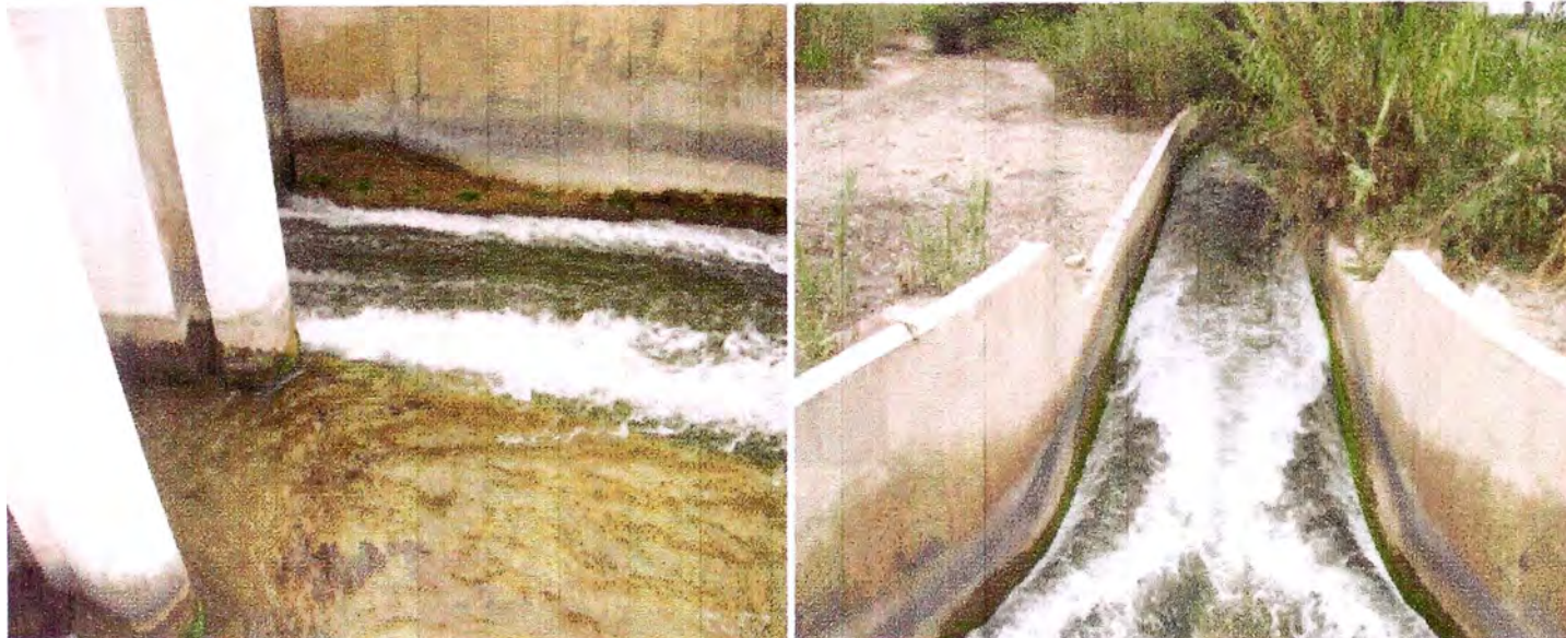
Foto N° 40. Salida de aguas de la bocatoma Fortaleza hacia el partidor que entregará aguas a los canales San Miguel y María Angola
