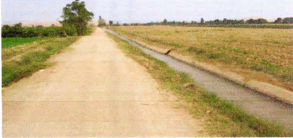
Foto N° 20. Lateral de 1er Orden Charilla Nueva revestido en todo su recorrido construido en el marco del Plan REHATIC. Nótese el buen estado de conservación de las tierras aledañas.
