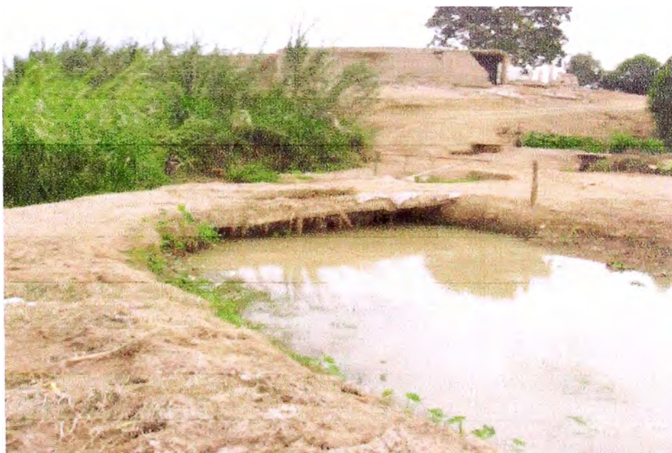
Foto N° 16. Cruce del Canal María Angola con el Dren La Charilla Vieja.
