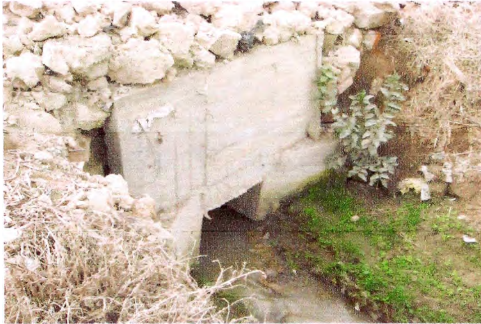
Foto N° 12. Tomas construidas por el Gobierno Regional en sector Sal si Puedes debido a que el sismo de 2007 provocó el derrumbe del bordo izquierdo del canal.
