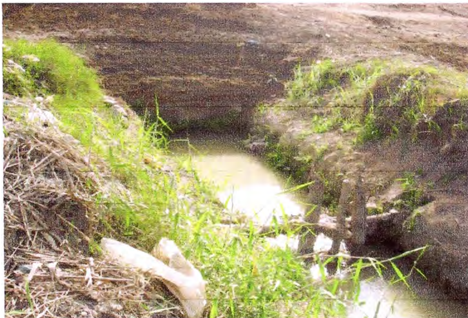
Foto N° 2. Ingreso al último túnel que atraviesa el canal María Angola denominado Túnel Cinco. Nótese la necesidad de contar con una rejilla que no permita el paso de sólidos y obstruya al canal. El canal va casi al máximo de su capacidad.
