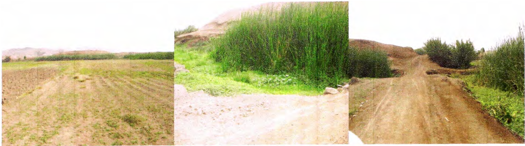
Foto N° 21. Puente Mario Sierra y terrenos aledaños hacia el norte. A la izquierda dren La Charilla Vieja. Nótese que los terrenos al norte se encuentran con problemas de nivel freático alto por el crecimiento del junco y totora. En dichos terrenos se puede sembrar solo las zonas donde lo permita el nivel freático.
