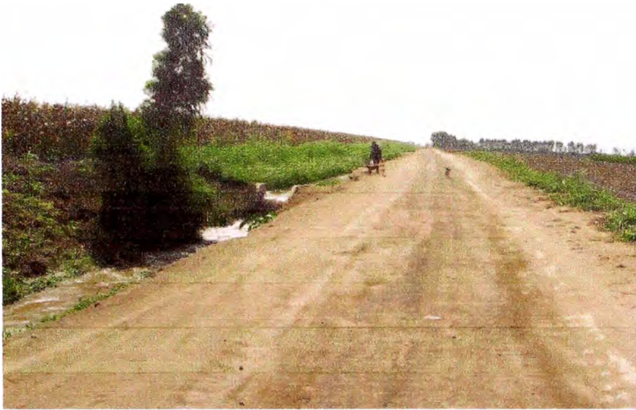
Foto N° 25. Dren Colector La Charilla Nueva. Nótese las caídas en concreto armado a lo largo de su recorrido.
