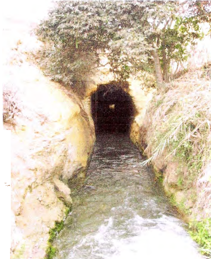
Foto N° 53. Ingreso a túnel N° 2 Socavón del Canal María Angola, San Vicente de Cañete. A diferencia del túnel Galafate, este túnel permite el ingreso de personas para su inspección y mantenimiento.
