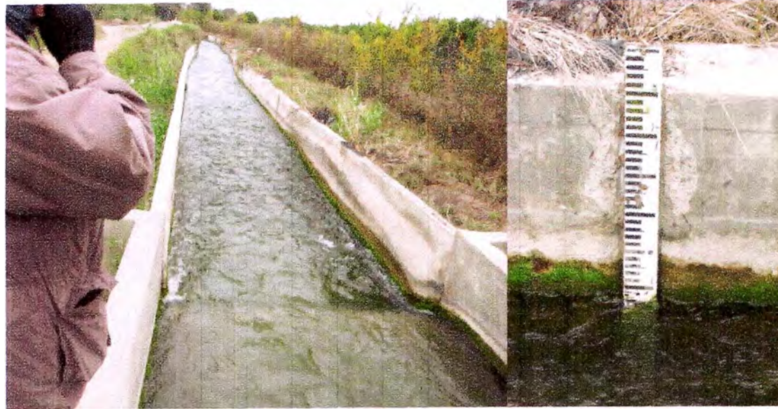
Foto N° 39. Aforador RBC sobre Canal San Miguel en buen estado de conservación. Requiere un par de reparaciones a los muros de concreto así como volver legible los números de la regla limnimétrica.
