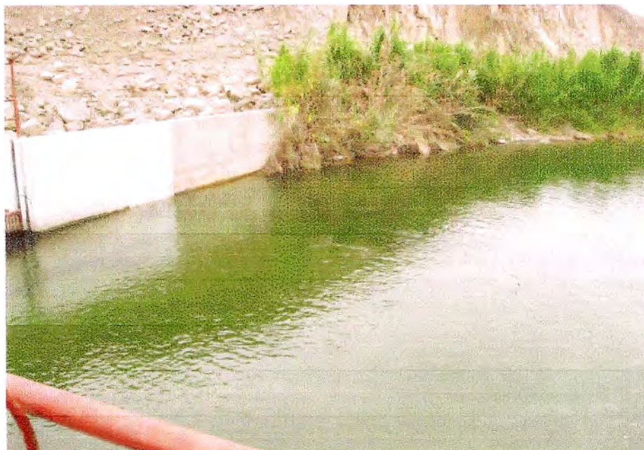
Foto N° 43. Poza disipadora de energía
