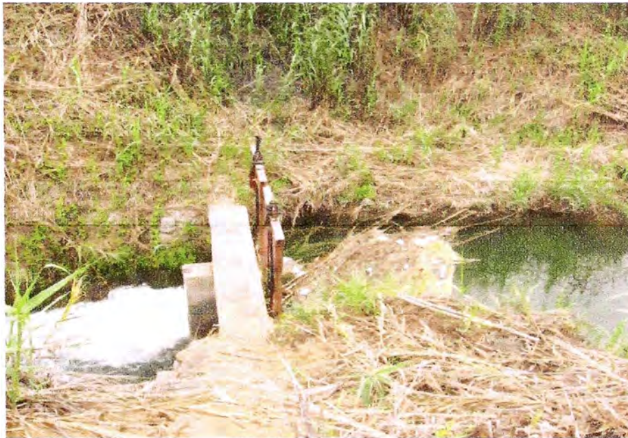
Foto N° 52. Compuertas de ingreso a túnel N° 2 Socavón del Canal María Angola, San Vicente de Cañete. Nótese la maleza suspendida en el agua y la gran cantidad de agua acumulada.
