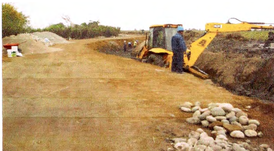
Foto N° 35. Obras de revestimiento del canal Huanca. No se contaba con topógrafo ni con instrumentos de topografía al momento de la visita.
