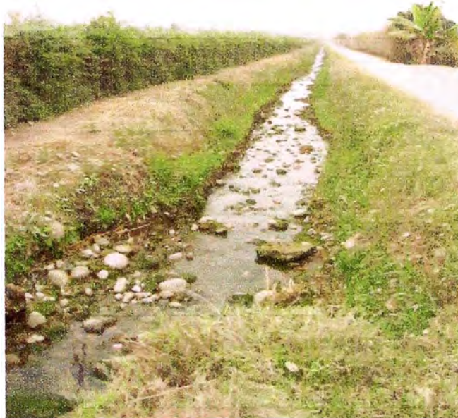
Foto N° 33. Vista del canal Pachacamilla hacia aguas abajo del Puente Cebada, San Vicente de Cañete.
