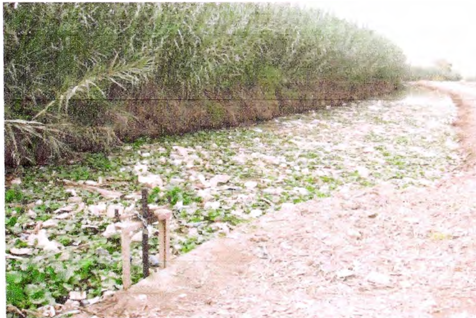
Foto N° 11. Gran acumulación de basura, zona comprendida entre las compuertas N° 58 y 59. Nótese el crecimiento de las plantas acuáticas en el cauce del río. (Vista aguas arriba).
