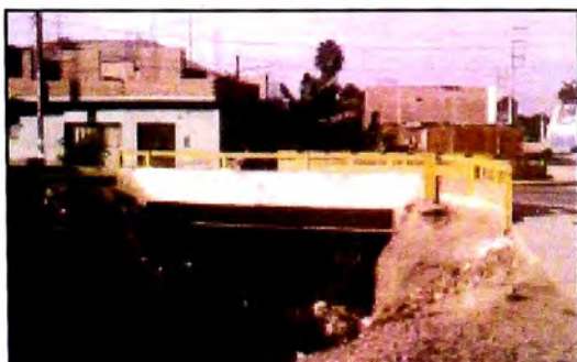
Foto N° 1.1: Cruce de la Quebrada Pócoto con la Calle Garro
