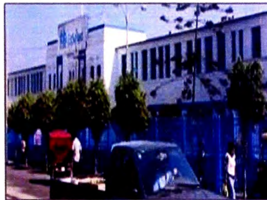
Foto N° 2.09: Hospital II Essalud
