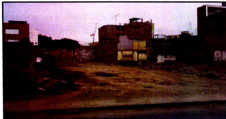
Foto N° 3.04: Vivienda afectada por sismo del 15 de Agosto del 2,007
