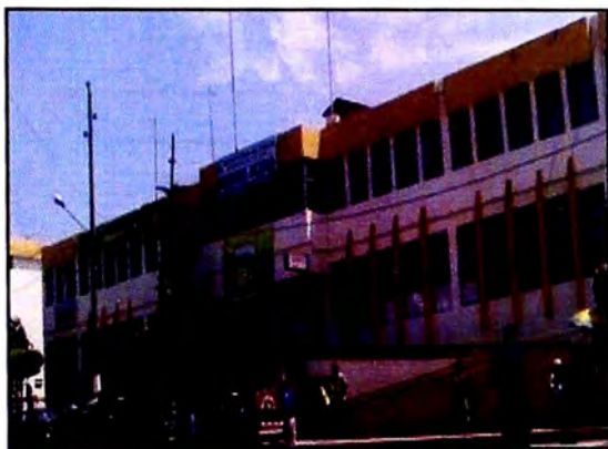
Foto N° 2.08: Hospital de Apoyo Rezola
