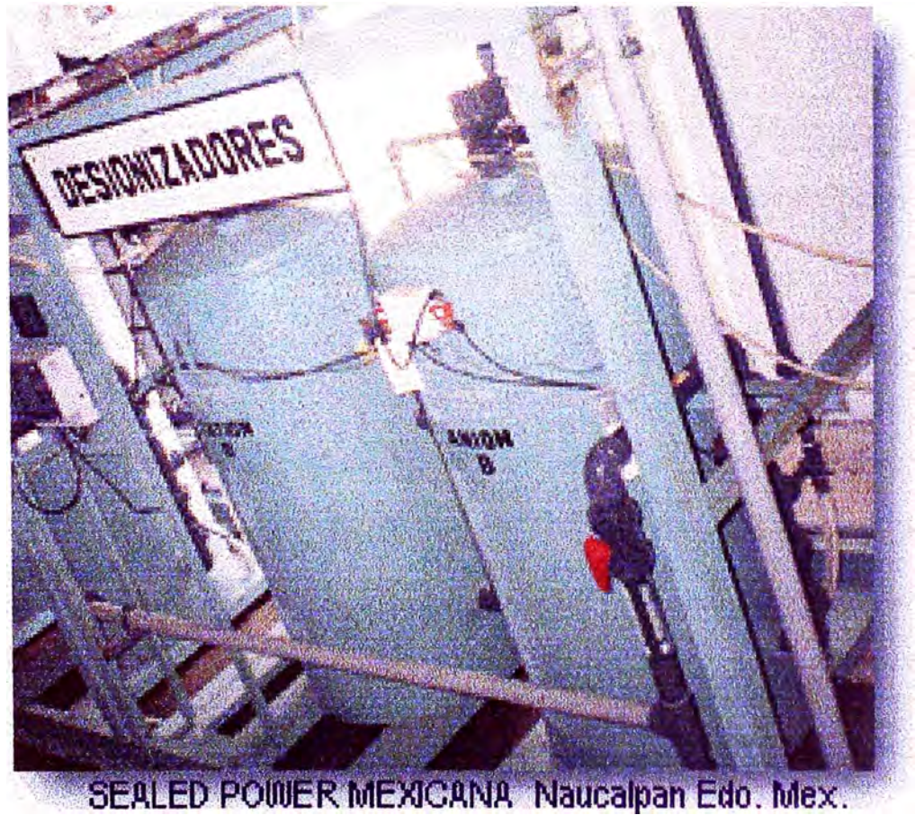
FIGURA N° 2.9 DESIONIZADORES
