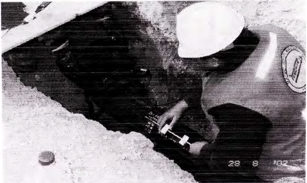
ENSAYO DE ULTRASONIDO A TUBERIA DE AGUA CONTRA INCENDIO HDPE, EN CAMPO
