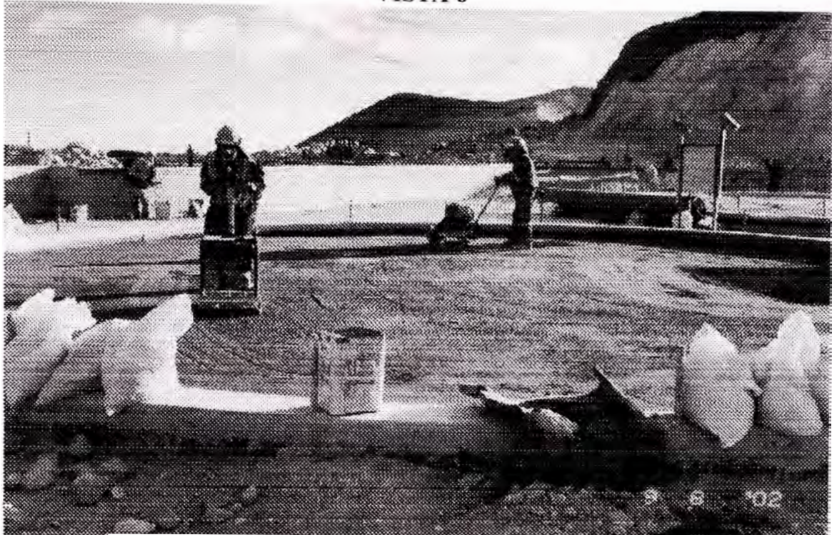
ZONA DE TANQUES: COMPACTADO DE BASE INTERIOR EN ANILLO DE TANQUE DE COMBUSTIBLE
