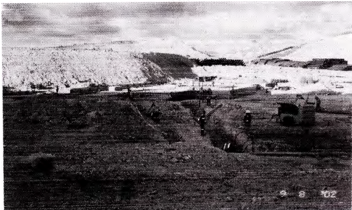
EXCAVACIONES PARA TUBERIAS DE DRENAJE, COMBUSTIBLE E INSTALACIONES ELECTRICAS
