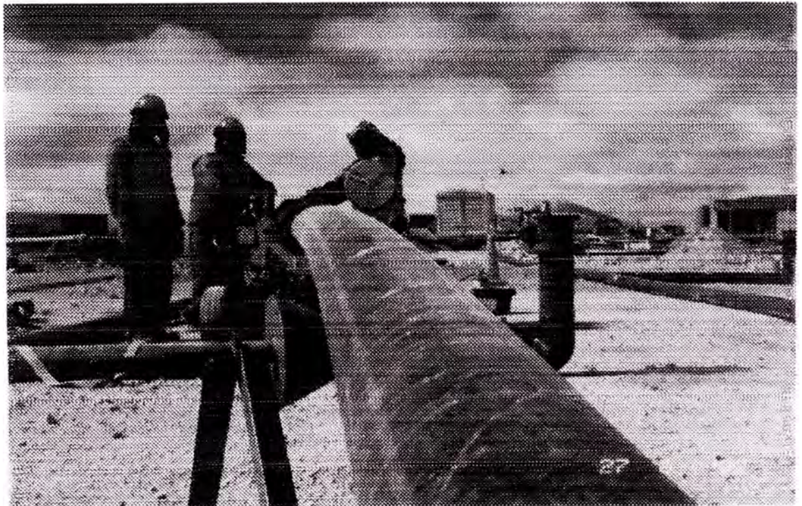
ARMADO DE TUBERIA HDPE DE AGUA CONTRA INCENDIO. SDR 11 Ø6"
