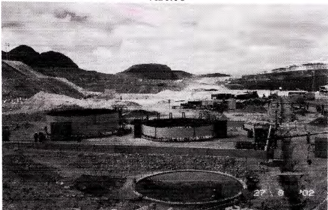
ZONA DE TANQUES: TANQUES DE COMBUSTIBLE Y TANQUE DE AGUA, SE APRECIA EXCAVACIONES DE SISTEMA DE AGUA CONTRA INCENDIO
