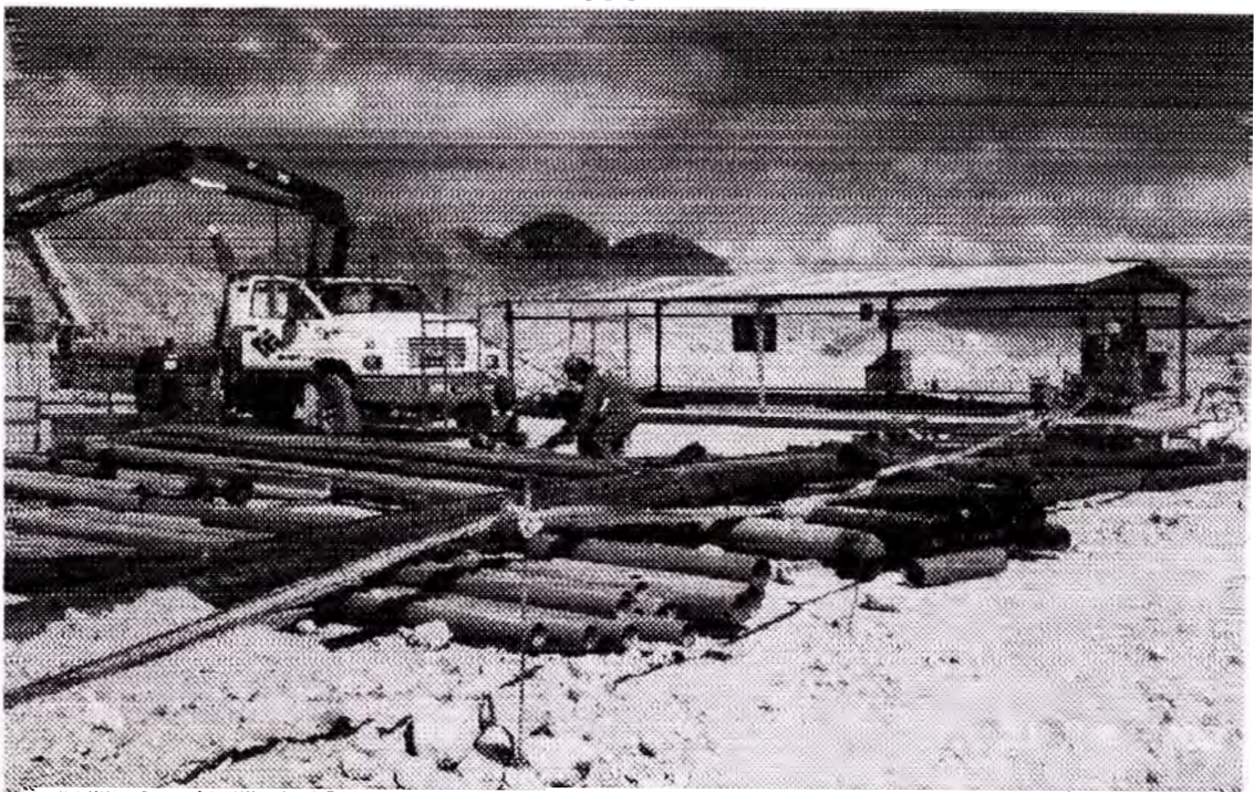
HABILITADO DE TUBERIA HDPE PARA EL SISTEMA DE AGUA CONTRA INCENDIO SDR11 6"Ø
