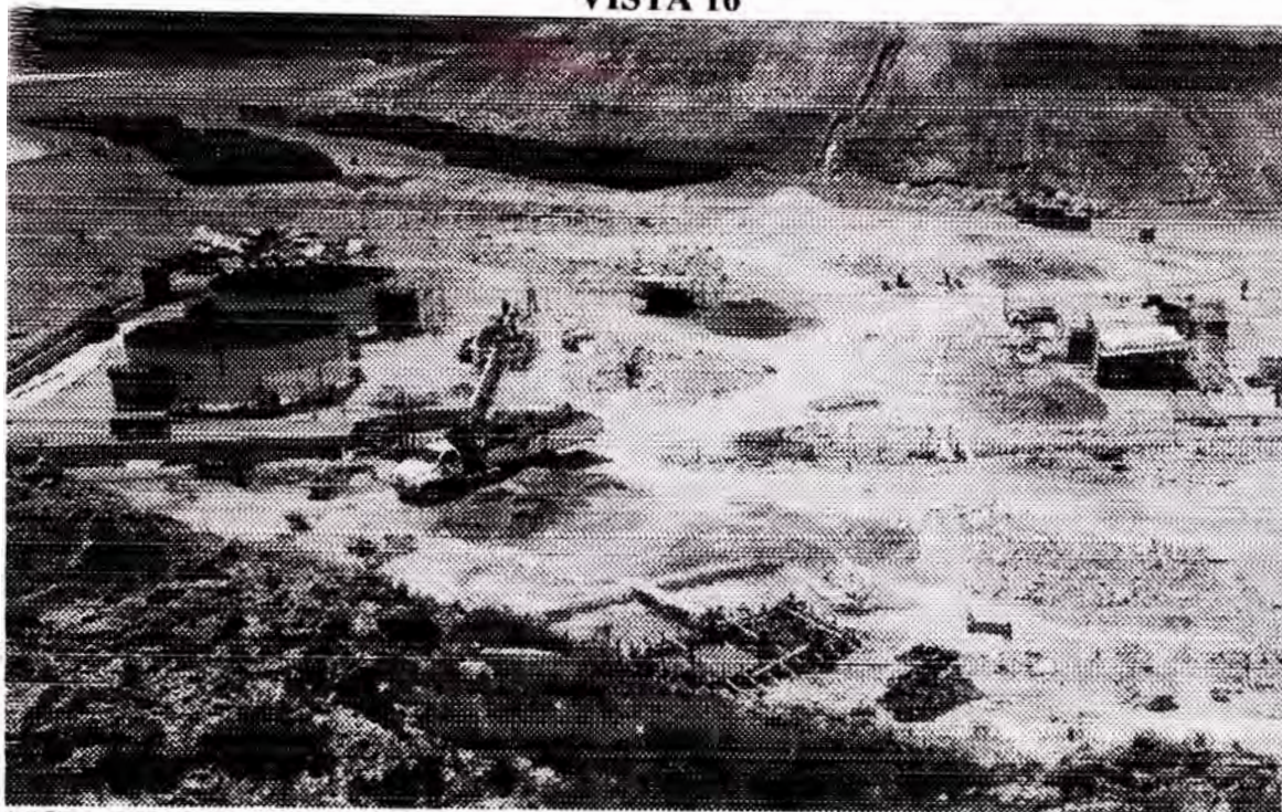
VISTA PANORAMICA DE LA OBRA
