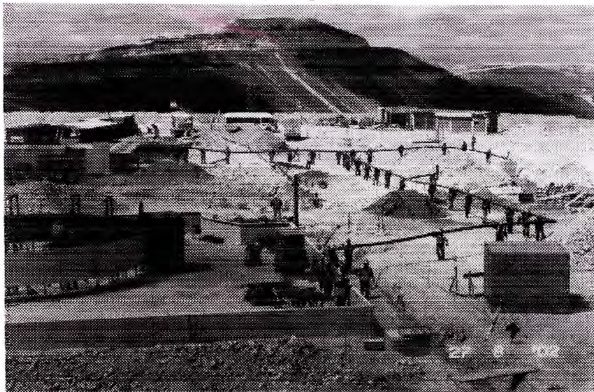
COLOCACION DE TUBERIA DE DRENAJE 6" DIA. HDPE SDR 32.5
