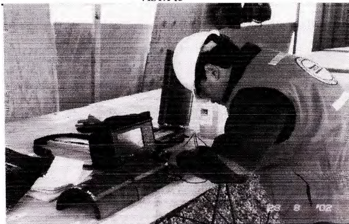
ENSAYO DE ULTRASONIDO A LA COSTURA DE LA TUBERIA DE DRENAJE HDPE SDR 32.5
