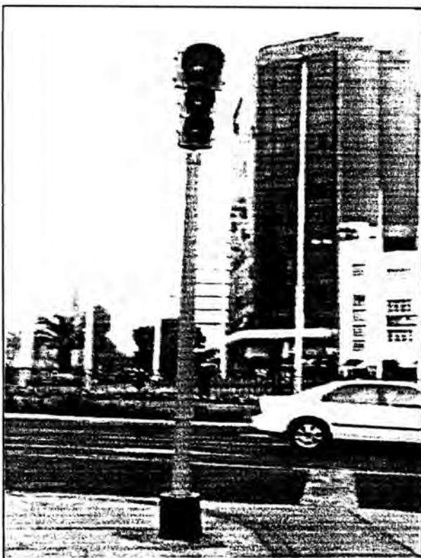
Figura No.2 :Instalación tipo Pedestal Simple
