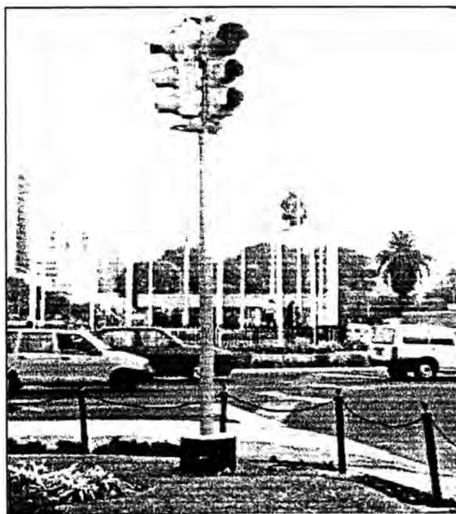
Figura No.4 :Instalación tipo Pedestal Triple
