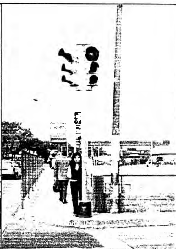
Figura No.3 :Instalación tipo Pedestal Doble
