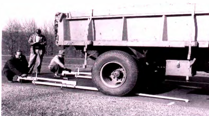
FIGURA N° 2.1 VIGA BENKELMAN
