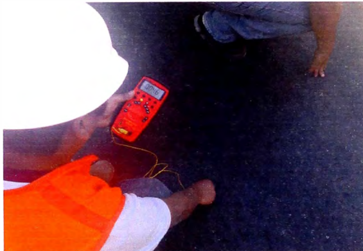
FIGURA N° 4.3 TOMA DE TEMPERATURA AL PAVIMENTO.
