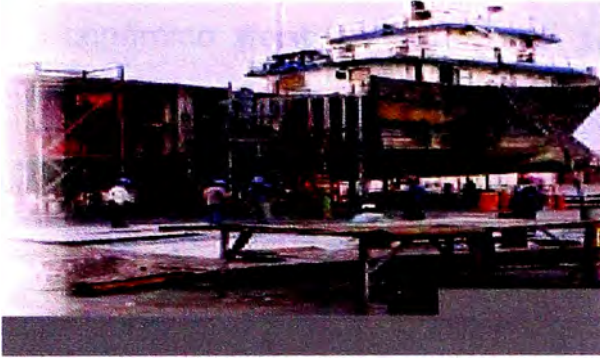
Figura 6-A Trabajos de remodelación de casco en una embarcación
