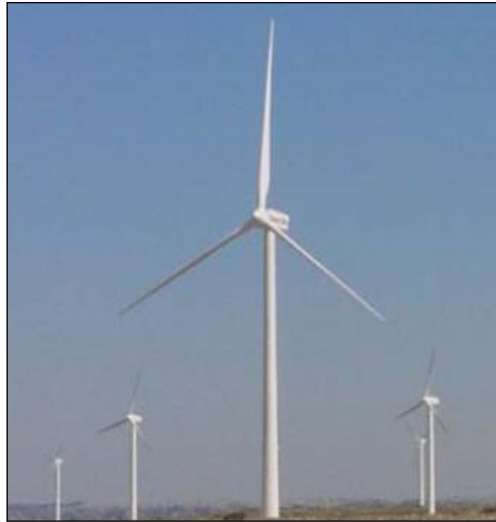
Figura 2.1: Aerogenerador a barlovento
