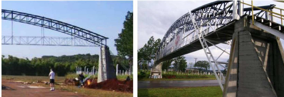
Figura N° II-13 Vistas de puente peatonal en Autódromo de Oberá, Argentina. Izquierda puente original. Derecha, estructura reforzada. D. Brisson, 2014.
