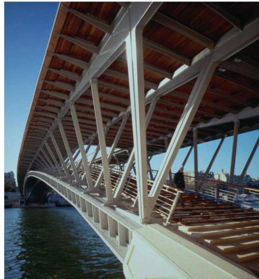
Figura N° II-10 Vista del puente Solferino. Fuente: Sétra.
