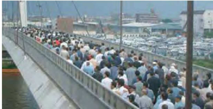
Figura N° II-8 Puente Parque Toda, Puente peatonal atirantado de acero con luces de 45 m y 134 m, ubicado en la ciudad de Toda, Japón.
