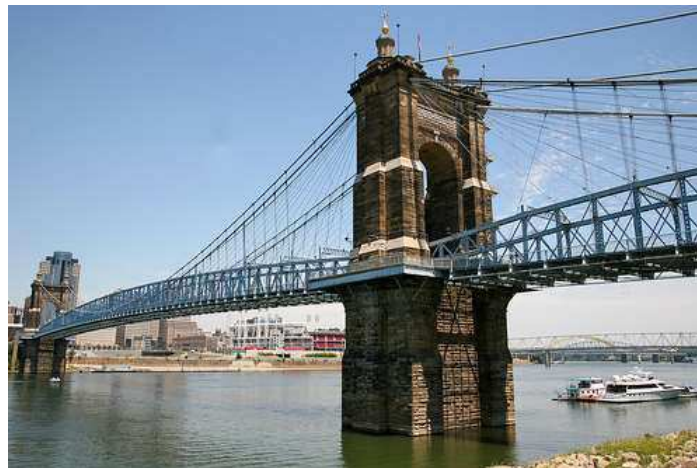
Figura N° II-9 Puente John A. Roebling, Puente peatonal colgante, su luz principal es de 322 m.
