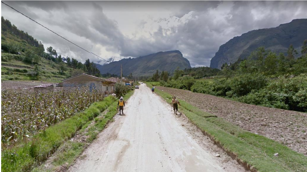
Foto 11-5: Estado actual de la carretera Yungay – Quebrada de Llanganuco Elaboración Propia
