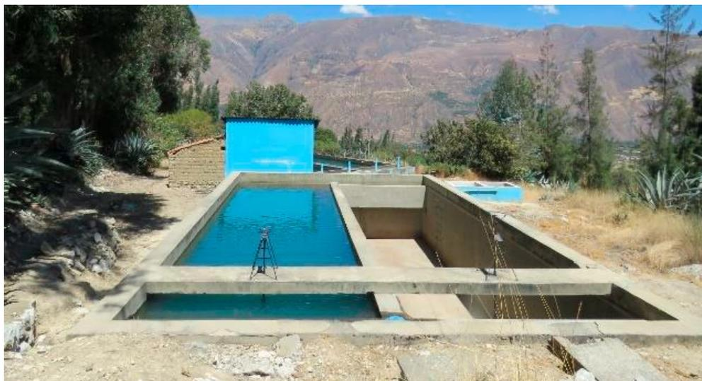
Foto J-2: Sedimentador Grueso, Planta de tratamiento de agua potable de Administración Municipal
