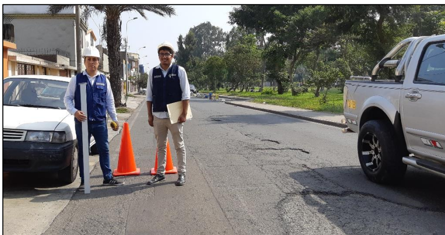
Figura N° 4.8 Elementos de seguridad
