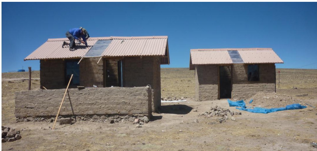
Figura 5. Vista de los módulos bioclimáticos con techo de fibrocemento.
