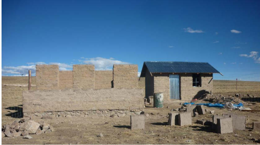
Figura 4. Vista del módulo típico al fondo, y delante de él la construcción de los muros del módulo mejorado.
