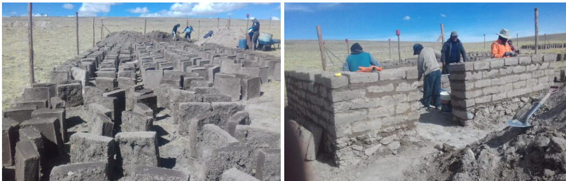
Figura 2. (Izq.) Secado de canto de los adobes, (der.) levantamiento de muro.
