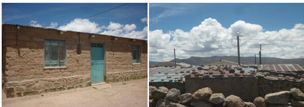
Figura 22. Vistas de una vivienda típica en Imata, (izq.) puerta de calamina y ventanas de vidrio con marco metálico en la fachada principal, (der.) techos de calamina metálica con piedras que fijan su sujeción, vista posterior de la vivienda.
