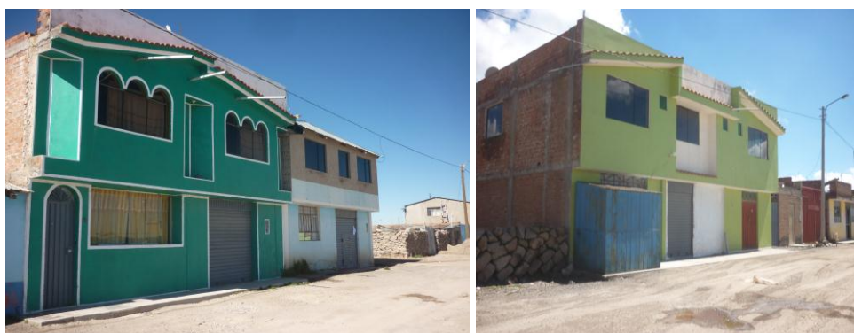
Figura 23. Vistas de las nuevas construcciones en Imata empleando material convencional no idóneo para la zona.
