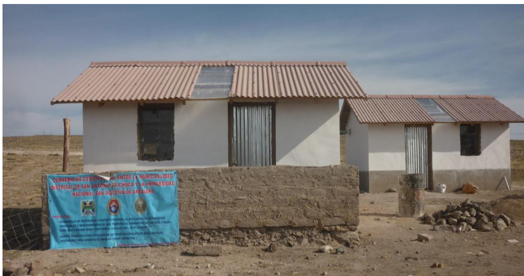
Figura 6. Vista actual de los módulos bioclimáticos enlucidos con yeso por el exterior.
