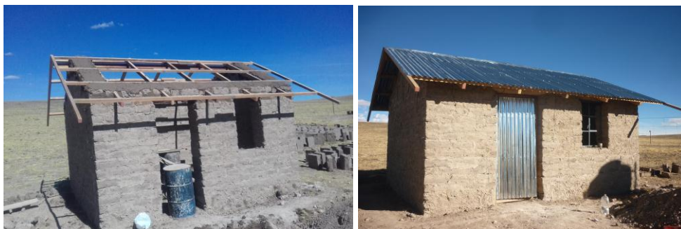
Figura 3. (Izq.) Estructura de madera del techo, (der.) vista del módulo típico.
