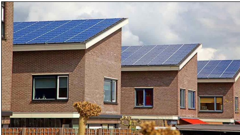
Figura 2.05: Viviendas fotovoltaicas con módulos sobre techo.
