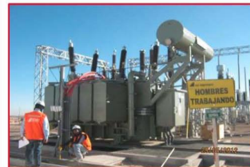
Transformador de Potencia 20 MVA, 23/138 kV (S.E. Central Majes Solar (S.E. Pedregal))
