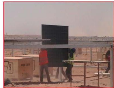
Instalación de Módulos Fotovoltaicos
