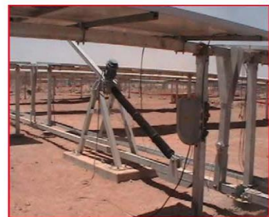
Instalación de Seguidor Solar
