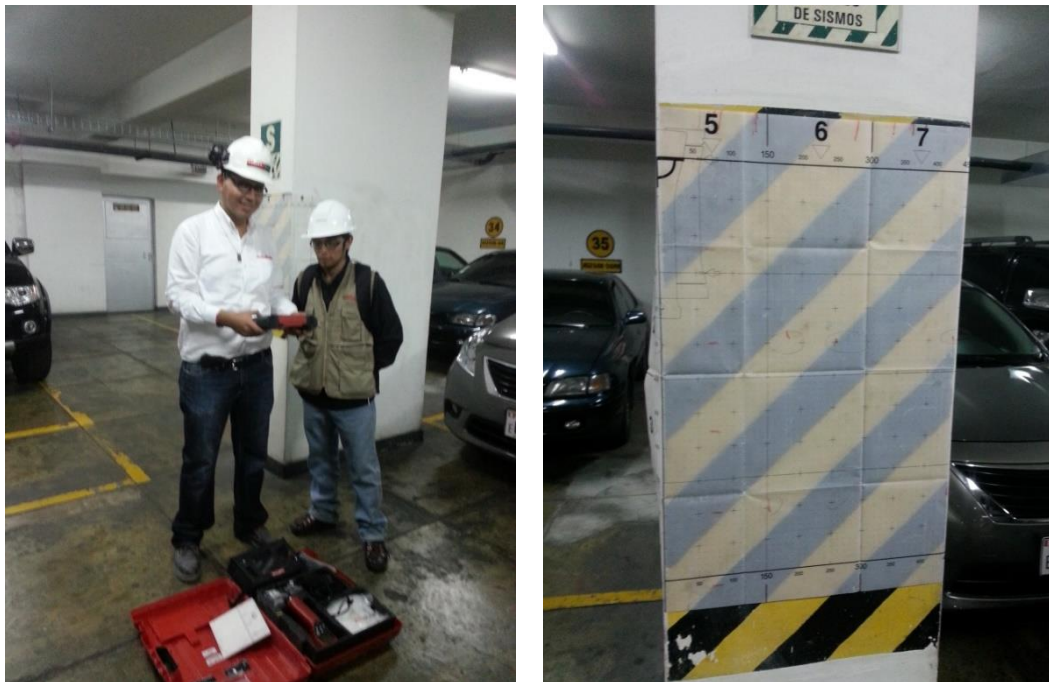
Figura N° 7.4 Escaneo del acero de refuerzo en el edificio Universal
