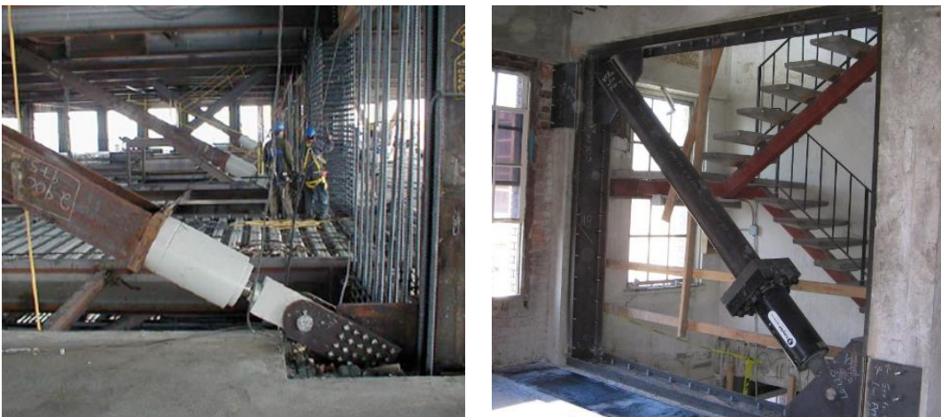
Figura N° 4.10 Disipadores instalados en disposición diagonal (Taylor Devices)
