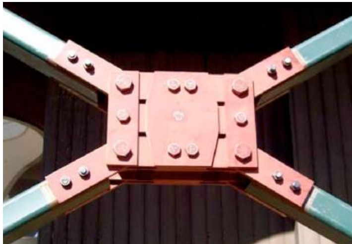
Figura N° 3.15 Dispositivo de amortiguamiento por fricción tipo Pall (Symans, Charney, Whittaker, Constantinou, Kircher, Johnson McNamara, 2008)
