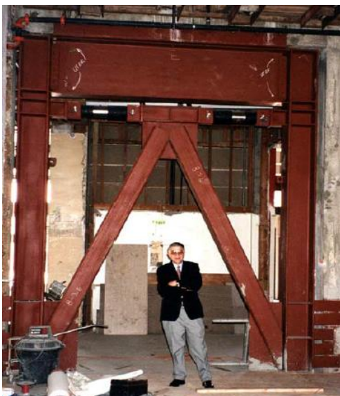
Figura N° 4.11 Disipadores instalados en disposición Chevron (Taylor Devices)
