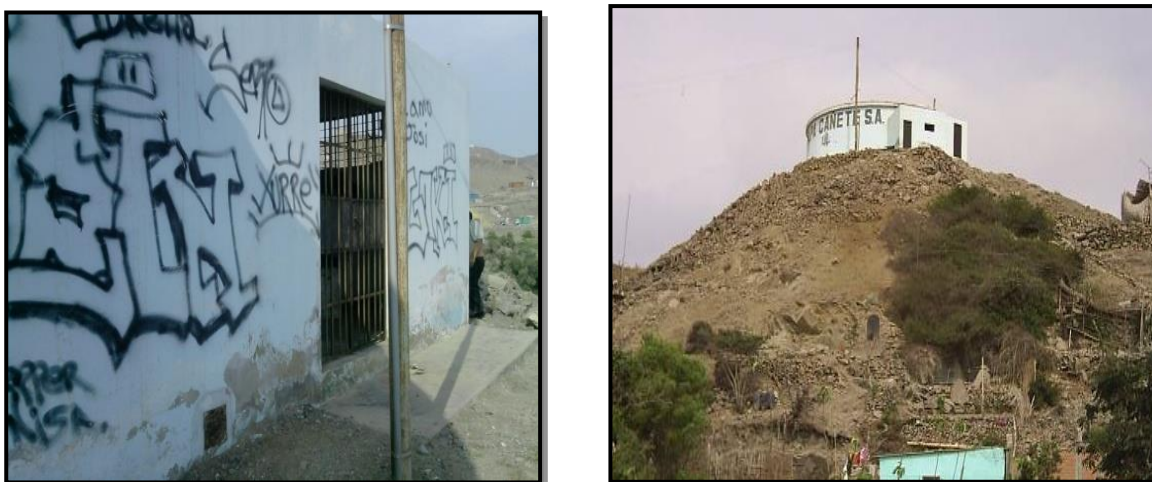
Figura N° 6: Estación de Rebombeo y Reservorio RE-01 V=400 m 3
