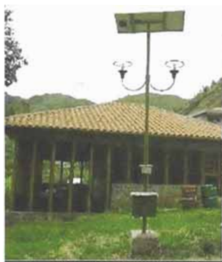
Fig. 10 Termino de la instalación
