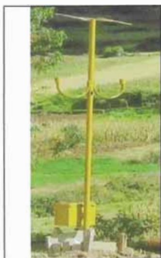
Fig. 9 Vista de la estructura metálica del poste solar autónomo
