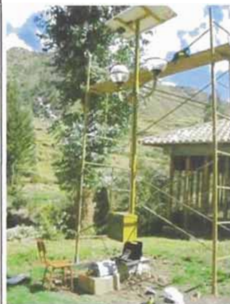
Fig. 12 Instalación de equipos (sensor de radiación, resistencias variables, multímetros, se muestran dos termocuplas colocadas en la parte superior e inferior del panel fotovoltaico)
