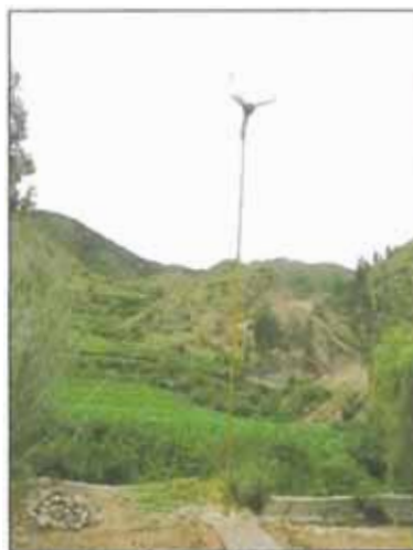
Fig. 32. Aerogenerador al término de la instalación instalado en CECADE, modelo tripala
