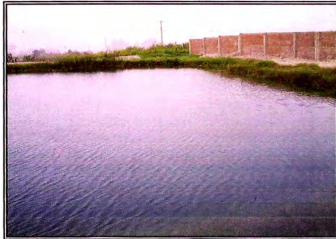
Foto N° 23. En la vista, se aprecia Pre-Sedimentador de 3000 m 3 de capacidad. Falta culminar el cerco perimétrico. Ubicación: Al pie del Canal Nuevo Imperial.
