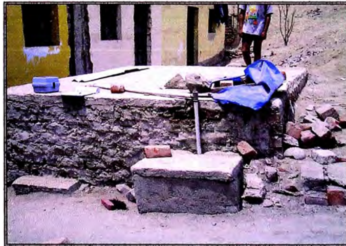
Foto N° 16. En la vista, se ve la Pileta que es abastecida con Camión Cisterna de la EPS. AA.HH. "Santa Rosa" (parte alta).
