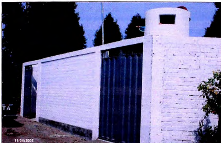
Foto N° 36. En la vista, se ve el frontis de la Cámara de Bombeo de Desagües “La Huaca”.
