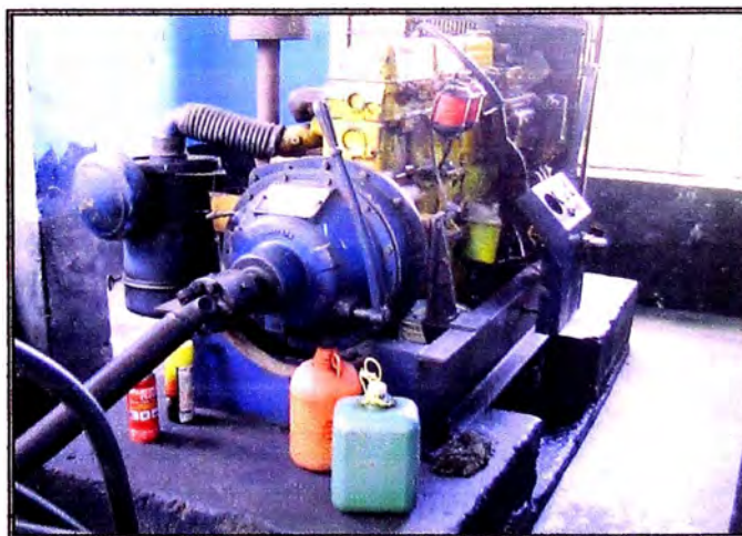
Foto N° 04. En la vista, se aprecia el Motor Petrolero que sirve para atender eventuales emergencias (Cortes del fluido eléctrico).
