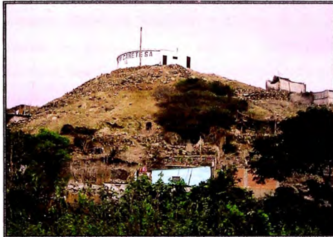
Foto N° 08. En la vista, se aprecia al Reservorio Apoyado (R400) de forma circular y 400 m 3 de capacidad. Estado: Regular.
