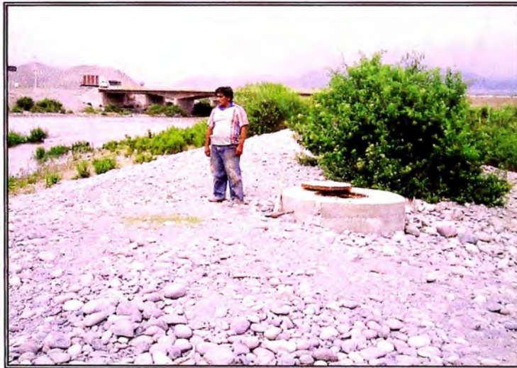
Foto N° 35. En la vista, se aprecia el buzón de llegada de la línea de impulsión que viene de la CBD La Huaca. El cuerpo receptor es el Río Mala, este recibe la descarga sin tratamiento y la conduce al receptor final, el mar.
