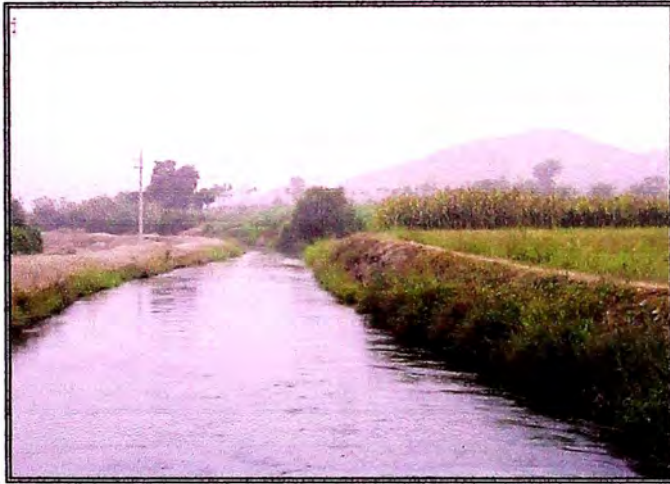
Foto N° 20. En la vista, se ve al Canal Nuevo Imperial, el cual alimenta a las Plantas de Tratamiento de Agua Potable de Alminares.
