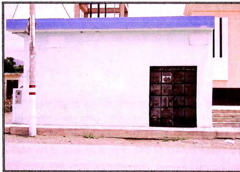
Foto N° 11. En la vista, se ve la Caseta del Pozo Artesanal N° 03. Ubicación: Anexo San Marcos La Aguada Estado: Bueno.
