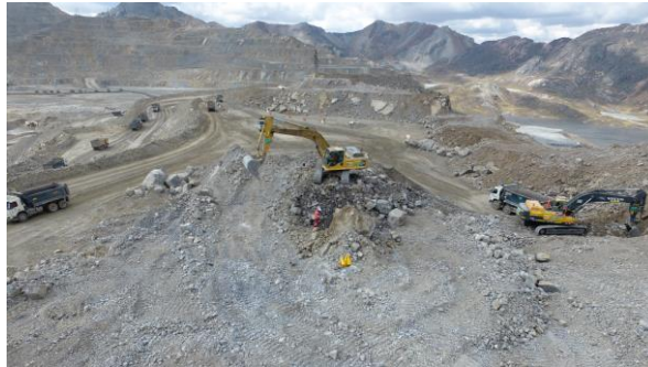
Figura N°6-14: Extracción de material Tipo 3 de una cantera de enrocado Fuente: Archivo Fotográfico Propio
