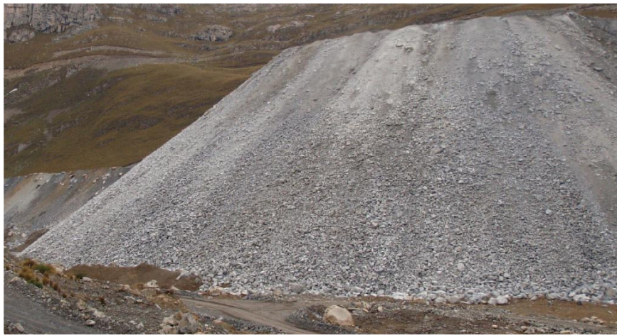
Figura N°2-2: Segregación de las partículas de mayor diámetro al pie de un depósito de desmonte de mina de 50 m de altura
