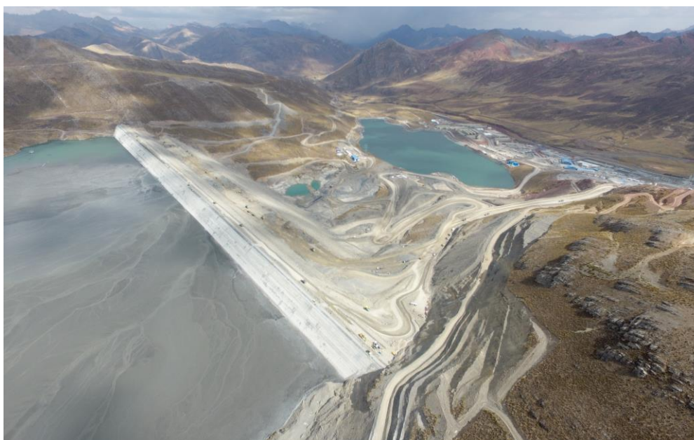
Figura N°6-1: Vista general del estado actual de la presa CFRD-caso de estudio.
