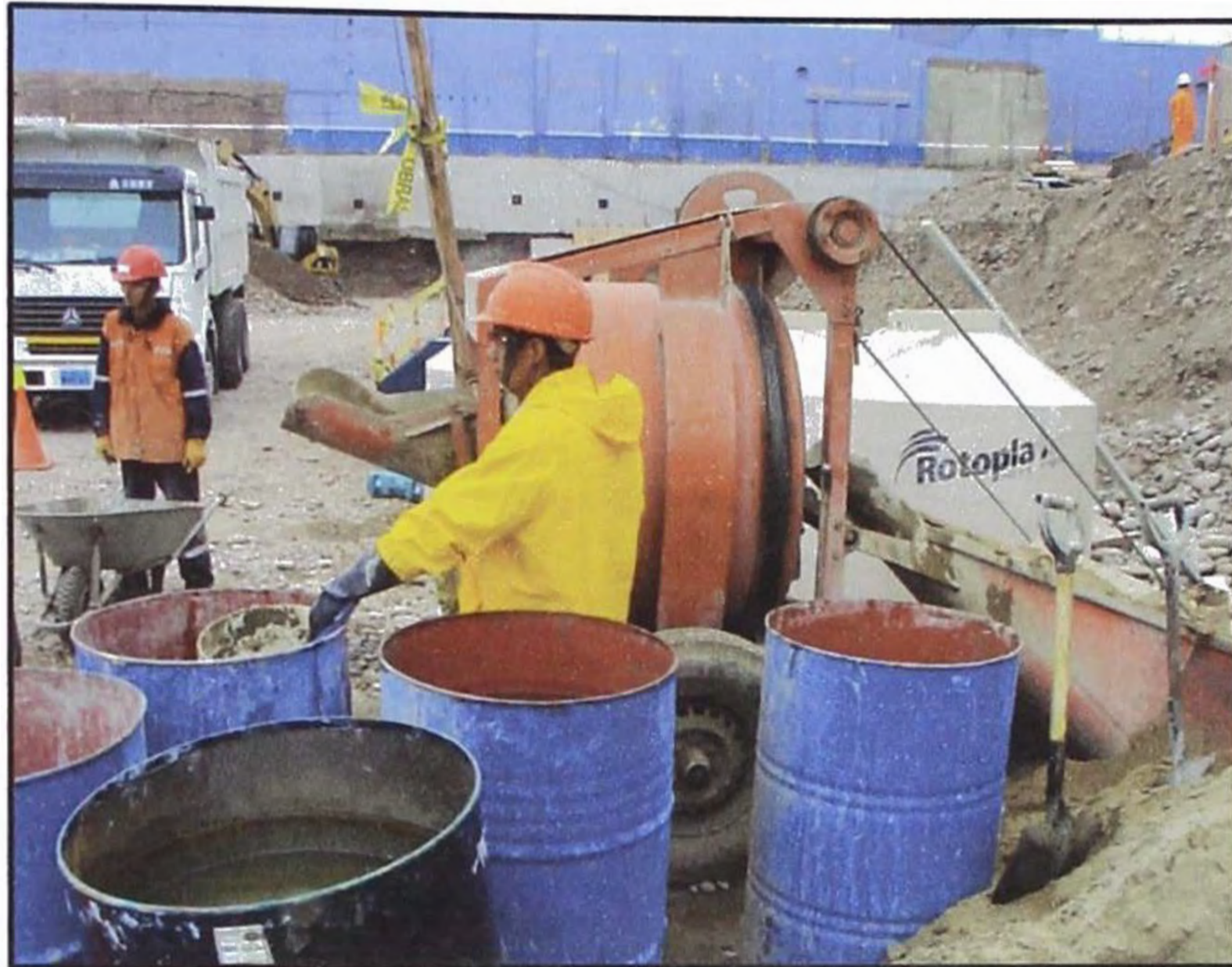
Fotografía: Ubicación de operario maquinista de mezcladora junto a cilindros con agua
