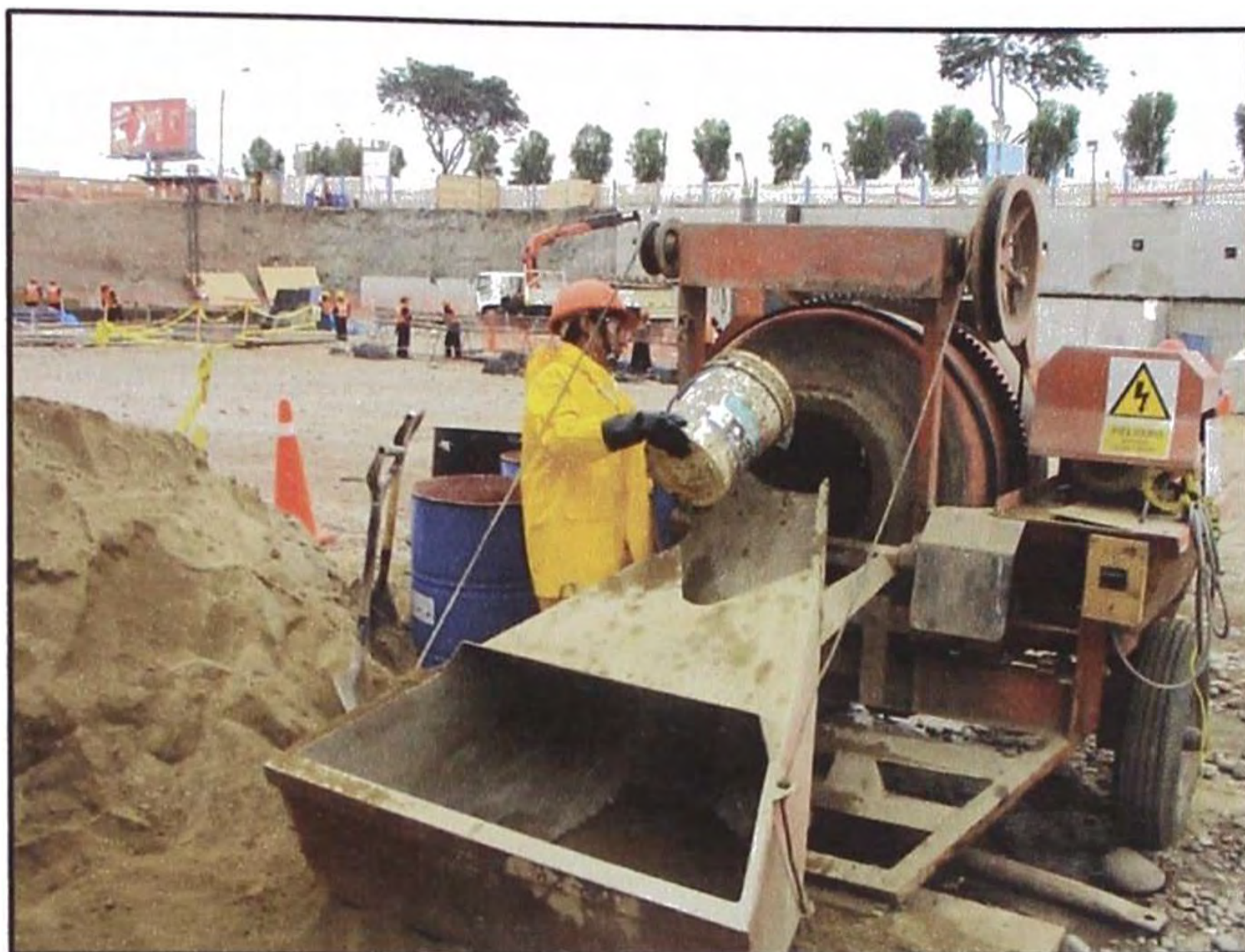
Fotografía: Operario Maquinista abasteciendo de agua por cavidad de ingreso de los agregados a la mezcladora
