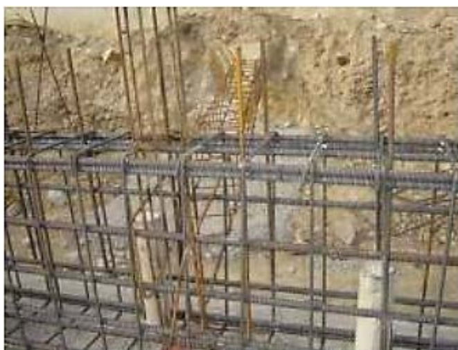
FIGURA 2.6: Micropilotes en cimentación (Barba, 2012)
