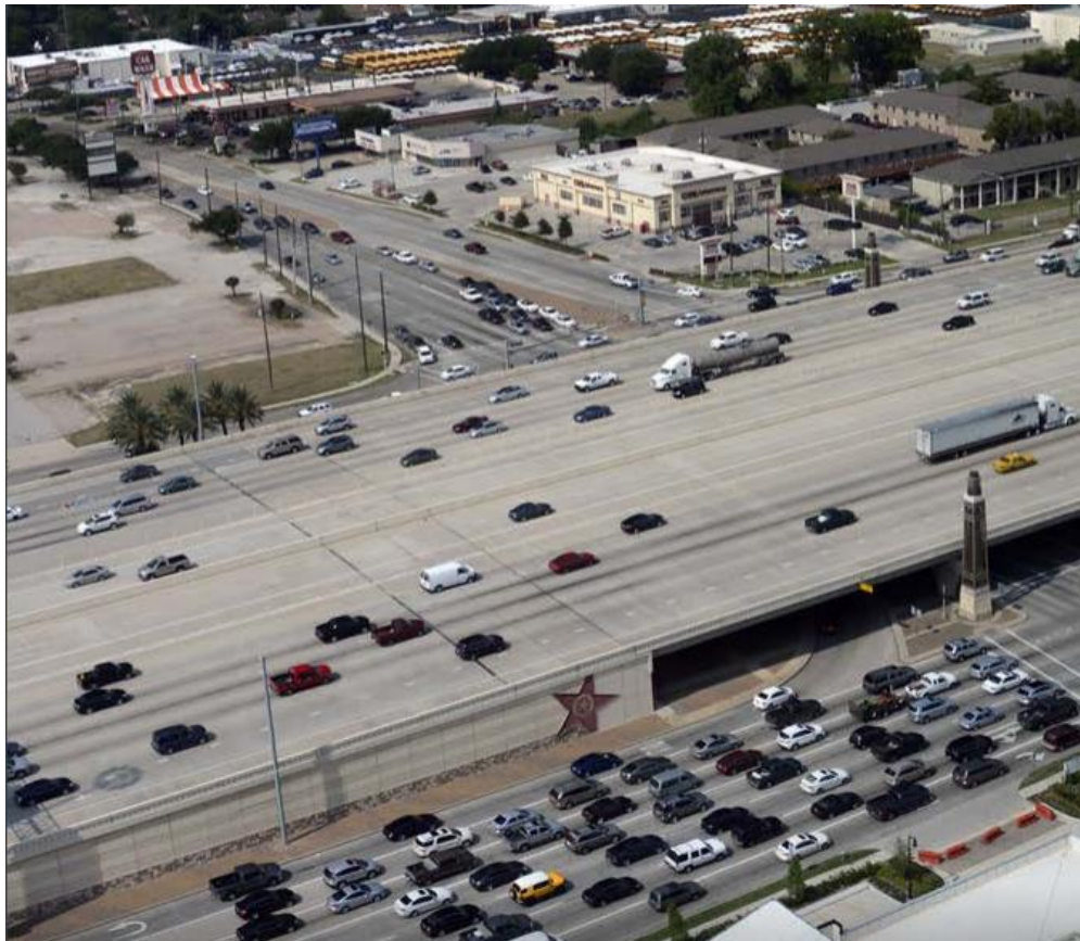
Figura 6 Autopista Houston, EEUU
