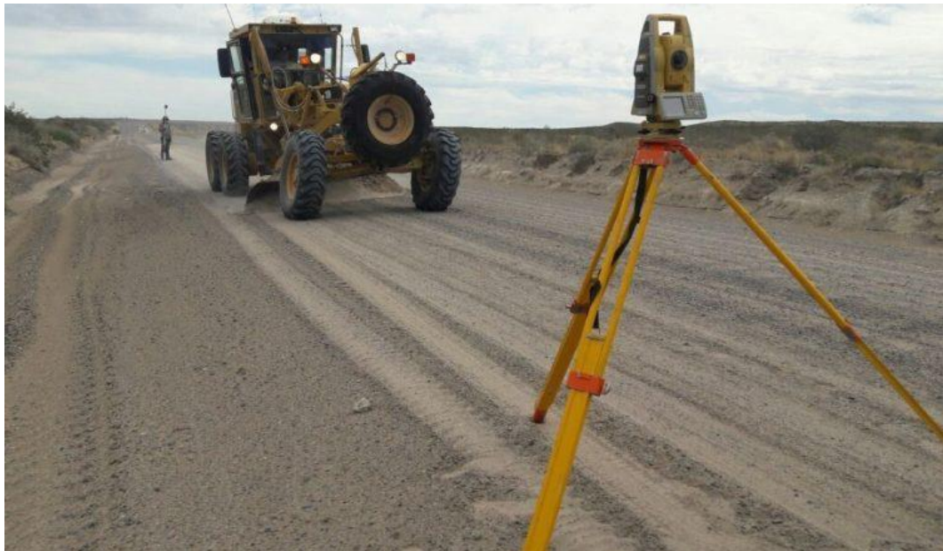
Figura 18 Control topográfico en conformación de bases granulares
