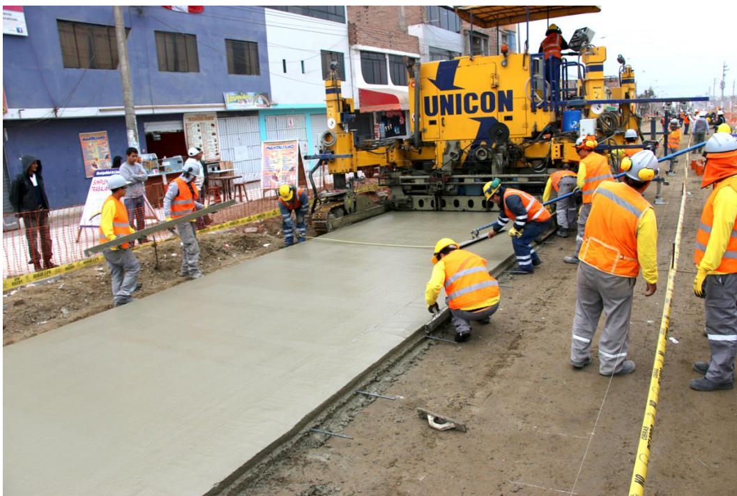
Figura 20 Pavimentación con encofrados deslizantes
