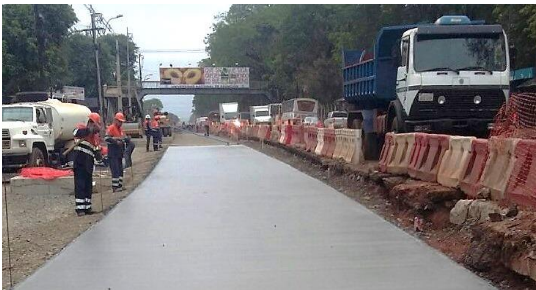
Figura 8 Pavimentación de vía principal del Metrobus en Paraguay
