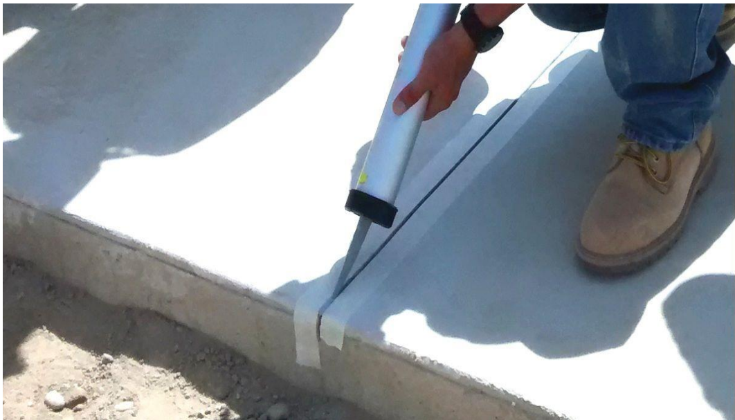
Figura 15 Etapa POST en la construcción de pavimentos rígidos (sellado de juntas)
