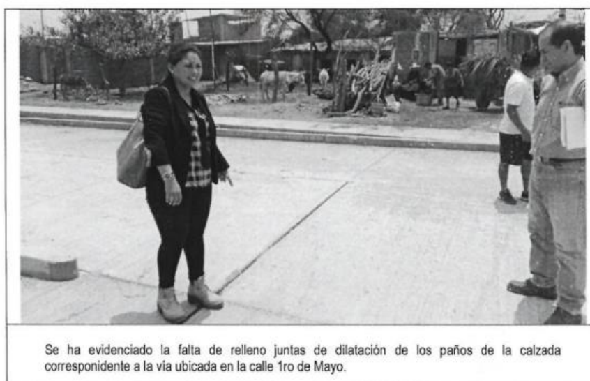
Figura 26 Inspección a trabajos de pavimentación
