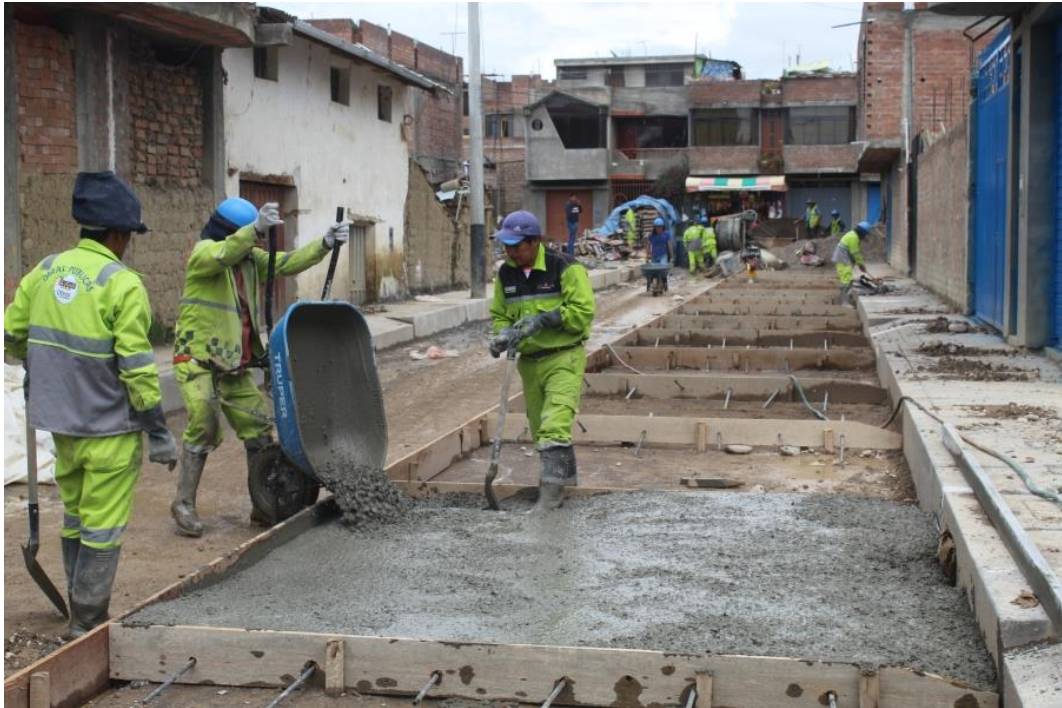
Figura 14 Etapa DURANTE en la construcción de pavimentos rígidos (vaciado de concreto)
