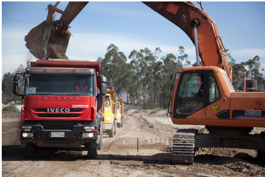
Figura 16 Corte y acarreo de material con fines de pavimentación
