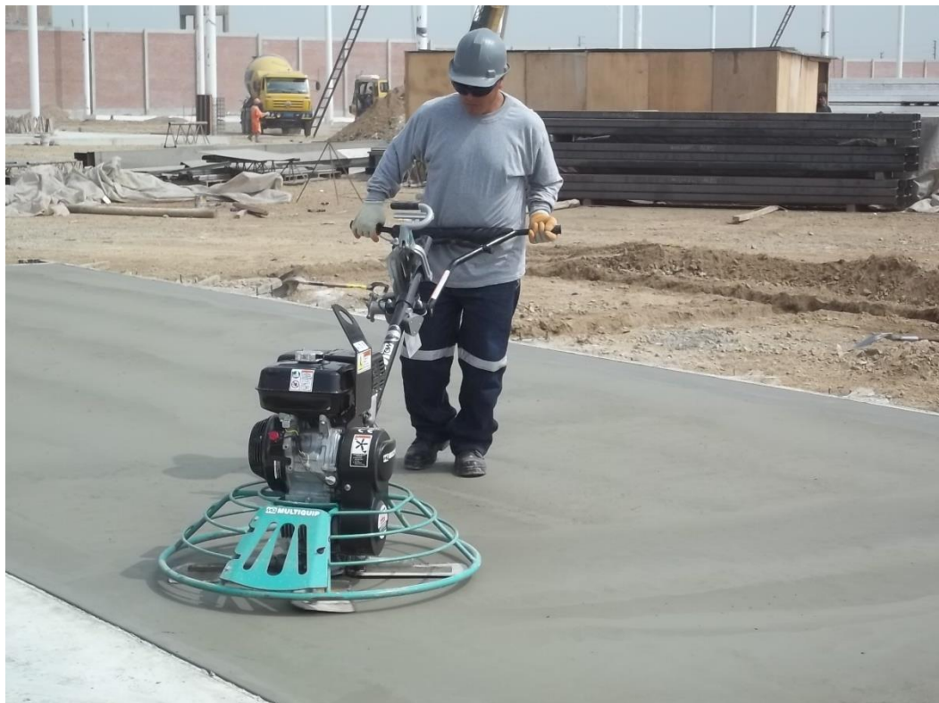
Figura 22 Acabado con alisadora mecánica simple
