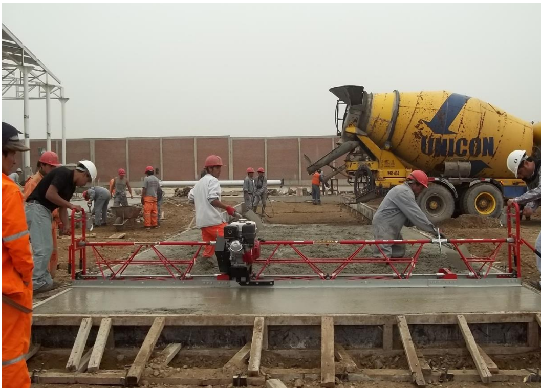
Figura 21 Extendido y nivelación de concreto con regla vibratoria
