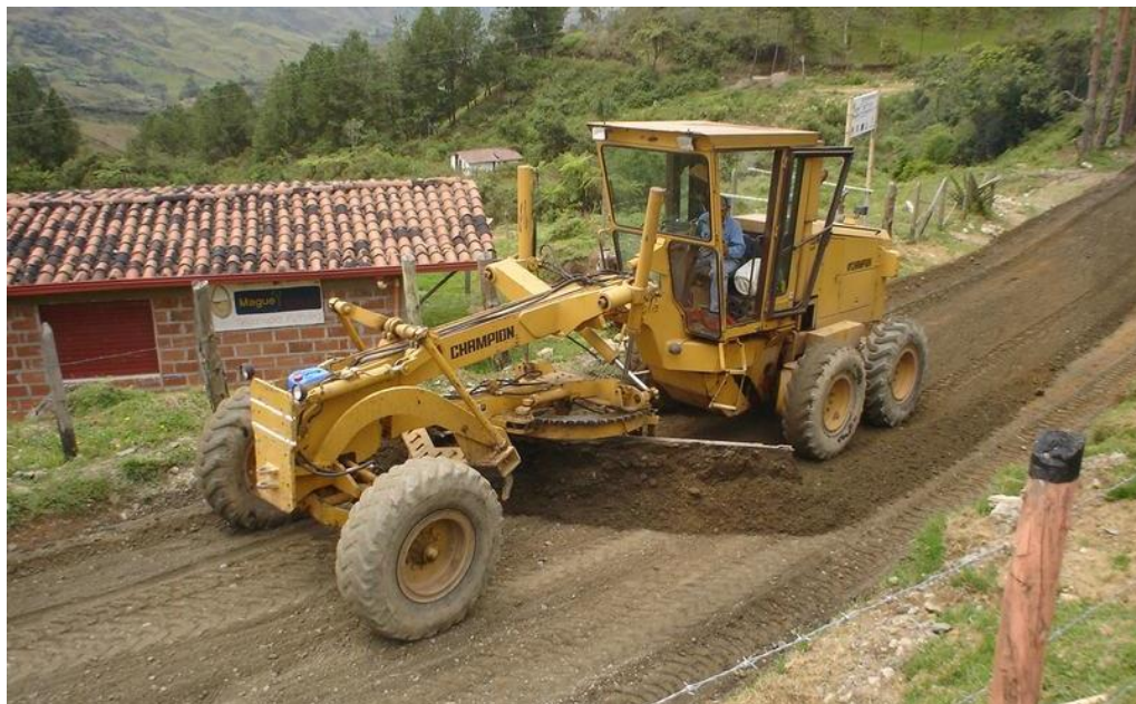
Figura 17 Conformación de base granular con motoniveladora
