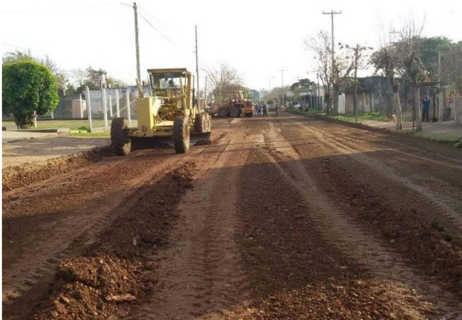
Figura 13 Etapa PRE en la construcción de pavimentos rígidos (nivelación del terreno)
