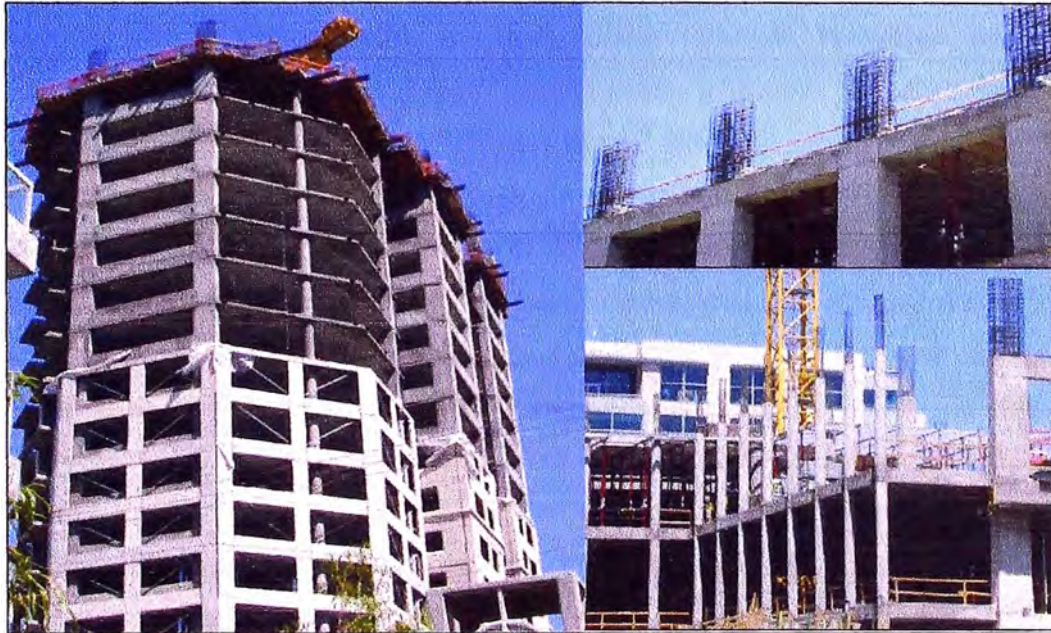
Figura 2.9 Pórticos Sísmicos y de Gravedad (8)
