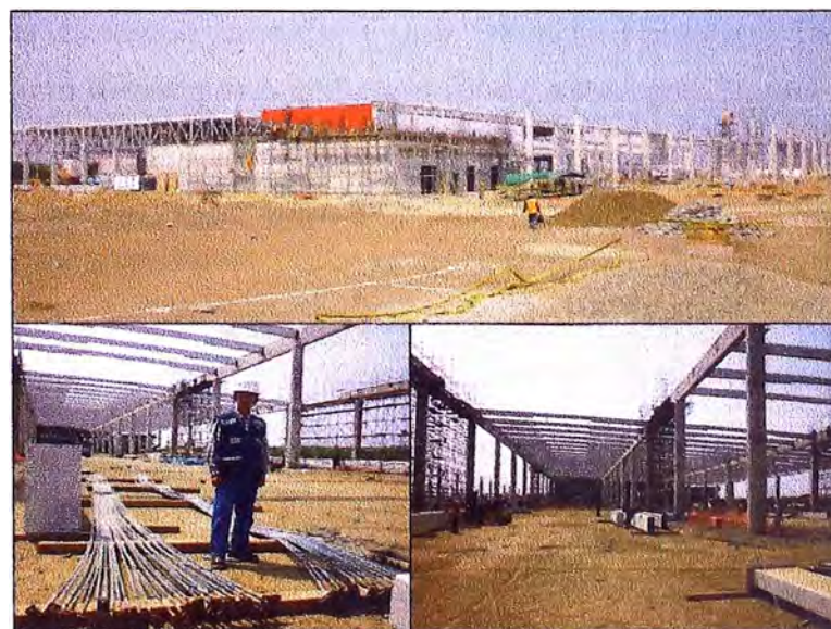
Figura 1.7 Pórticos Postensados - Corporacion Lindley Trujillo (27)
