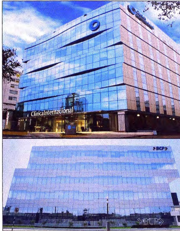
Figura 1.4 Entrepisos Postensados en Clínica Internacional y BCP (27)
