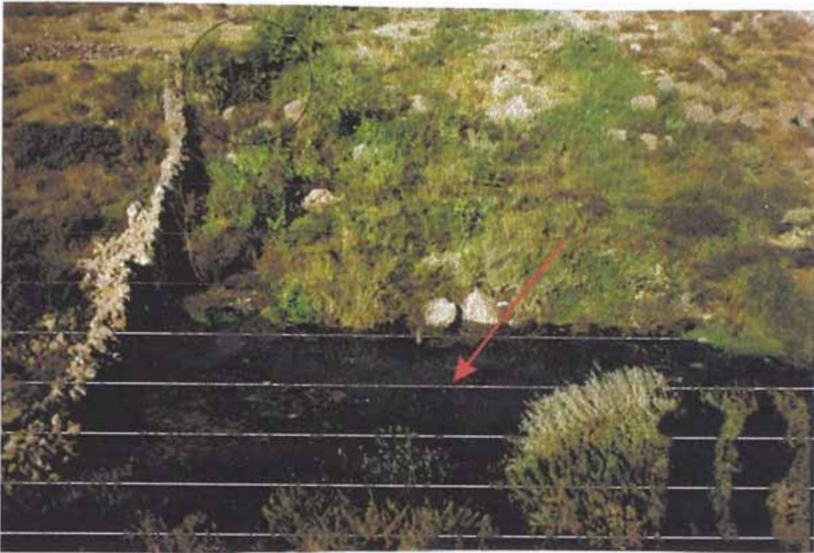
FOTO N° 11. Nótese la concentración de aguas servidas que proceden del pueblo de Characato, observándose el cambio de coloración grisácea, oscura.
