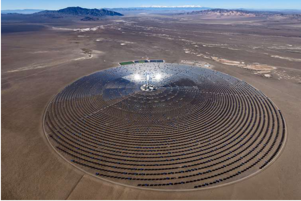
Figura 1: Proyecto Solar Crescent Dunes, Las Vegas, EE.UU.
