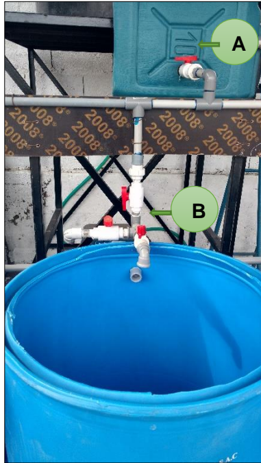
Fotografía N° 2 Tanque ecualizador (A) y sistema de regulación de caudal del FLA (B)
