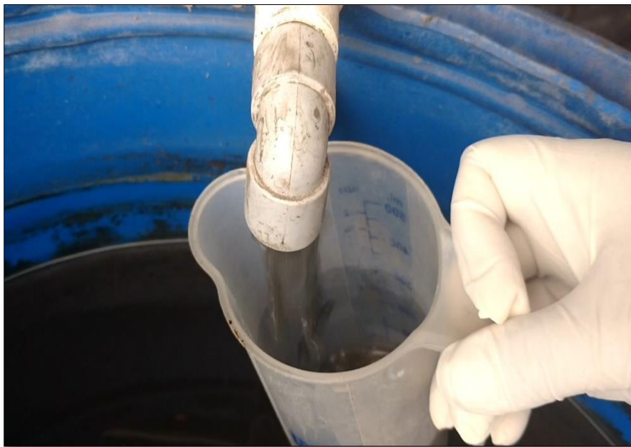
Fotografía N° 17 Limpieza de la válvula distribuidora de caudal, la alta concentración de sólidos en suspensión fue debido a que las válvulas trabajaron con aperturas mínimas
