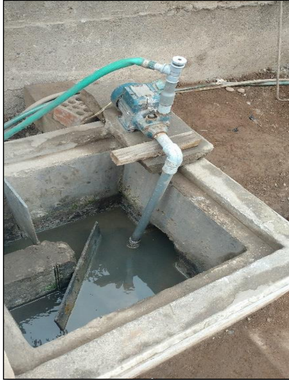
Fotografía N° 1 Caja de Concreto de donde se bombeo el agua residual pretratada hacia el presedimentador de la PTAR Piloto
