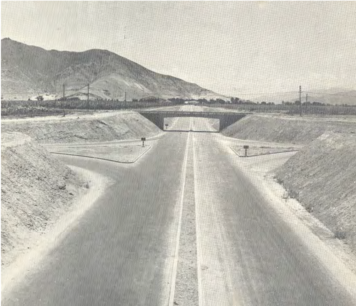
Fig. 130. Paso a desnivel en Circunvalación, principios de los 50s.
