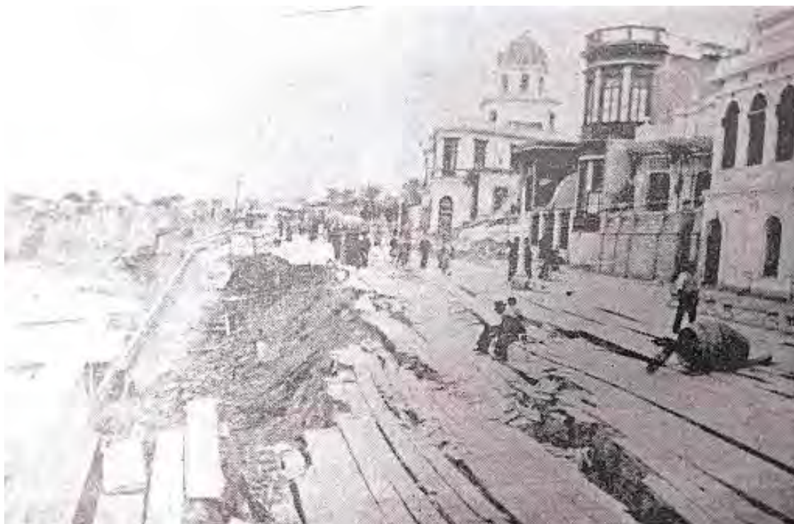
Fig. 115. Malecón de Chorrillos tras el terremoto de mayo de 1940.
