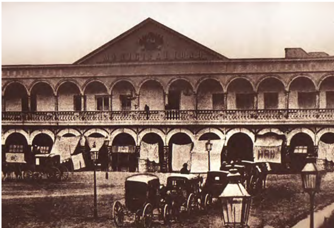
Fig. 45. Antiguo local municipal que fue destruido por un incendio y que reconstruye Harth-Terré.
