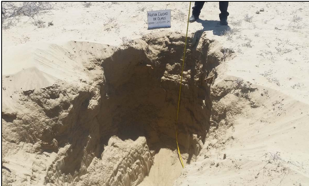
Foto N°2.1. Excavación en la zona de estudio (Fuente propia).
