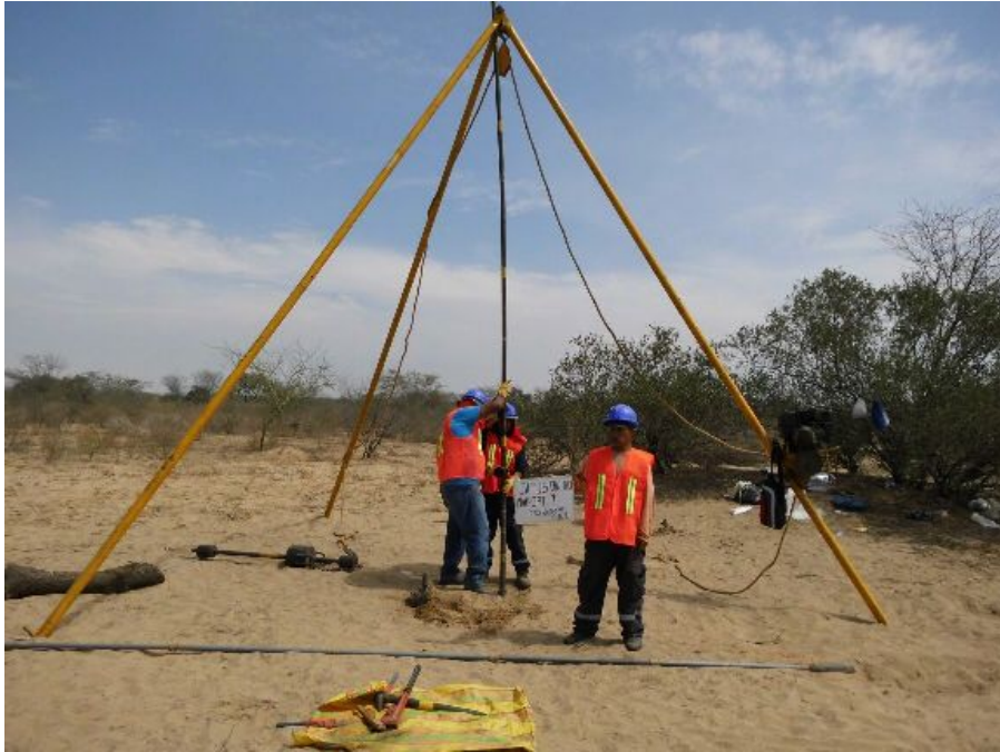
SPT-1: PTAP (Planta de Tratamiento de Agua Potable)
