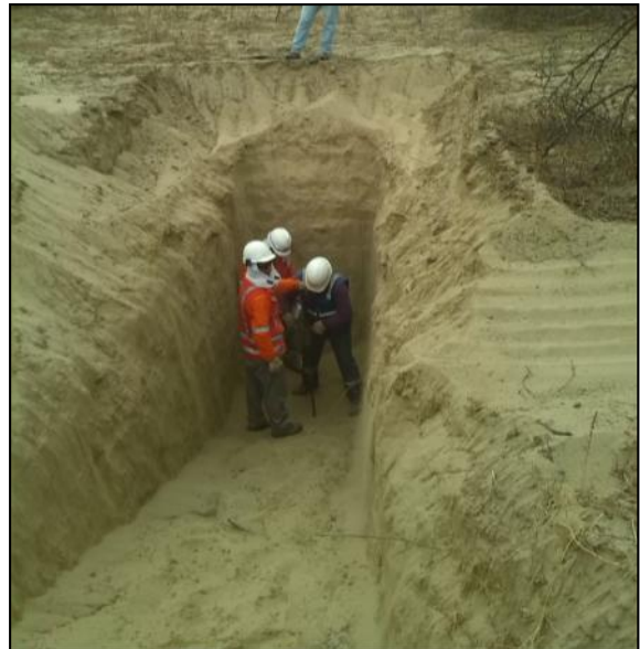
Foto 7. DPL-5 de 0.50 m. de penetración, realizado en un calicata de 2.50 m de profundidad, ubicado en PTAP
