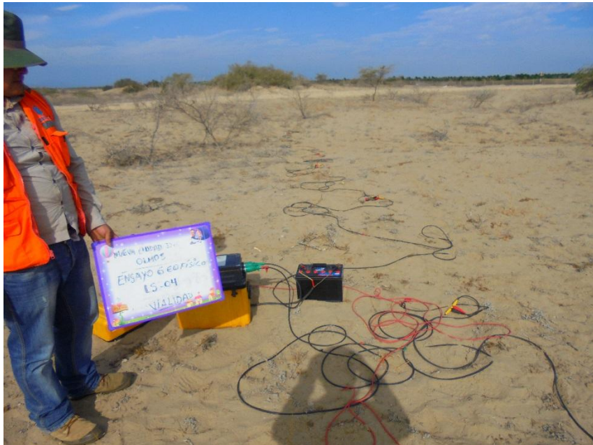
Foto 12. Ensayo de refracción sísmica vialidad LS-04
