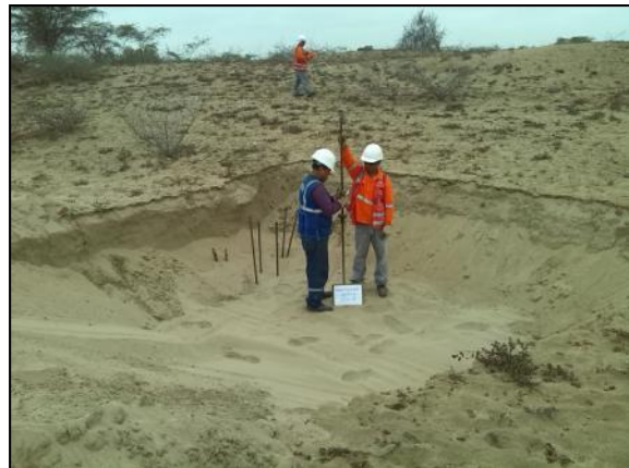
Foto 11. DPL-2 de 6.00 m. de penetración, realizado en un calicata de 1.00 m de profundidad, ubicado en REP 4
