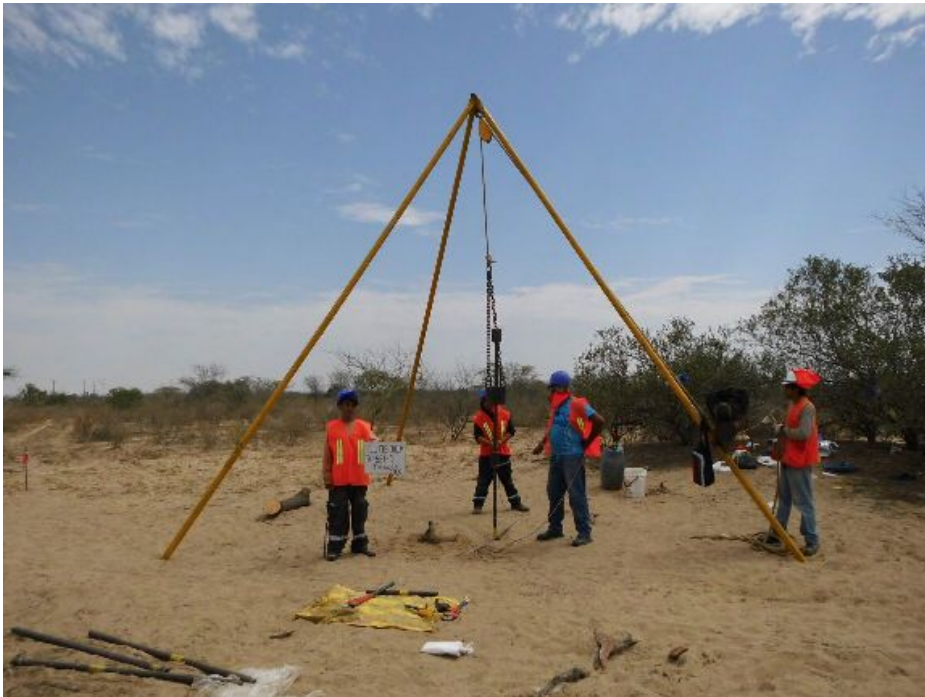
SPT-1: Donde se llegó a una profundidad de exploración de 8.45m.
