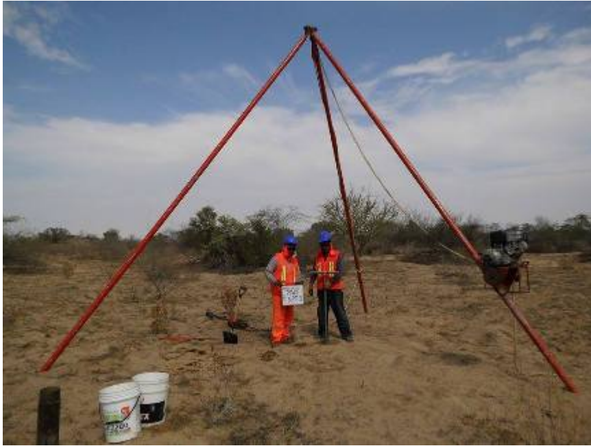
Otra vista panorámica del Ensayo de Penetración Estándar SPT-3/PTAP (Planta de Tratamiento de Agua Potable).
