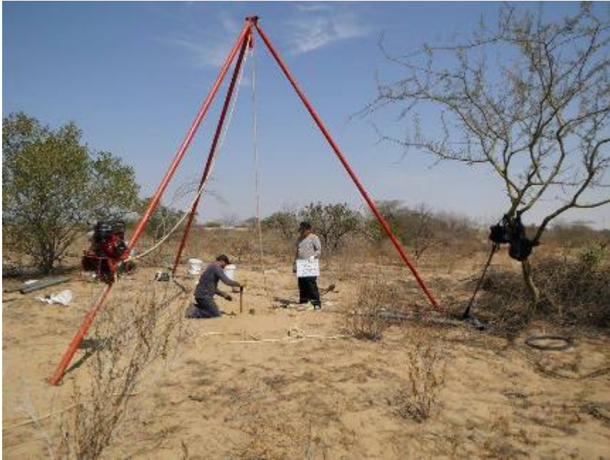
Otra vista panorámica del Ensayo de Penetración Estándar SPT-2/PTAP (Planta de Tratamiento de Agua Potable).
