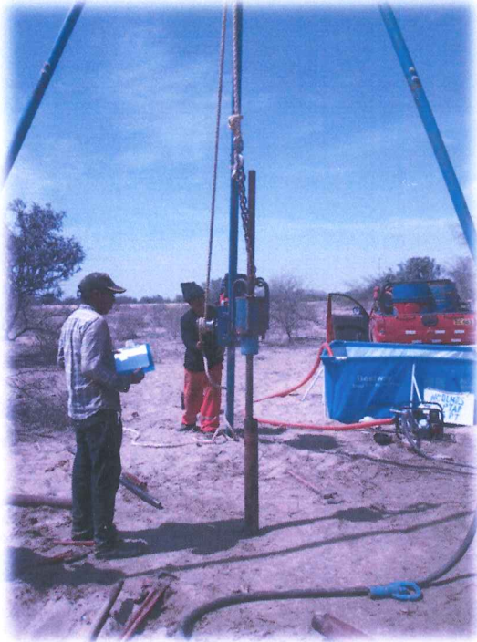
VISTA FOTOGRAFICA DONDE SE OBSERVA EL ENSAYO DE SPT 01
