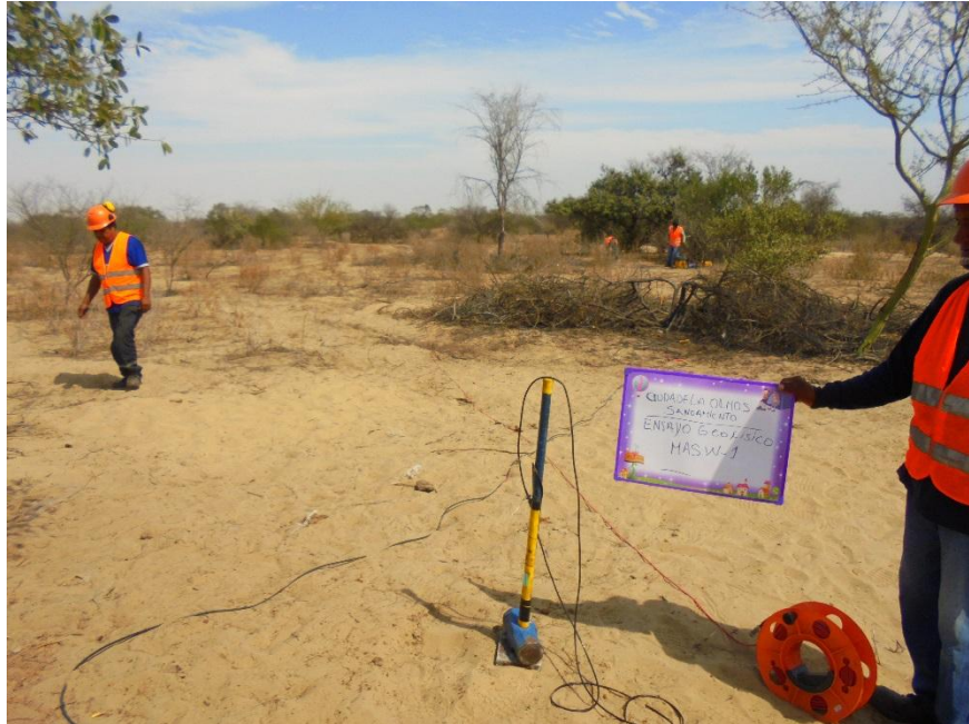
Foto 1. Ensayo MASW – 01 en planta de tratamiento de agua potable PTAP.
