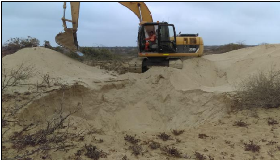
Foto 4. Calicata C-01 de 4.00 m. de profundidad, ubicado en el Reservorio 4. Las paredes de la calicata se colapsan e impiden seguir excavando.
