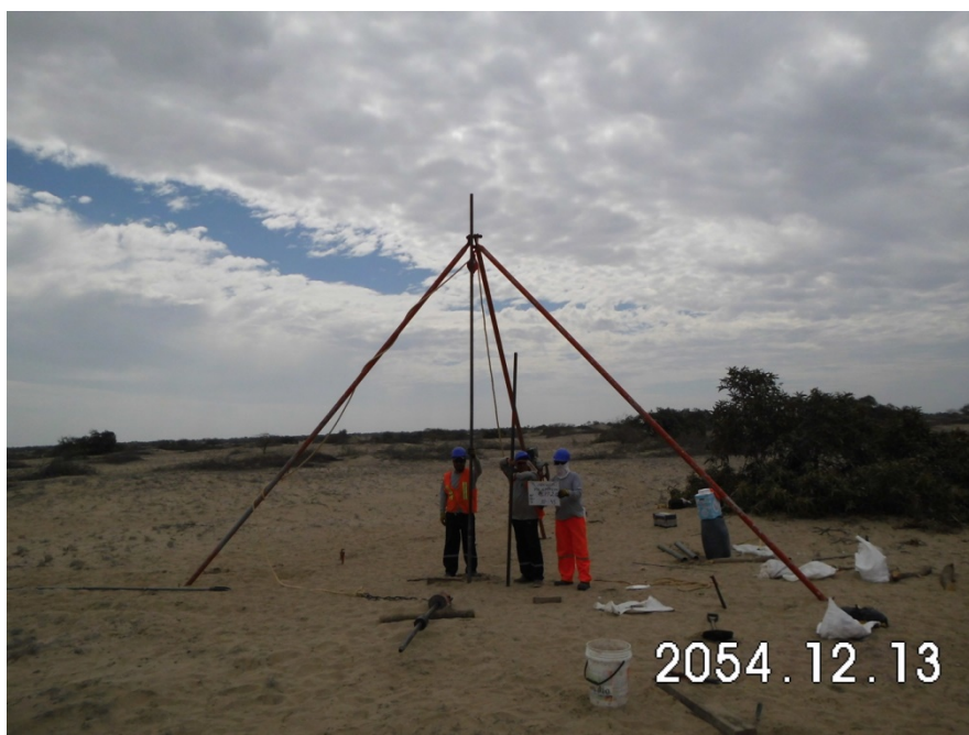
Otra vista panorámica del Ensayo de Penetración Estándar SPT-28/Eje B2 - Eje D5.
