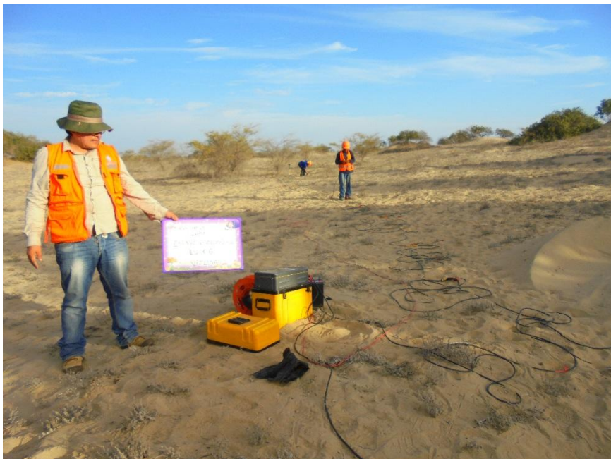
Foto 14. Ensayo de refracción sísmica vialidad LS-06
