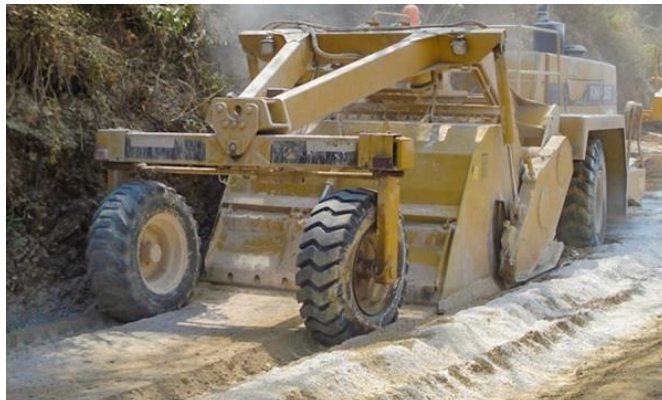
Figura N° 10: Estabilización de Suelos con Cal
