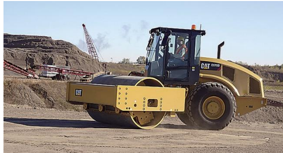
Figura N° 9: Proceso de estabilización en un suelo con maquinaria
