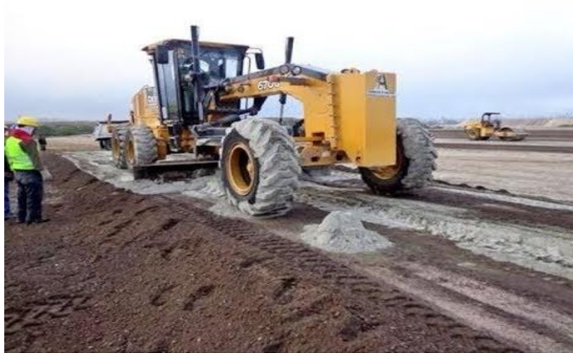
Figura N° 11: Estabilización de suelos con cemento
