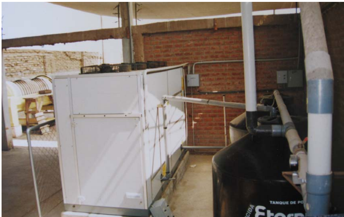
Figura 1.7. Vista posterior de la máquina PADOVAN y los tanques de agua TA-1 y TA-2.
