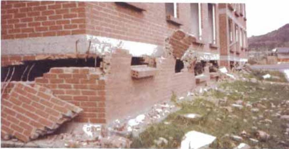
Figura 4.14.- Colapso del primer piso de un edificio de albañilería armada de 04 pisos, en sismo de Popayán – Colombia.
