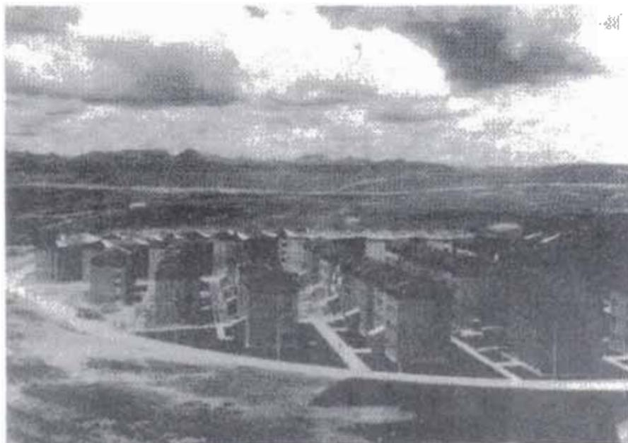
Figura 1.13.- Edificios de 3 y 4 pisos en Tintaya, Cusco, Perú construidos a 4000msnm de albañilería armada alveolar de 9 y 19 cm. de espesor. La resistencia de la albañilería fue de 6Mpa a la compresión.
