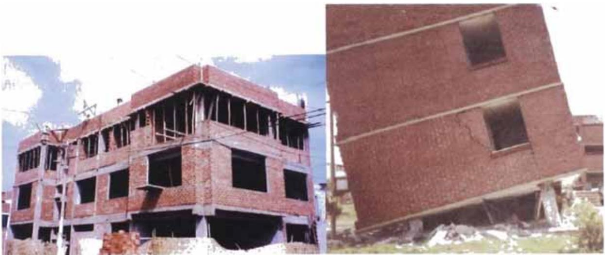
Figura 4.6.- Típica configuración en muchas viviendas primer piso libre de muros y a partir del segundo aparecen los muros, esto genera el denominado problema de “piso blando”.
