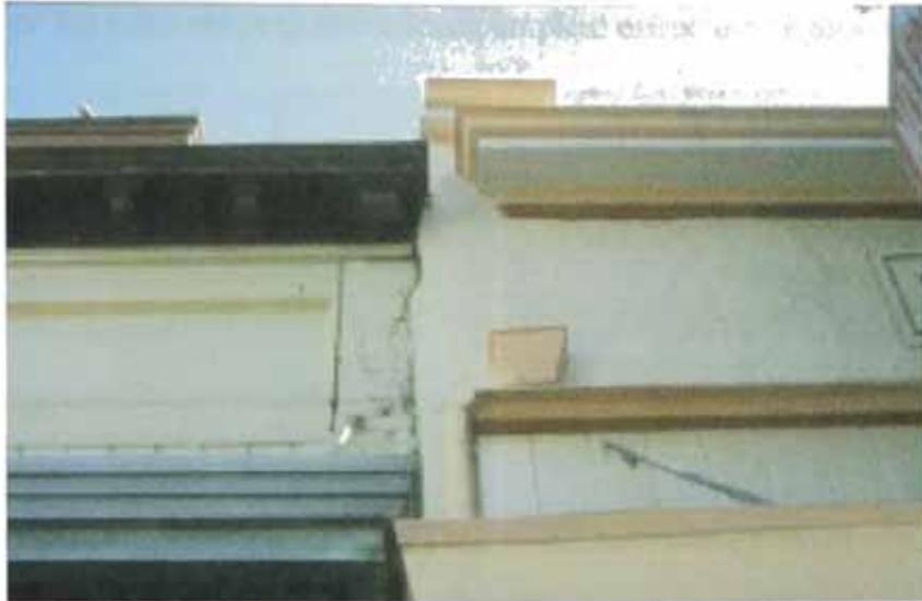
Figura 4.5.- Choque de dos edificaciones vecinas por falta de junta sísmica.
