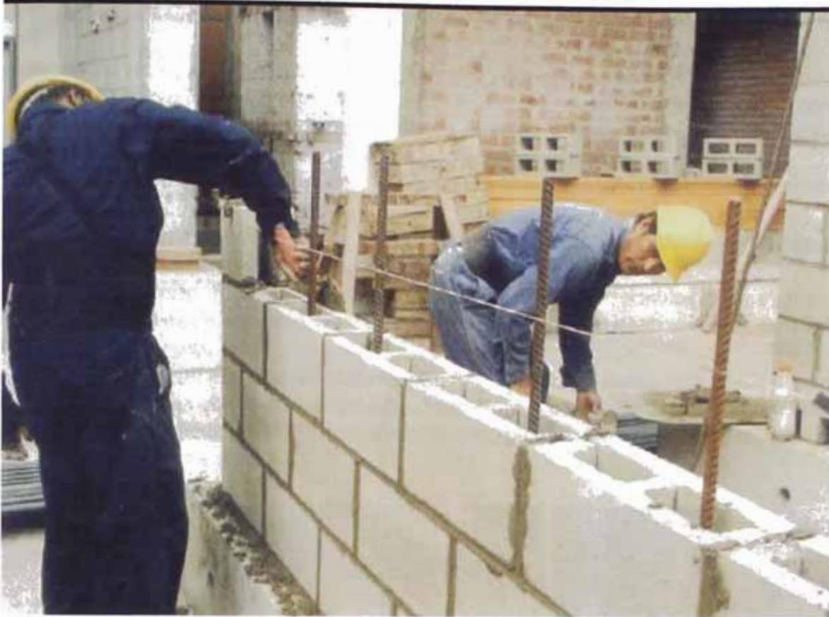
Figura 2.4- Procedimiento constructivo de un Muro Armado de Bloques de concreto.
