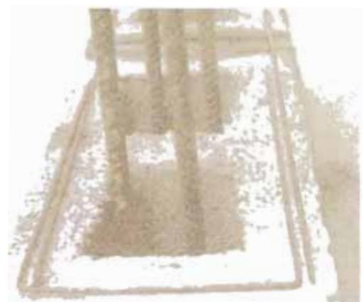
Figura 3.13.- Escalerilla y horquillas en los extremos empleados en los bloques de concreto.
