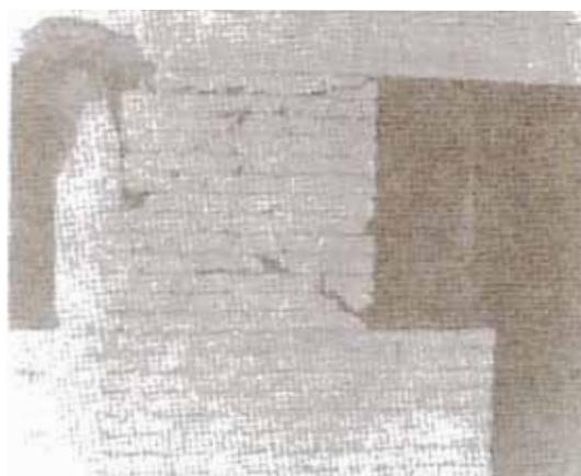
Figura 4.8.- Confinamiento típico por una columna en muros con vanos nótese la propagación sin control de las grietas.
