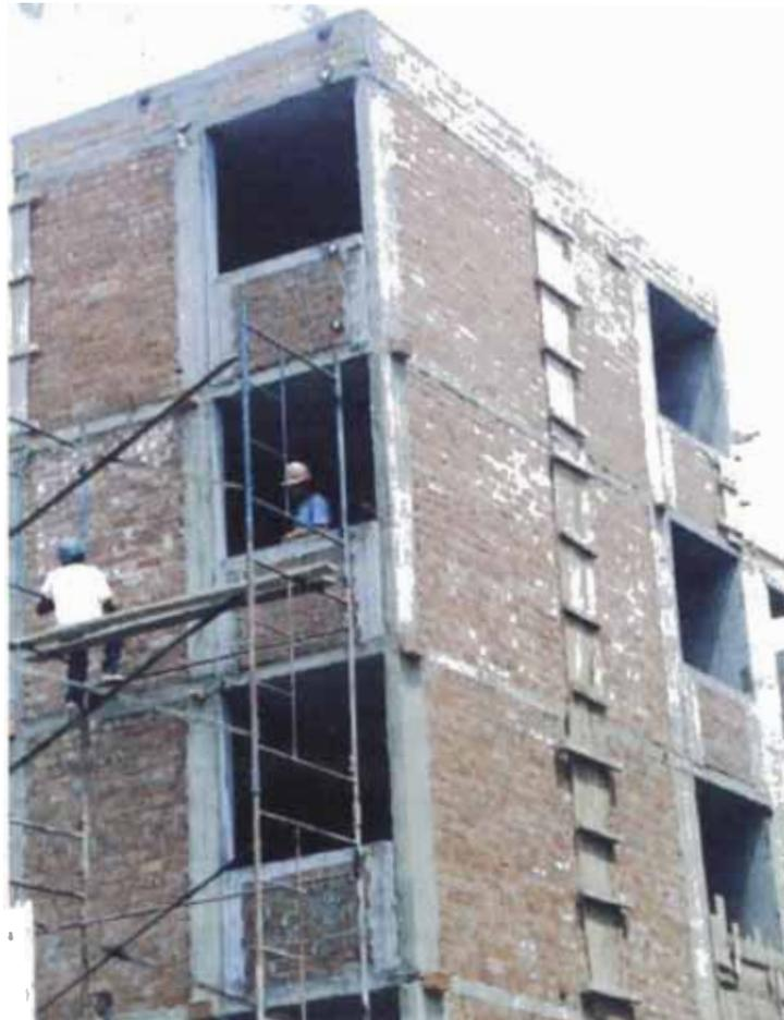
Figura 2.8- Edificación típica de muros de albañilería confinada con unidades de arcilla.
