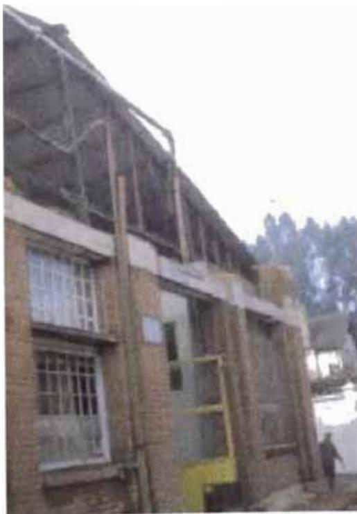
Figura 4.12.- Falla de un muro de la parte superior de un edificio por mala conexión entre muro y techo.
