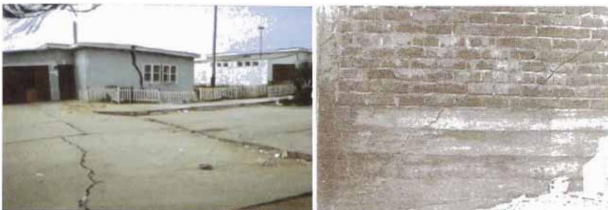
Figura 4.7.- Vivienda en Chimbote sismo de 1970 licuefacción del suelo, y cimiento armado sobre suelos colapsable en ventanilla.
