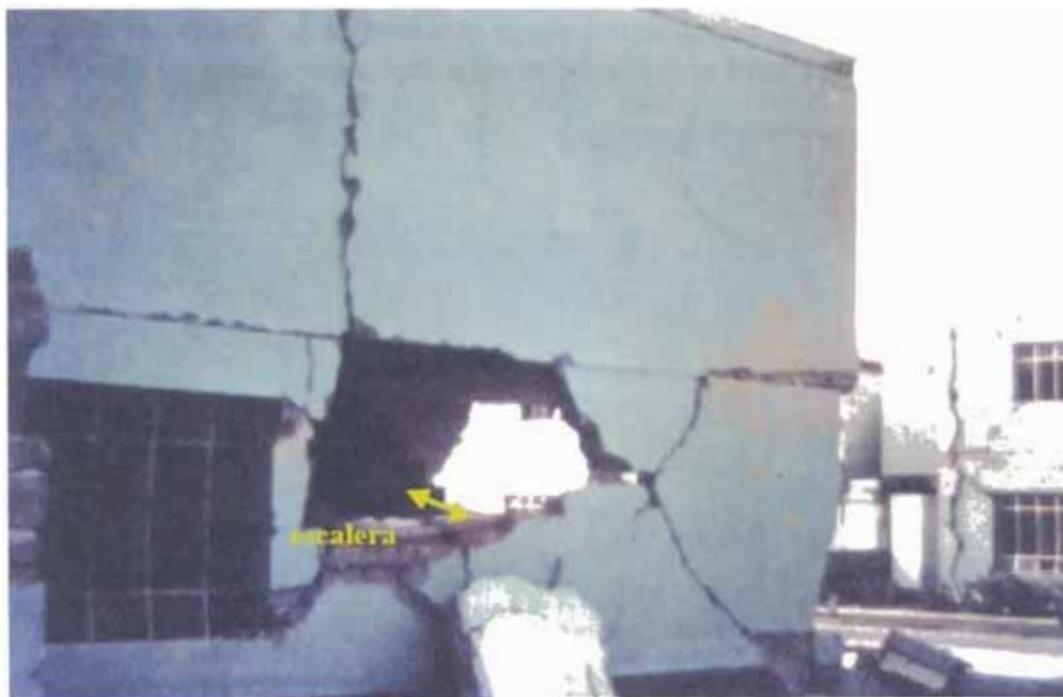
Figura 4.4.- Acción de la escalera perpendicular al plano del muro.
