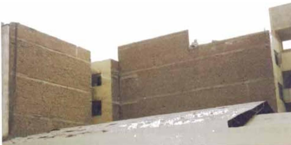
Figura 2.1.- Vista de edificaciones con Muros No Reforzado o Albañilería Simple.
