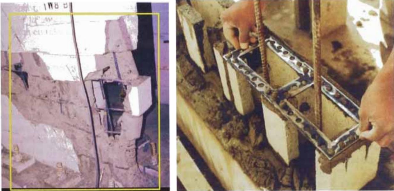
Figura 4.17.- Colapso explosivo del talón de un muro típico, y reforzamiento con planchas metálicas de confinamiento.
