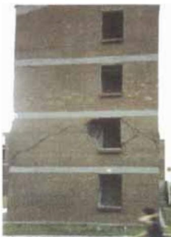
Figura 4.2.- Agrietamiento diagonal de muros, por falta de confinamiento.
