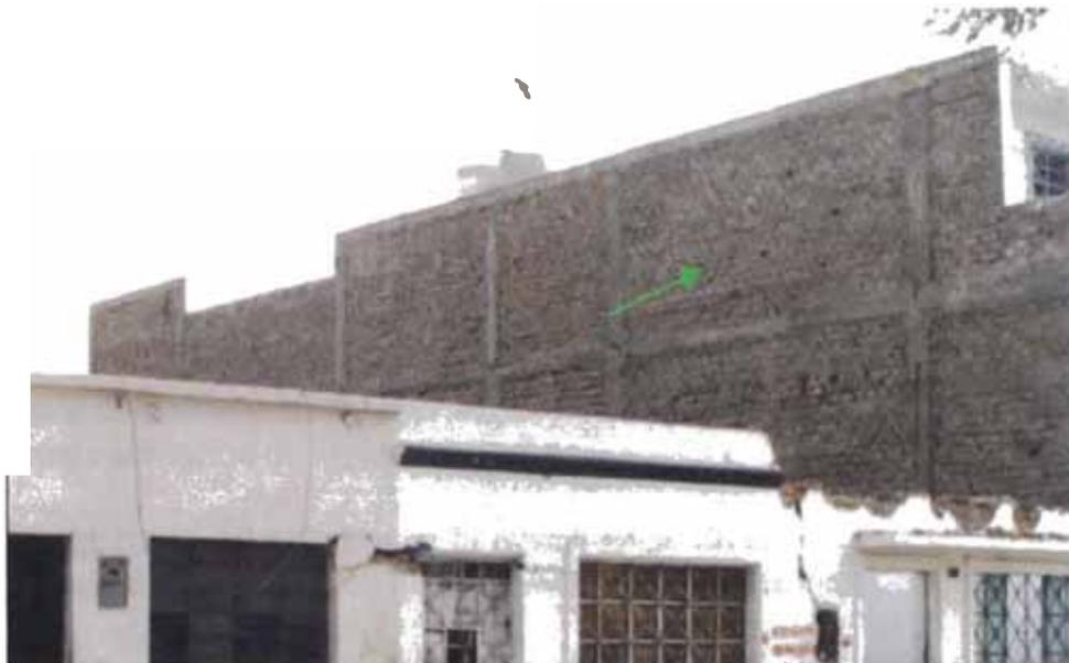
Figura 4.9.- Columnas de confinamientos con espaciamentos excesivos, generan debilidad al muro ante cargas fuera de su plano.
