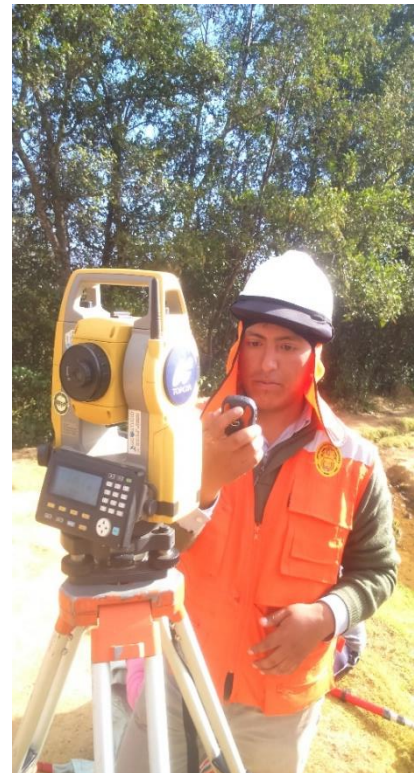
Fotografía 7: verificacion de coordenadas
