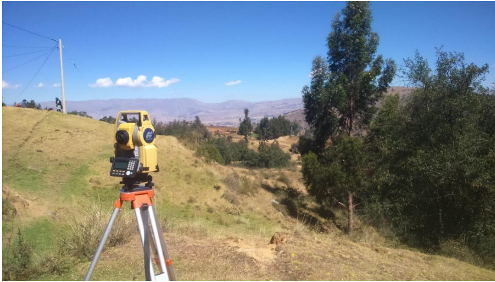
Fotografía 1: inicio del trabajo con estación total
