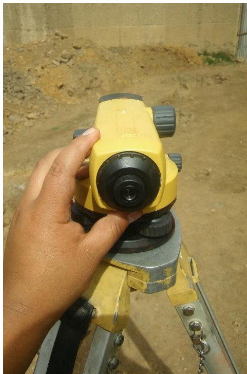
Figura 4. 5 Nivelación poligonal de trabajo Fuente Propia
