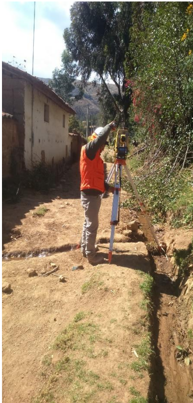
Fotografía 4: nivelacion del equipo
