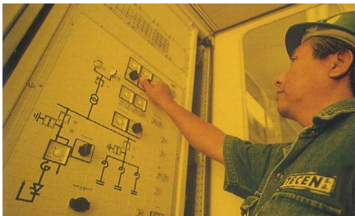
FIG. 6. 16 Maniobra en Tableros Eléctricos
