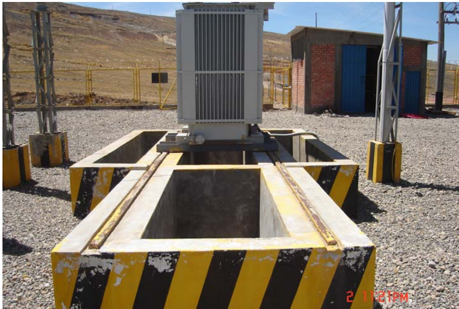
La FIG. 7.1 Muestra las obras civiles para la instalación del transformador de potencia.
