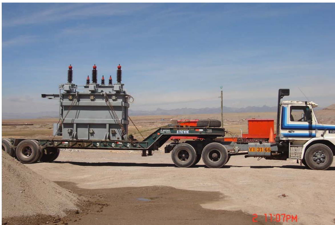
FIG 5.1 Transformador de 6 MVA instalado en la Subestación Marcapunta Oeste.
