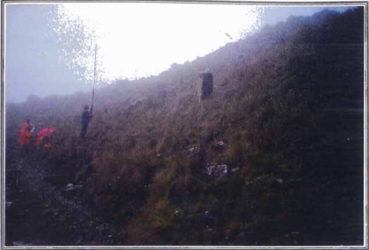
FOTO N° 3 : Levantamiento Topografico, observese la pendiente del terreno, y el frio en la zona es en ocasiones bajo cero, vegetación predominantemente (ICHU).
