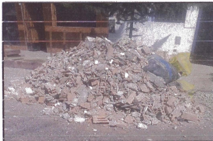
Foto N°02: Residuos de Demolición para la Remodelación de una Vivienda
