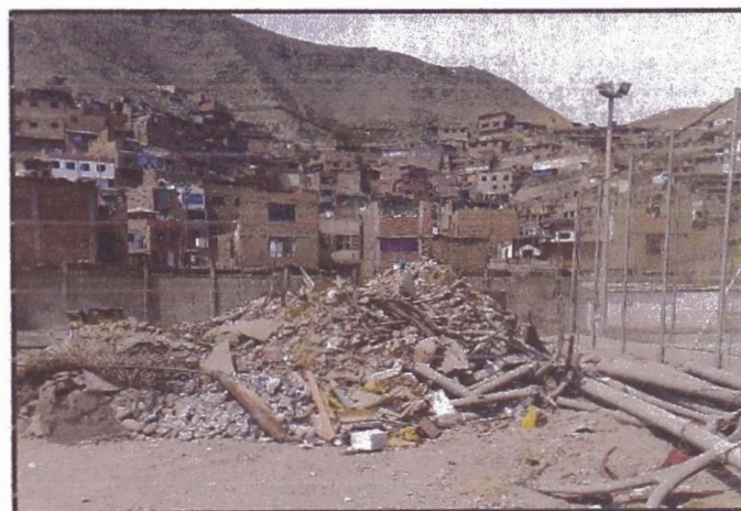
Foto N°03: Residuos de Construcción y Demolición (RCD) del CIU-UNI
