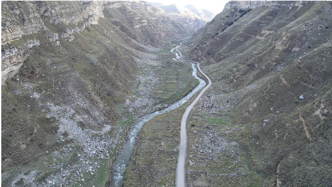
Figura N° 53 Eje del proyecto cerca de la localidad de Huari (3778 m.s.n.m.). Fuente: Elaboración propia.
