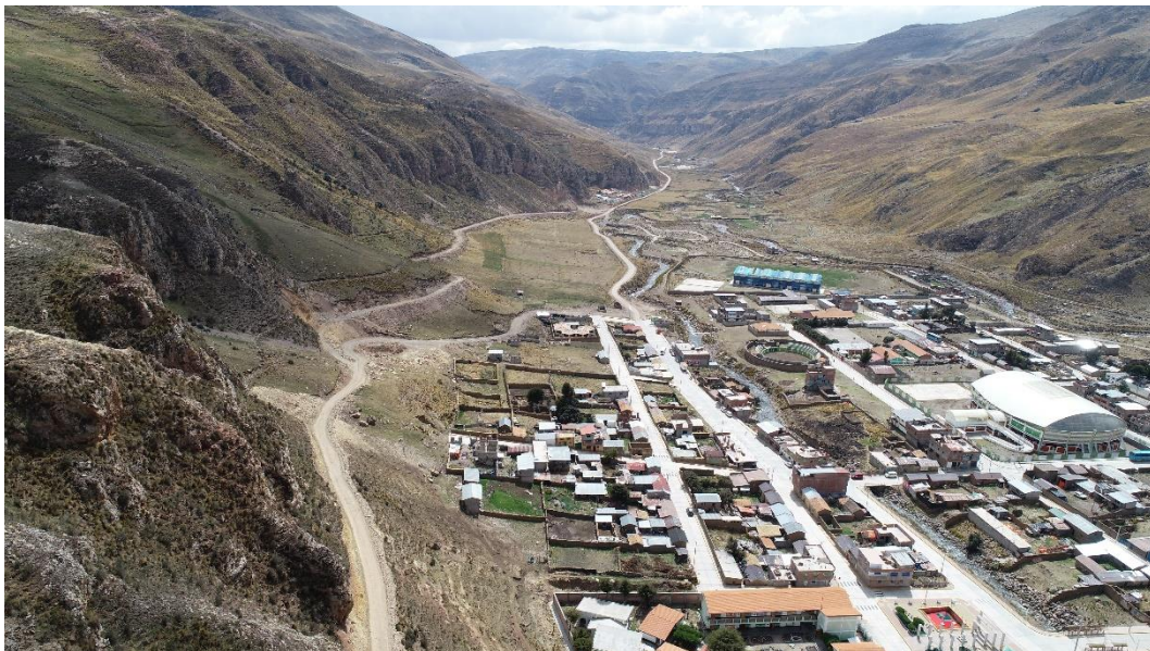
Figura N° 54 Eje del proyecto a un lado de la vía y de la localidad de Huayhuay (4010 m.s.n.m.) Fuente: Elaboración propia.
