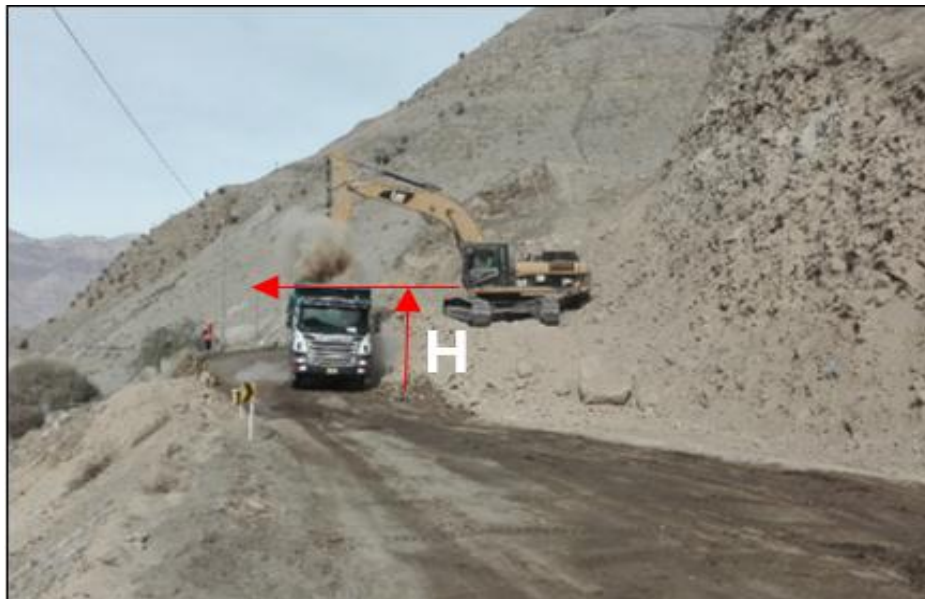
Figura N°5.12 Proceso correcto de carguío de material suelto con la excavadora.
