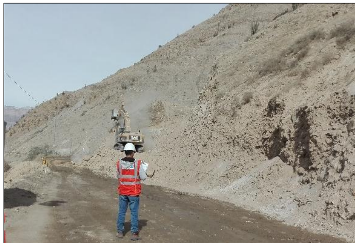
Figura N°5.6 Medición de las actividades en corte material suelto. Fuente: Elaboración propia.
