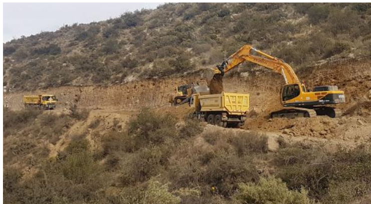
Figura N°5.15 Carguío de material suelto en una ruta alterna. Fuente: Elaboración Propia
