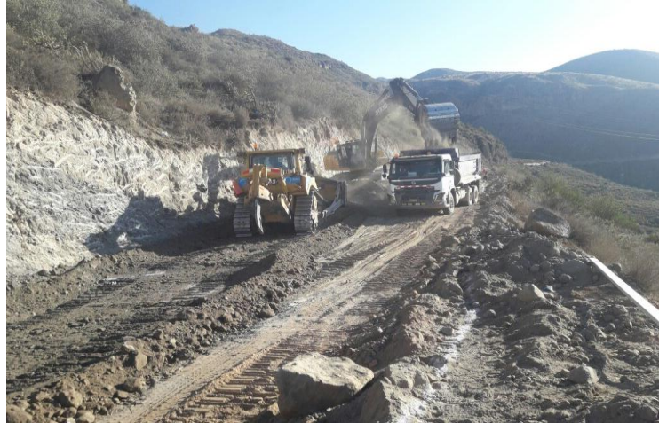
Figura N°5.13 Proceso correcto de carguío de material suelto con la excavadora.
