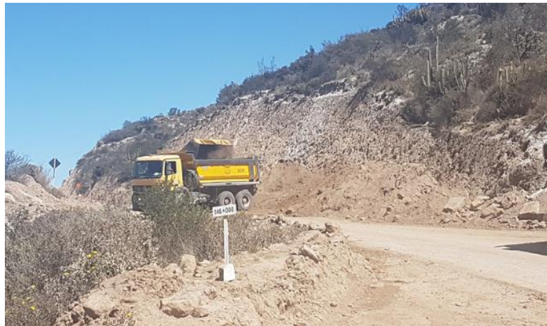
Figura N°5.14 Proceso de carguío de material suelto con cargador frontal.
