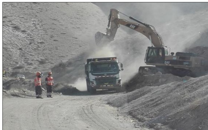
Figura N°5.7 Medición de las actividades en corte de talud. Fuente: Elaboración propia
